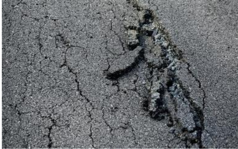
Şekil 22. Kaplama tabakasında meydana gelen sökölme (URL-4)
