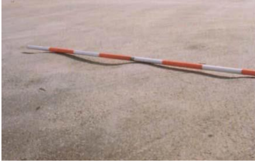
Şekil 19. Kaplama tabakasında görülen ondülasyonlar (Yılmaz, 2016)
