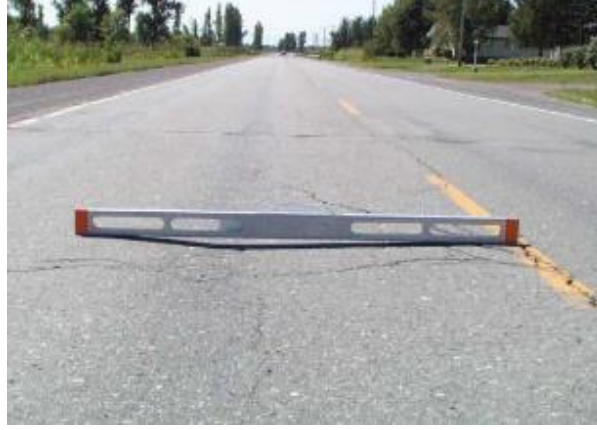
Şekil 17. Tekerlek izi deformasyonu (URL-3)
