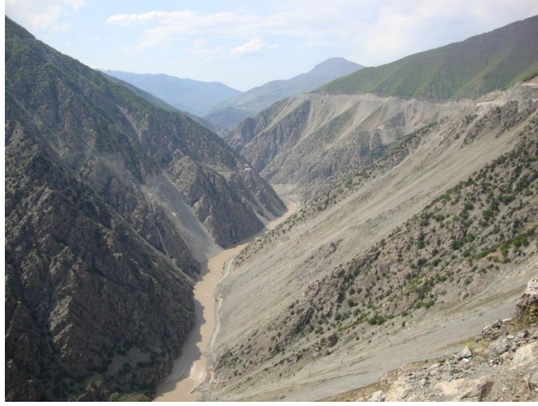
Şekil 26. Deriner Barajı nedeniyle sarp arazide yapılan yol çalışmasından bir görünüm
