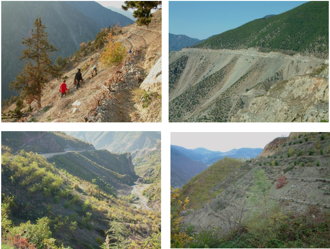
Şekil 32. Baraj Havzalarında yapılan erozyon kontrol çalışmaları (31)
