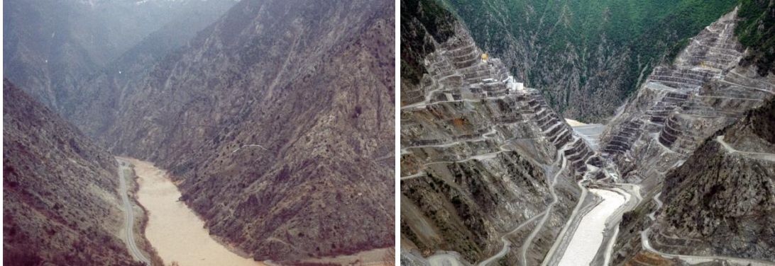
Şekil 8. Deriner Barajı inşaat öncesi ve sonrası bir görünüm (4)
