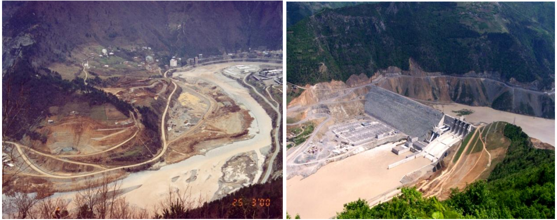
řekil 7. Borka barajı aks yeri ve su tutma ncesi genel bir grnm (4)
