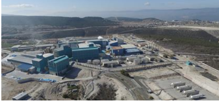
Resim 5.2 Emet bor işletme tesisi genel görünüm.
