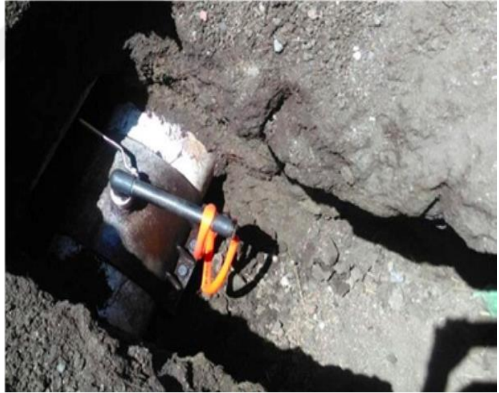
Şekil 3.5 Hindistan'daki bir boru hattında tespit edilip durdurulan kaçak kazı ve kaçak musluk (Berlin Pipeline Technology Conference, 2020).
