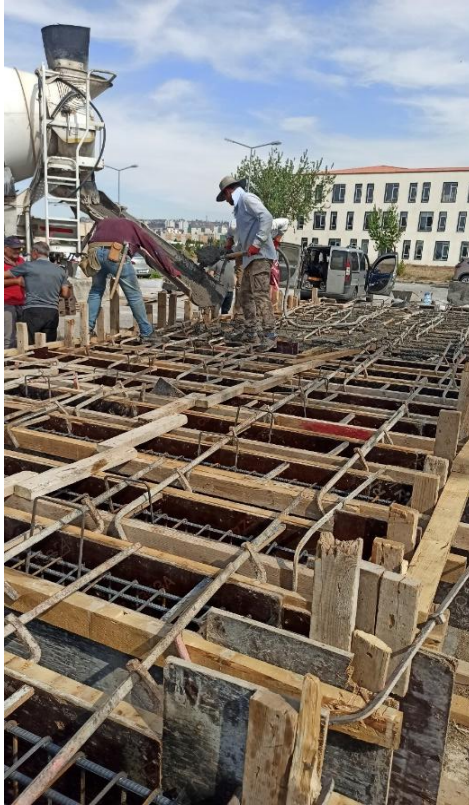
Şekil 8. Beton dökümü ve vibratör uygulaması
