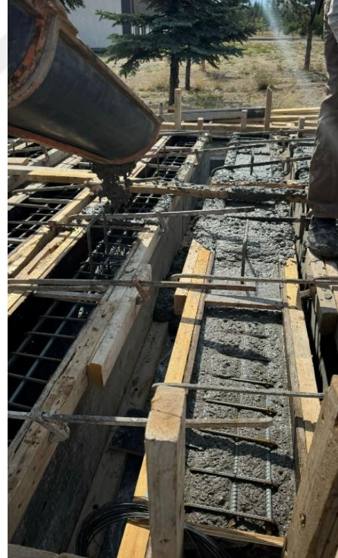
Şekil 8. Beton dökümü ve vibratör uygulaması
