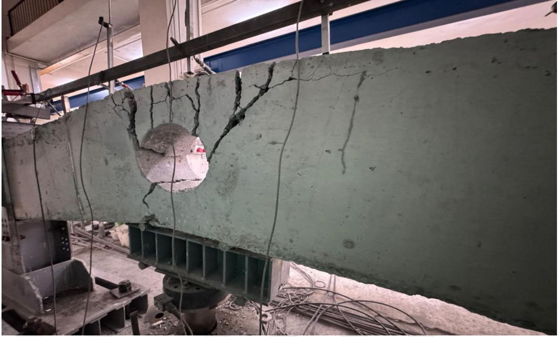
Şekil 50. B-REF-WO numunesinin arka yüzeyinde oluşan çatlakların görünümü
