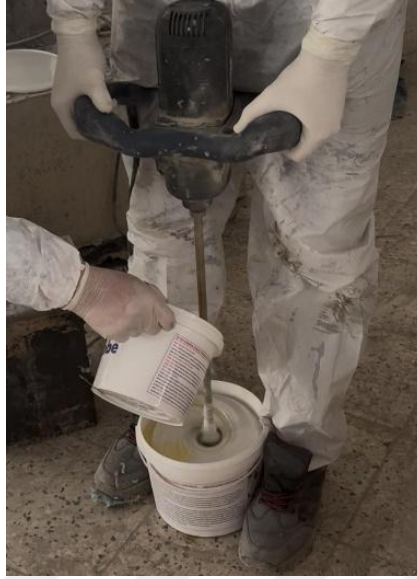
Şekil 29. Epoksi harcının hazırlanması
