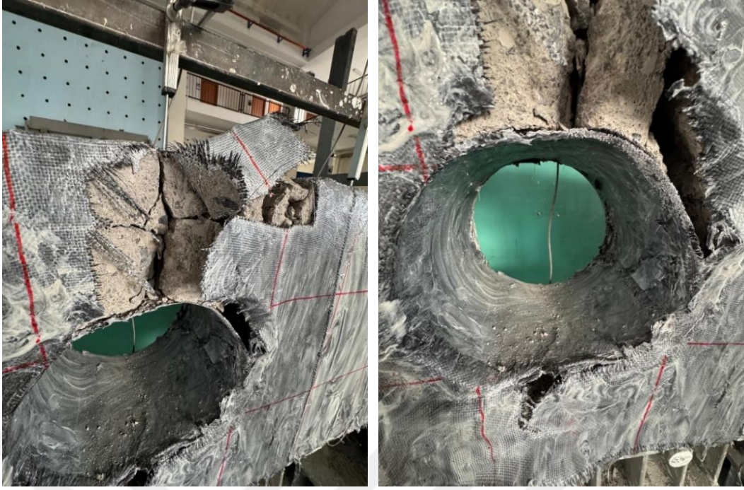
Şekil 58. B1-DEF- RET –WO numunesinin deney sonrası hasarlı görünümü
