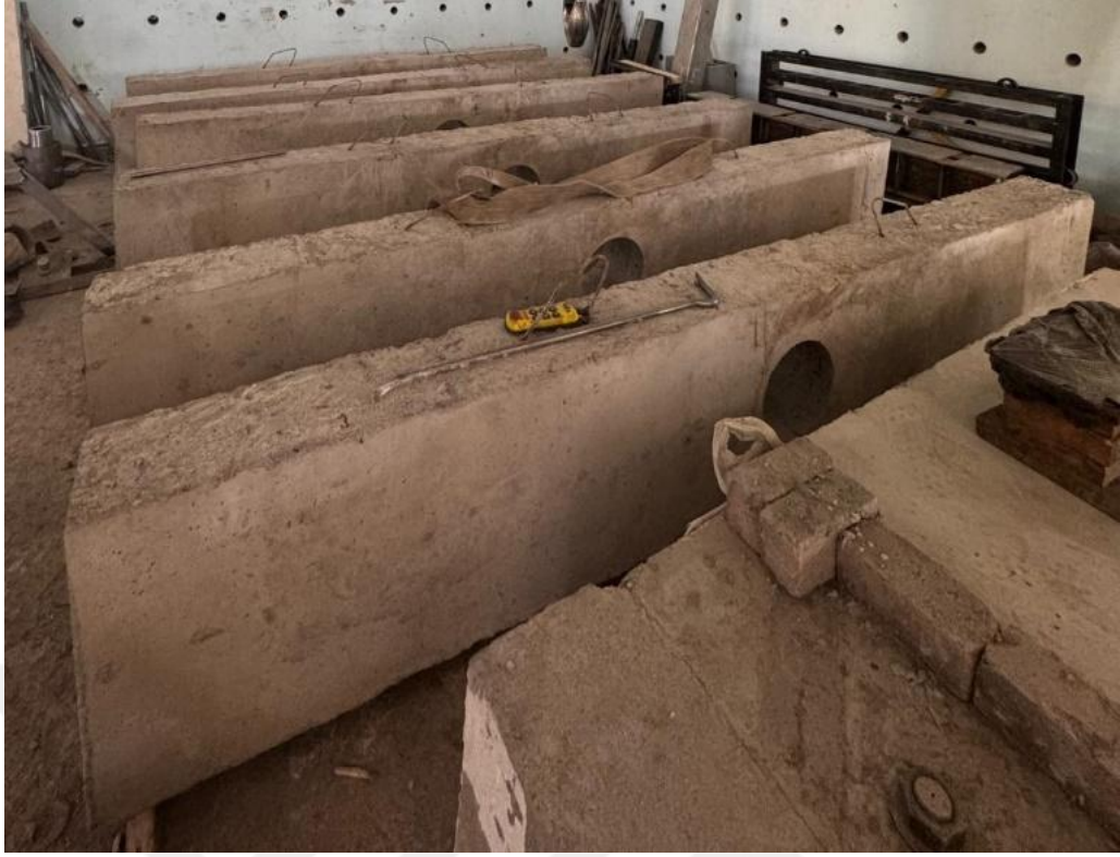
Şekil 11. Kiriş numunelerinin laboratuvara taşınması
