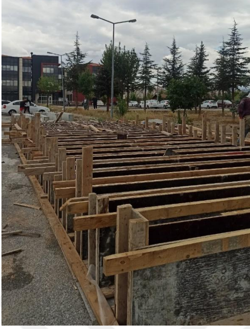
Şekil 7. Donatı hazırlığı ve ahşap kalıpların kurulması
