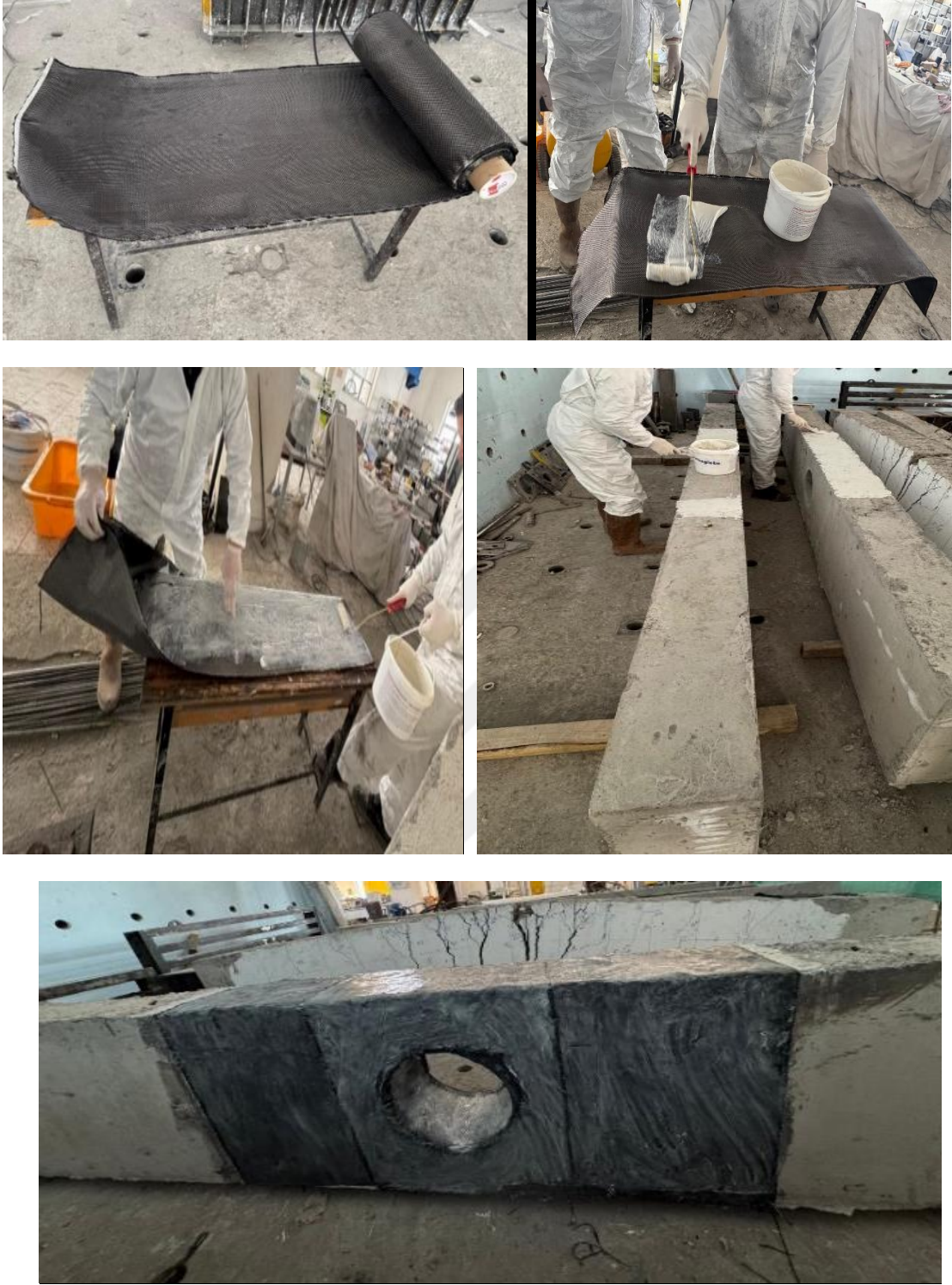
Şekil 30. B1-DEF-RET-WO kiriş numunesinin güçlendirme aşamaları
