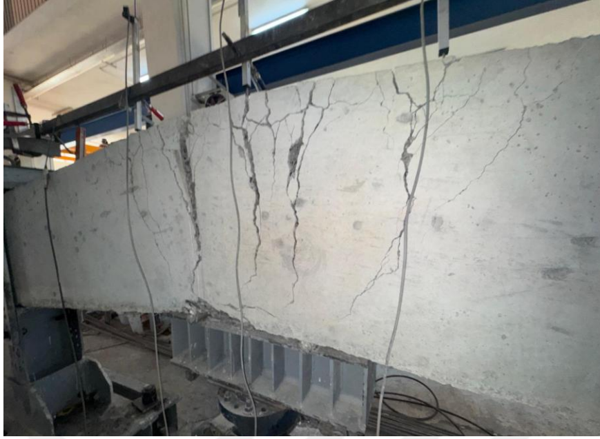
Şekil 41. B-REF numunesinin arkasındaki çatlak dağılımı
