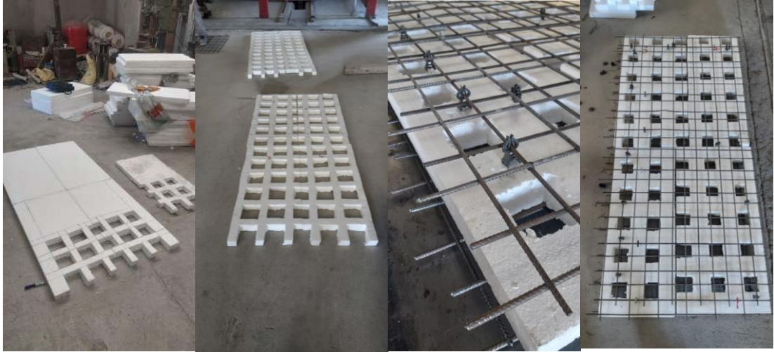
Şekil 3.8 Polistiren köpüklerin kesimi ve donatı birleşimi
