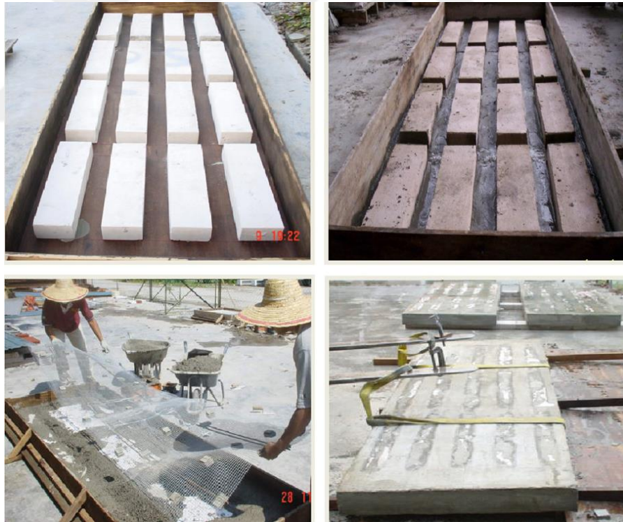
Şekil 2.4 Tek yönlü kompozit döşeme sistemi yapım aşaması (Yardim vd. 2013)
