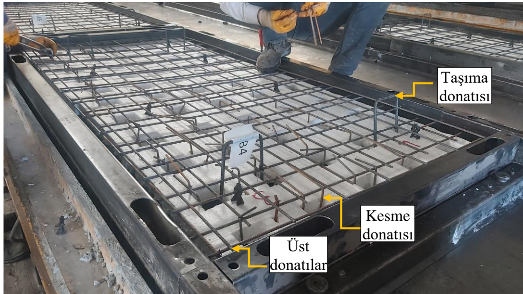
Şekil 3.9 Donatıların bağlanması ve kesme donatılarının yerleştirilmesi
