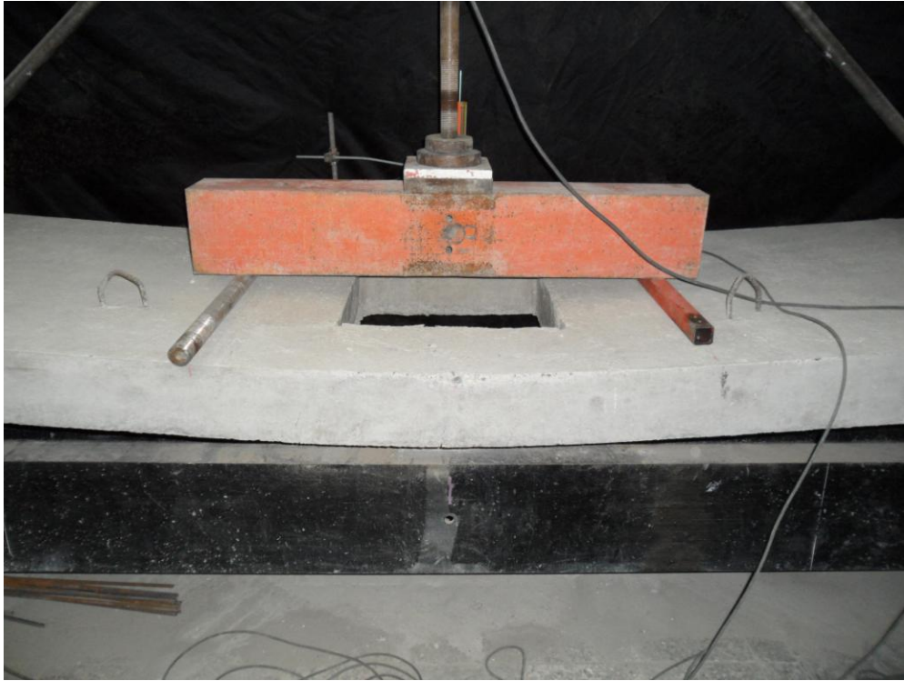
Resim 4.3. 2 numaralı elemanın eğilme çatlakları
