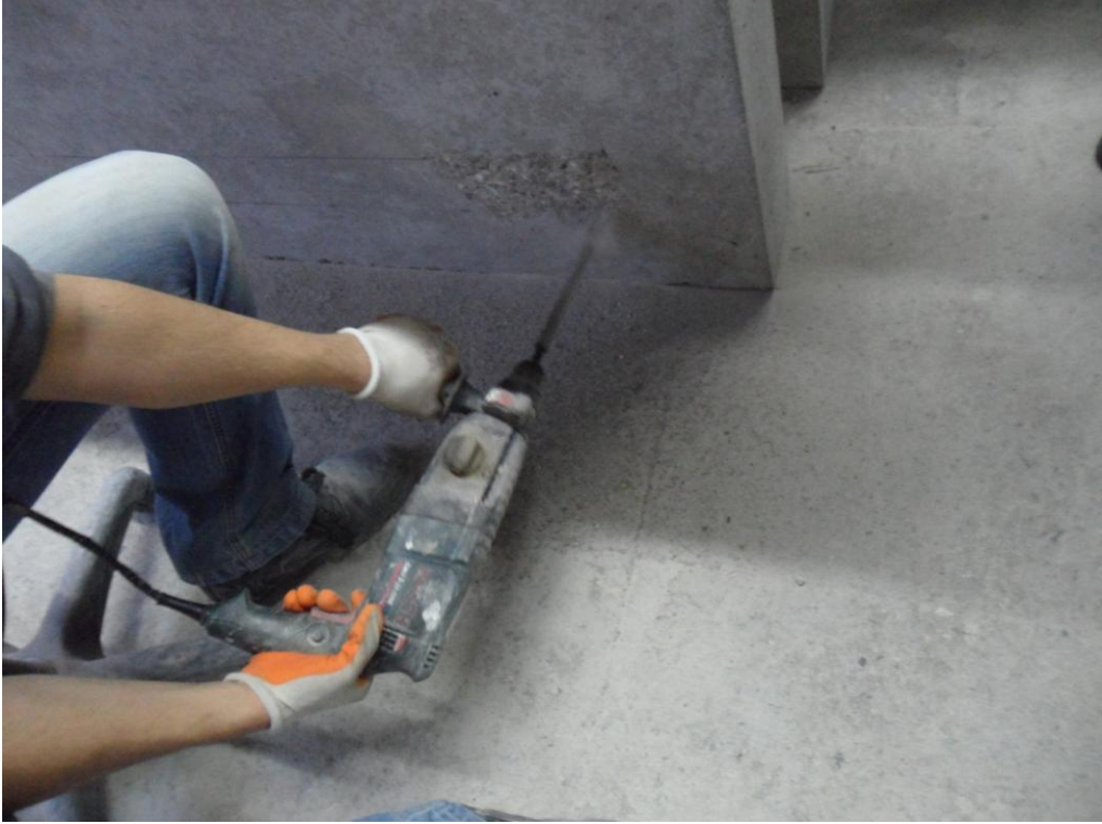
Resim 2.4. Beton yüzeyini pürüzlendirme işlemi
