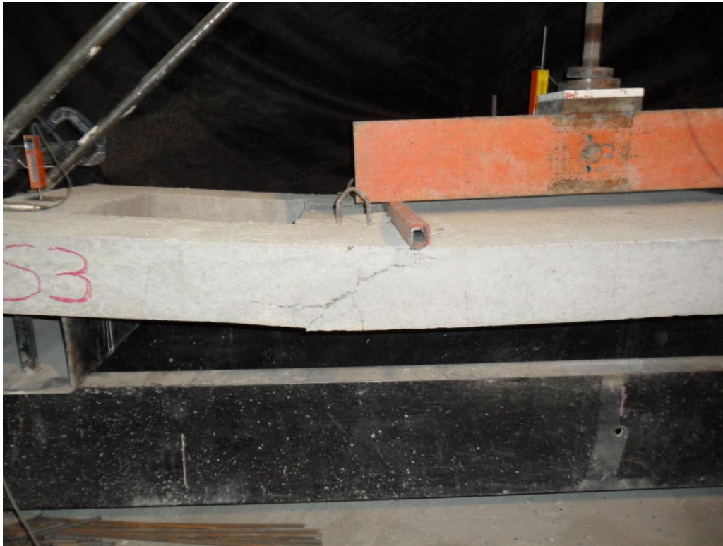
Resim 4.6. 3 numaralı elemanın kesme çatlağı
