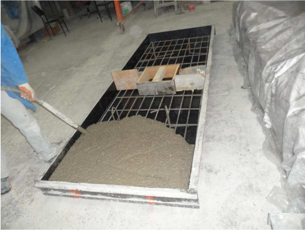
Resim 2.2. Betonun döküm sırasında sıkıştırılması
