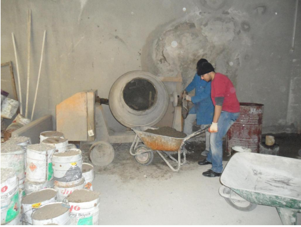
Resim 2.1. Beton hazırlanışı
