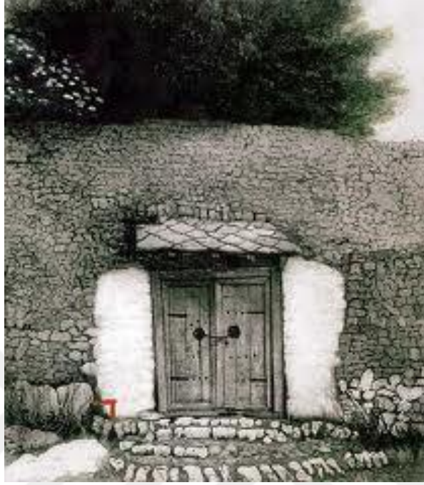
Resim 2.12. Avlu Kapısı ve Duvar.
