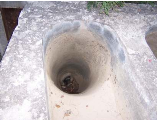
Foto Ek 1.20 Boyabat, Şamlıların Değirmeni, arklardan değirmene inen dikey betonarme oluk, Eylül 2004
