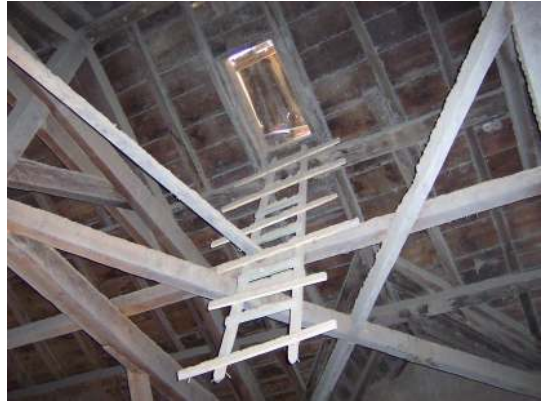
Foto Ek 1.314 Şamlılar Çeltik Fabrikası, 2-01 Üretim 3 mahallinde çatı kapağı ve merdiveni, Nisan 2004
