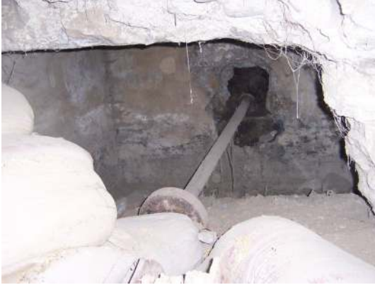
Foto Ek 1.259 Şamlılar Çeltik Fabrikası, Z-09 ile Z-10 mekanları arasındaki taş duvarda açılmış boşluk ve Z-10 içindeki çarka bağlanan metal mil, Nisan 2004
