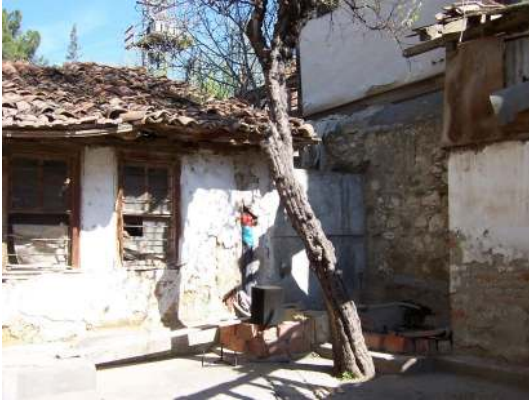
Foto Ek 1.218 Şamlılar Çeltik Fabrikası, güneybatı cephesi taş duvar önünde 12 nolu parselde ait hımış ek yapı ve fabrika ile arasındaki betonarme perde duvar, Nisan 2004
