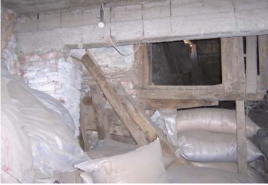
Foto Ek 1.253 Şamlılar Çeltik Fabrikası, Z-07 mekanı ile Z-09 mekanı arasındaki özgün hıymış duvar kalıntısı, Nisan 2004
