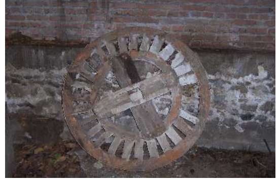
Foto Ek 1.44 Boyabat, Şamlıların Değirmeni, sökülmiş bir su çarkının alt yüzeyi, Eylül 2004.
