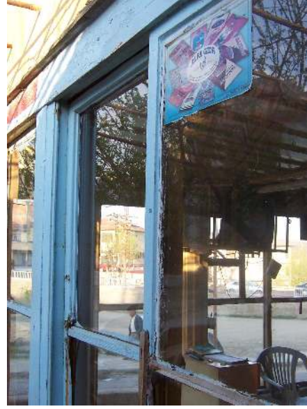
Foto Ek 1.279 Şamlılar Çeltik Fabrikası, 1-06 Kahvehane, kuzeybatı cephesinde özgün yatay sürme pencere, dış detay, Nisan 2004
