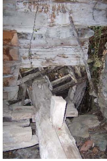
Foto Ek 1.84 Gazidere Tabaklısı Köyü, Ahmet-Nazım Yılmaz Değirmeni, ahşap milin su çarkına bağlantısı, Ekim 2003
