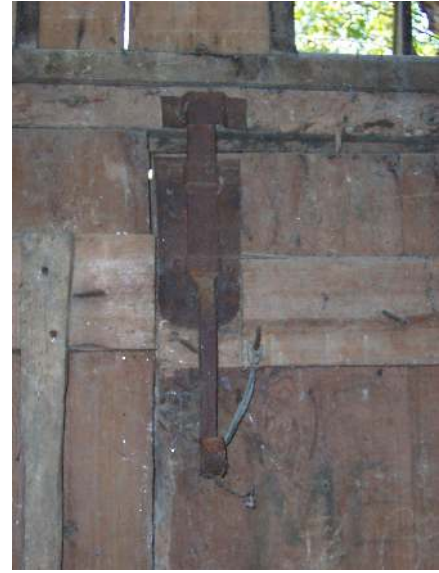
Foto Ek 1.28 Boyabat, Şamlıların Değirmeni, giriş kapısının demir üst kilidi, Eylül 2004
