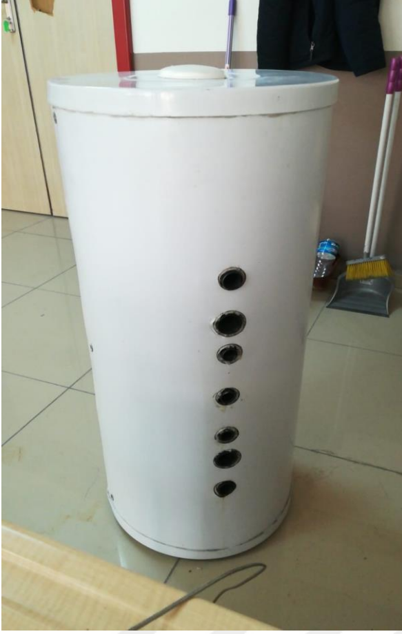
Şekil 5.4. Yalıtımlı ve dış kılıflı boyler kazanı
