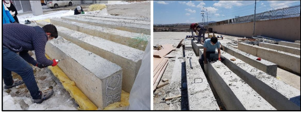
Şekil 3.25. Beton için tahribatsız malzeme dayanım tayini görüntüleri
