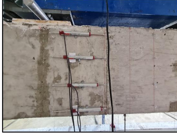
Şekil 3.26. Yatay deformasyon sensörlerinin yerleşimi
