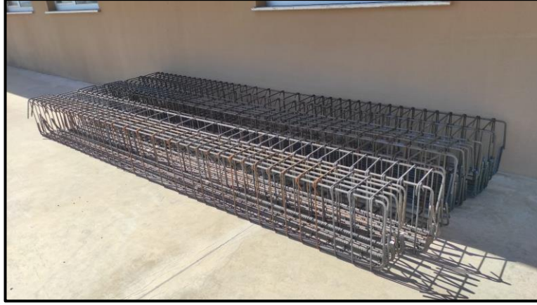
Şekil 3.24. İmalatı tamamlan kirişler
