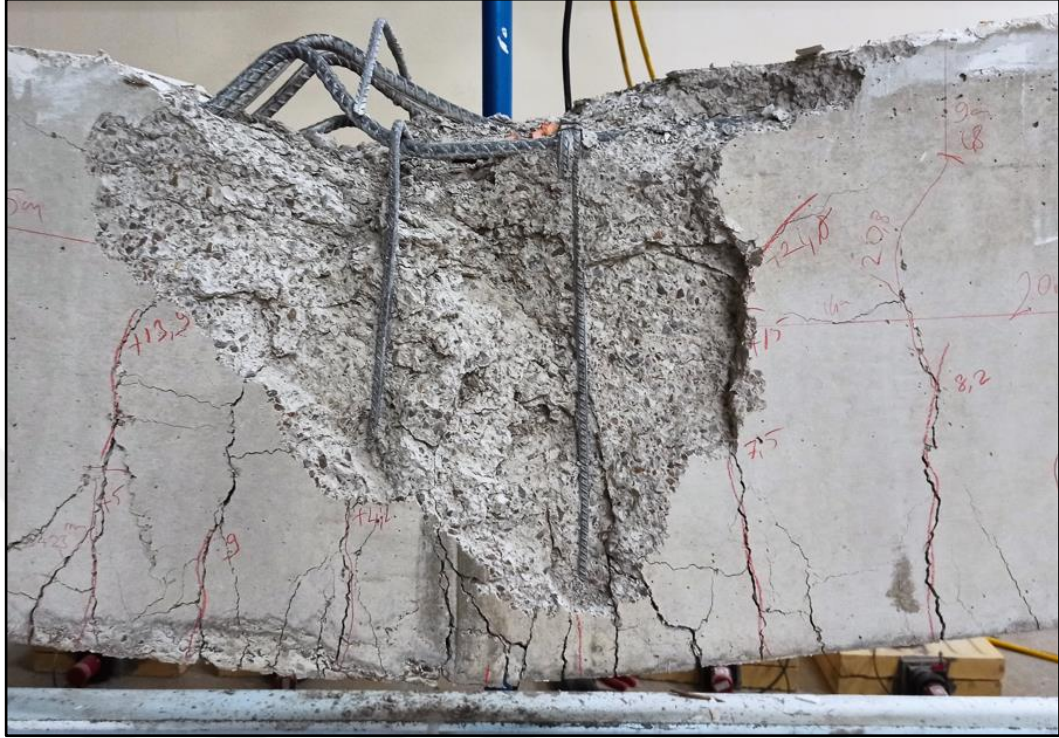
Şekil 4.92. K3-1 numunesi maksimum moment bölgesine ait çatlak görüntüsü
