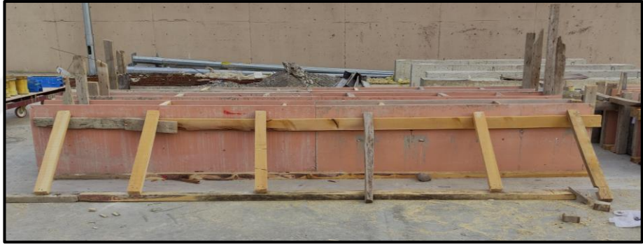
Şekil 3.20. Kalıp imalatının tamamlanmış hali
