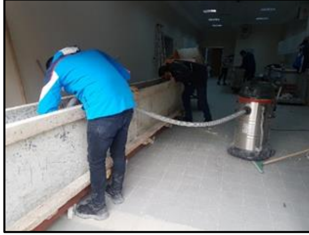
Şekil 3.21. Kalıp içi temizliği
