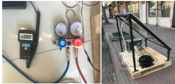
Şekil 4.8.Kompresör montajı ve gaz basım işlemi
