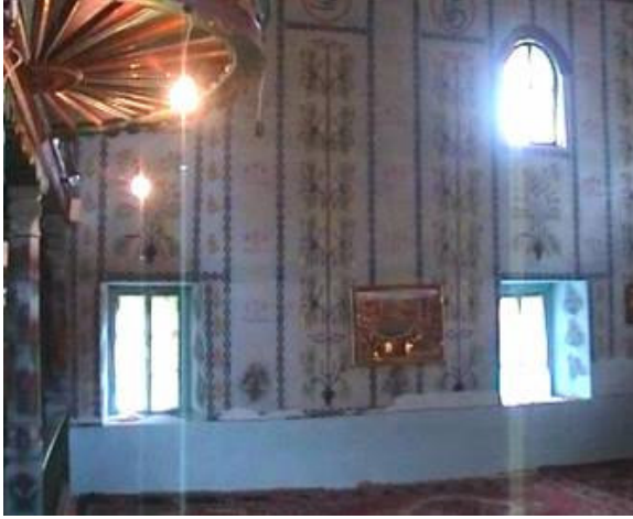
Resim 4.73. Hacı Hasan Ağa Camii, doğu duvarı (M.E.Yılmaz, 2004)
