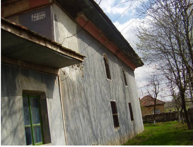
Resim 4.84. Hacı Ömer Ağa Camii, batı cephe (B. Darcan, 2006)
