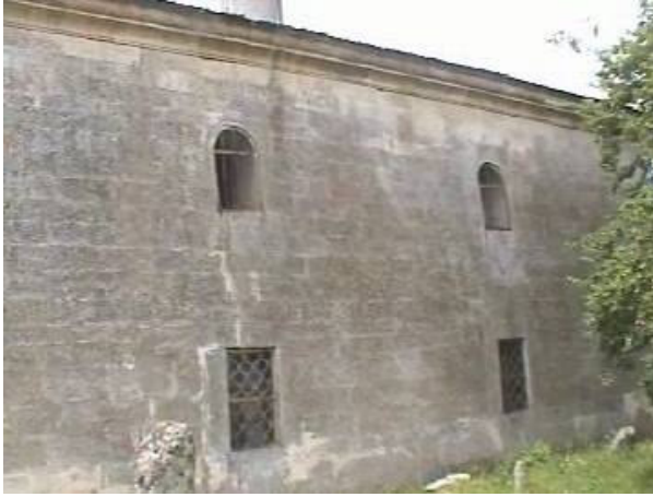
Resim 4.67. Hacı Hasan Ağa Camii, doğu cephe (M.E.Yılmaz, 2004)
