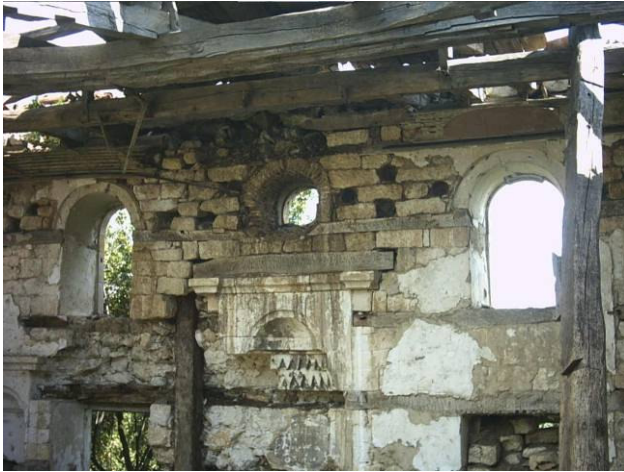
Resim 4.140. Habib Ağa Camii, kible duvarı (M.E.Yılmaz, 2004)
