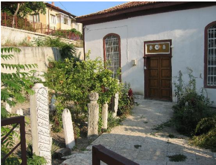
Resim 4.117. Turgut Reis Camii, kuzey cephe (M.E.Yılmaz, 2004)
