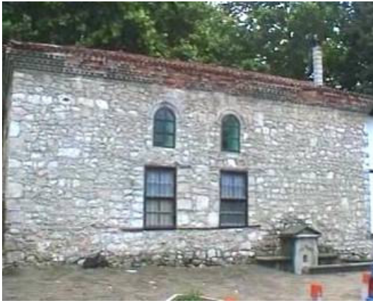
Resim 4.25. Tekke Camii, doğu cephesi (M.E.Yılmaz, 2004)
