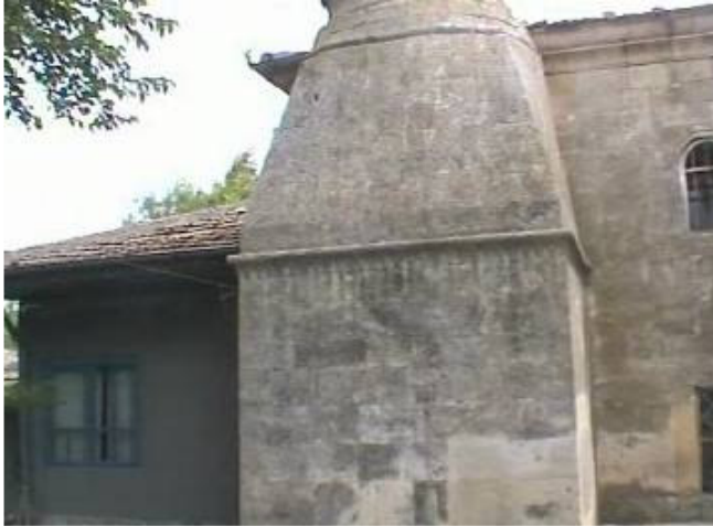
Resim 4.68. Hacı Hasan Ağa Camii, minare kaidesi (M.E.Yılmaz, 2004)
