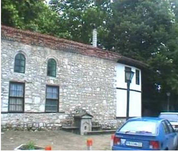
Resim 4.24. Tekke Camii, doğu cephesi (M.E.Yılmaz, 2004)
