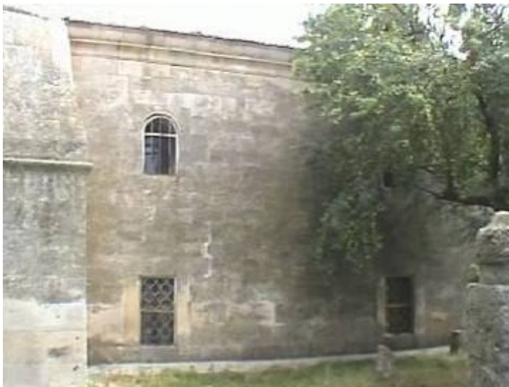
Resim 4.66. Hacı Hasan Ağa Camii, batı cephe (M.E.Yılmaz, 2004)
