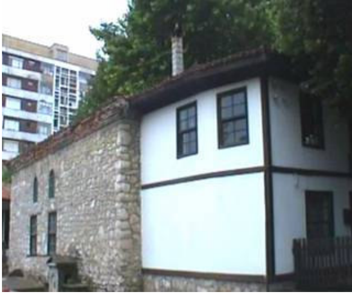
Resim 4.22. Tekke Camii, doğu cephesi (M.E.Yılmaz, 2004)
