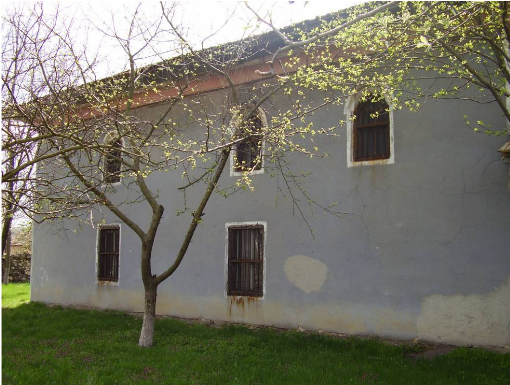
Resim 4.83. Hacı Ömer Ağa Camii, doğu cephe (B. Darcan, 2006)
