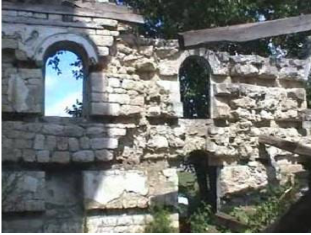
Resim 4.138. Habib Ağa Camii, doğu duvarı (M.E.Yılmaz, 2004)
