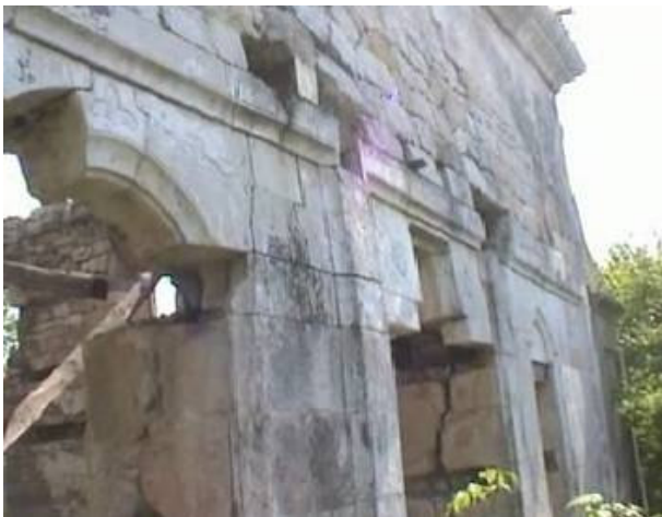
Resim 4.137. Habib Ağa Camii, kuzey cephe (M.E.Yılmaz, 2004)
