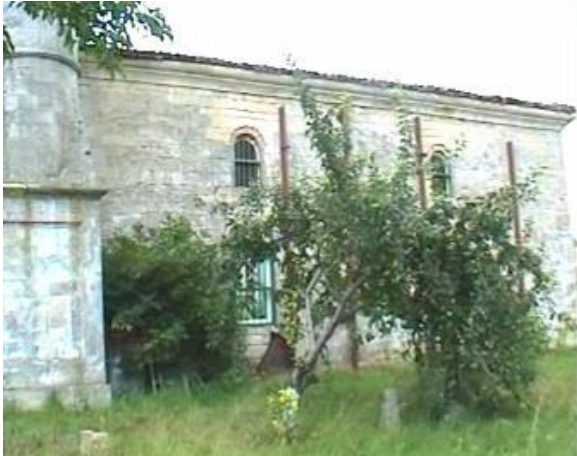
Resim 4.100. Hacı Hasan Ağa Camii, batı cephe (M.E.Yılmaz, 2004)
