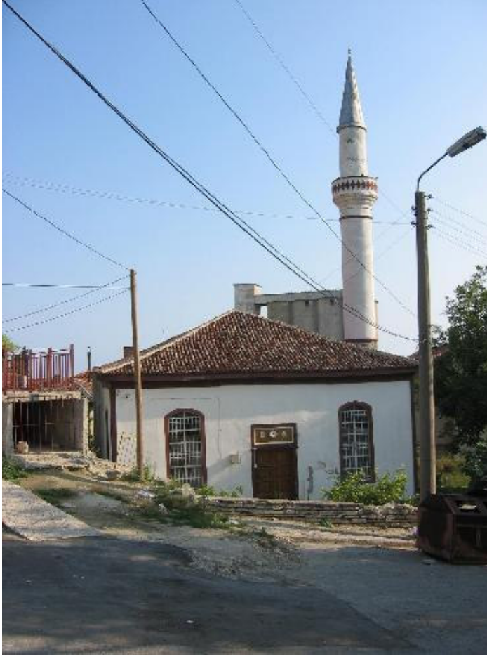
Resim 4.116. Turgut Reis Camii, kuzey cephe (M.E.Yılmaz, 2004)
