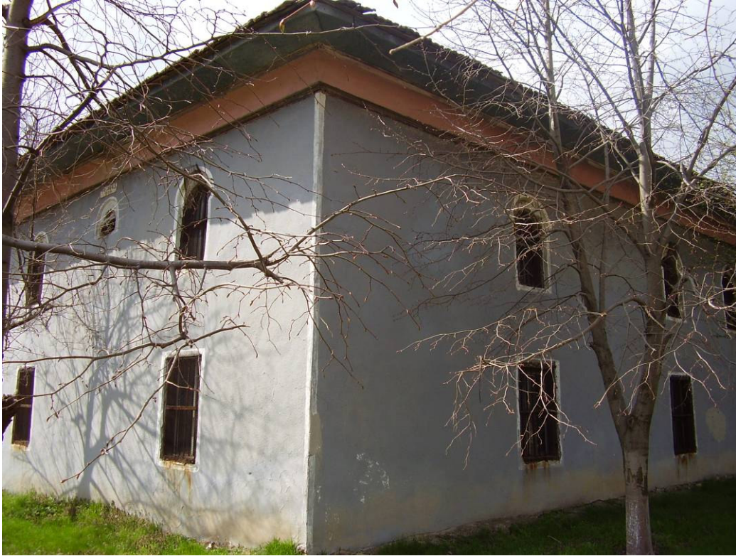
Resim 4.82. H.Ömer Ağa Camii, güney-doğu cepheleri (B. Darcan, 2006)
