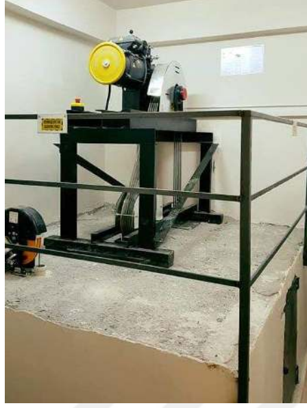
Görsel 5.7. Makine Dairesi ve Tahrik Makinesi (Motor) (Yönel Asansör, 2022)
