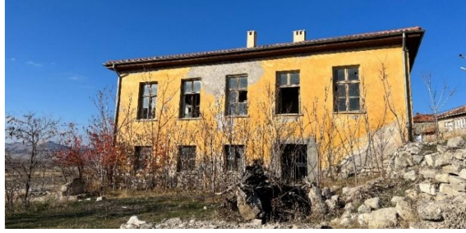
Şekil 6.9.2.27. Elmacık Köyü Okulu Güney Cephe Fotoğrafı (Yılmaz Özev Arşivi, 2022)
