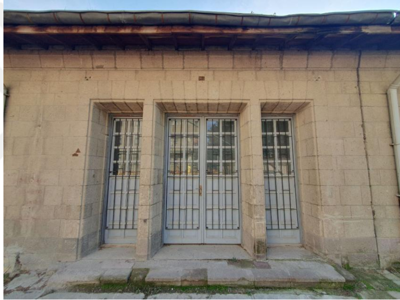
Şekil 6.1.7.1. Erkek Sanat Enstitüsü Giriş (Kuzey) Cephe Fotoğrafı (TKGM, 2024)
