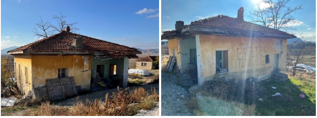
Şekil 6.9.2.29. Elmacık Köyü Okulu Öğretmen Evi Doğu Cephe Fotoğrafı (Yılmaz Özev, 2022)
