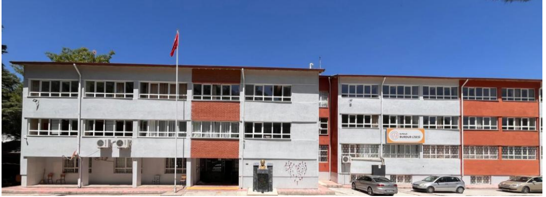
Şekil 6.1.8.1. Burdur Lisesi Okulu Giriş (Doğu) Cephe Fotoğrafı (Yılmaz Özev Arşivi, 2025)
