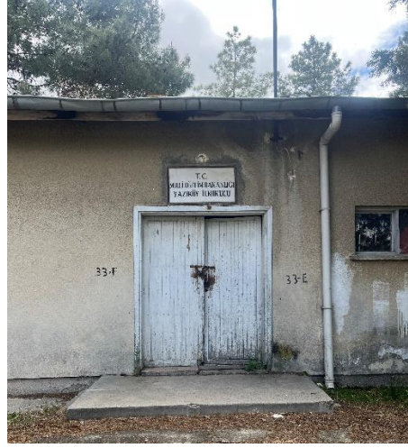
Şekil 6.2.17.5. Yazıköy Köyü Okulu Giriş Kapısı Fotoğrafı (Yılmaz Özev Arşivi, 2024)
