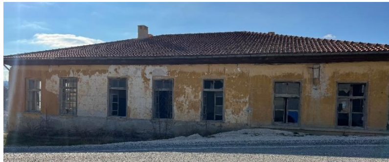
Şekil 6.9.2.26. Elmacık Köyü Okulu Doğu Cephe Fotoğrafı (Yılmaz Özev Arşivi, 2022)
