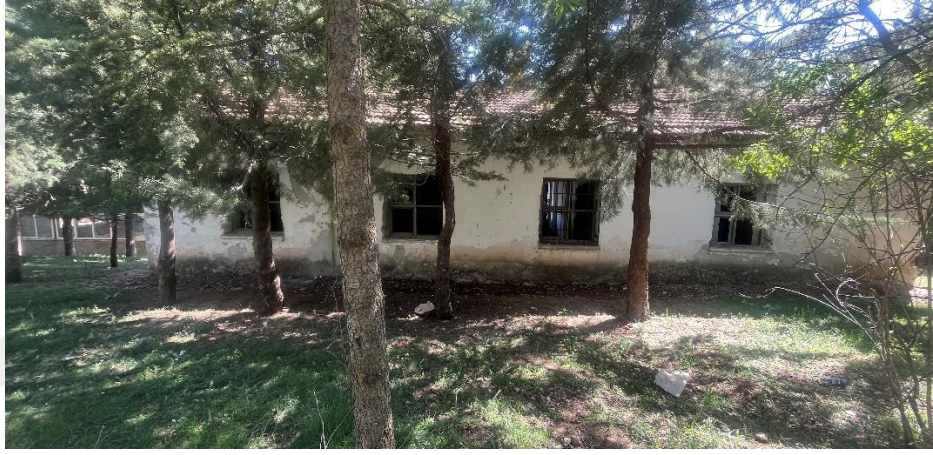
Şekil 6.2.4.6. Beşkavak Köyü Okulu Kuzey Cephe Fotoğrafı (Yılmaz Özev Arşivi, 2023)
