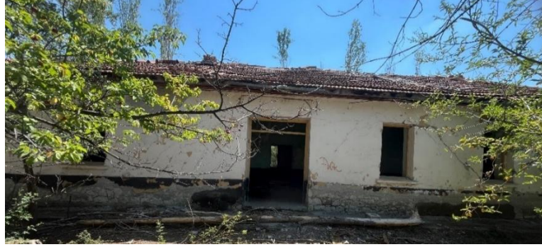
Şekil 6.10.3.1. Hasanpaşa Köyü Birinci Okulu Giriş (Kuzeydoğu) Cephe Fotoğrafı (Yılmaz Özev Arşivi, 2024)
