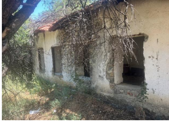
Şekil 6.11.8.7. Yukarı Kırılı Köyü Okulu Batı Cephe Fotoğrafı (Yılmaz Özev Arşivi, 2024)
