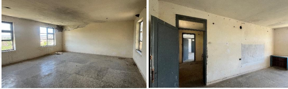
Şekil 6.11.5.12., Şekil 6.11.5.13. Gençali Köyü Okulu İç Mekan Fotoğrafları (Yılmaz Özev Arşivi, 2024)
