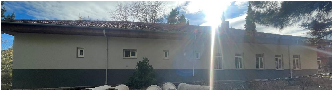
Şekil 6.6.2.15. Çebiş Köyü İkinci Okul Kuzey Cephe Fotoğrafı (Yılmaz Özev Arşivi, 2023)
