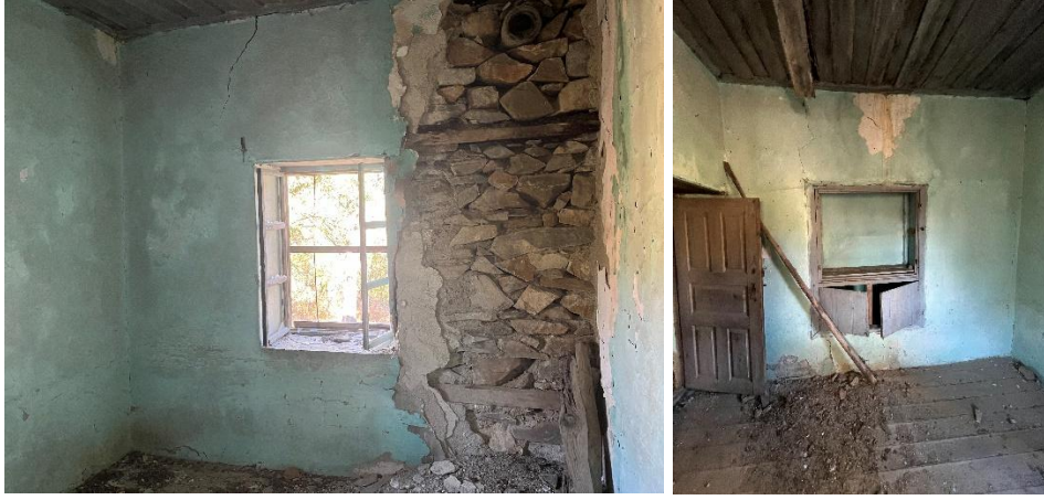
Şekil 6.2.6.15., Şekil 6.2.6.16. Bozlar Köyü Okulu Öğretmen Evi İç Mekan Fotoğrafları (Yılmaz Özev Arşivi, 2023)
