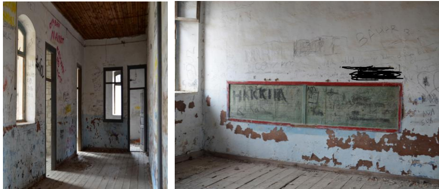
Şekil 6.2.13.9., Şekil 6.2.13.10. Kayaaltı Köyü Okulu Kolidor ve Derslik Fotoğrafları (Yılmaz Özev Arşivi, 2021)
