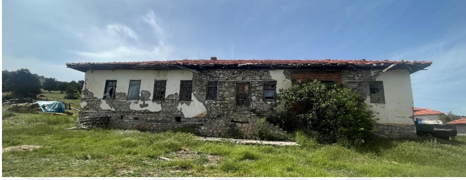
Şekil 6.2.1.1. Başmakçı Köyü Okulu Giriş (Güneydoğu) Cephe Fotoğrafı (Yılmaz Özev Arşivi, 2024)
