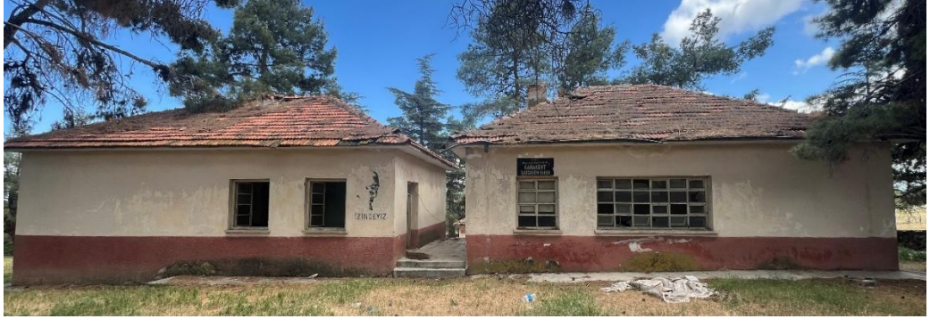
Şekil 6.2.12.1. Karakent Köyü Okulu Giriş (Batı) Cephe Fotoğrafı (Yılmaz Özev Arşivi, 2024)
