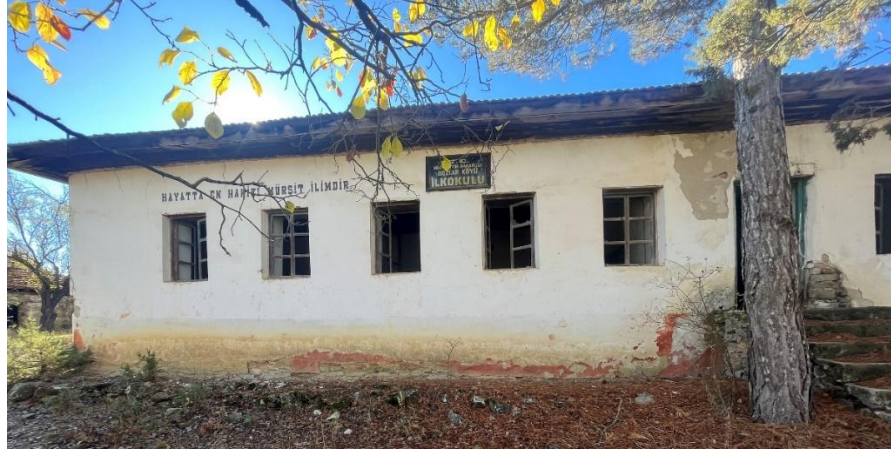
Şekil 6.2.6.5. Bozlar Köyü Okulu Giriş (Kuzey) Cephe Fotoğrafı (Yılmaz Özev Arşivi, 2023)
