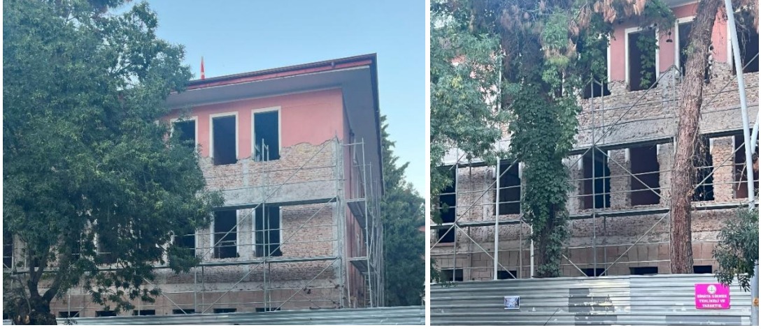
Şekil 6.1.6.11., Şekil 6.1.6.12. Kız Sanat Enstitüsü Giriş (Batı) Cephe Fotoğrafları (Yılmaz Özev Arşivi, 2022)
