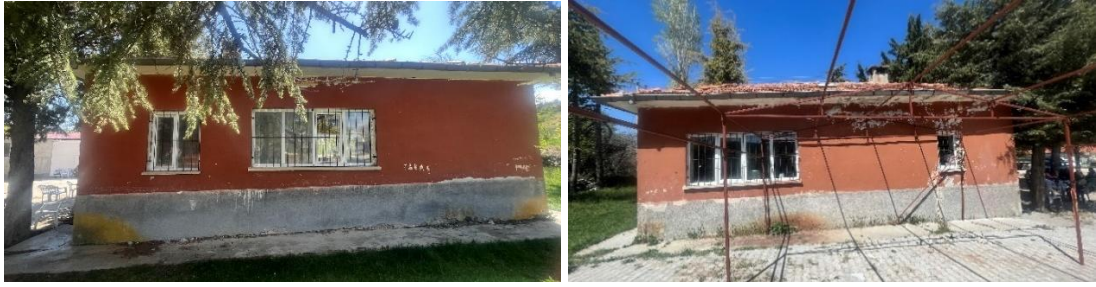
Şekil 6.2.3.5., Şekil 6.2.3.6. Bereket Köyü Okulu Cephe Fotoğrafları (Yılmaz Özev, 2024)
