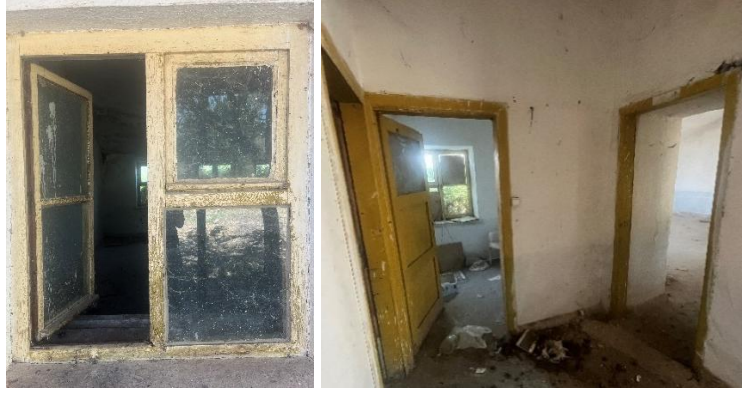
Şekil 6.11.2.7., Şekil 6.11.2.8. Yeşilova Bayındır Köyü Okulu Pencere ve Kapı Fotoğrafları (Yılmaz Özev Arşivi, 2024)
