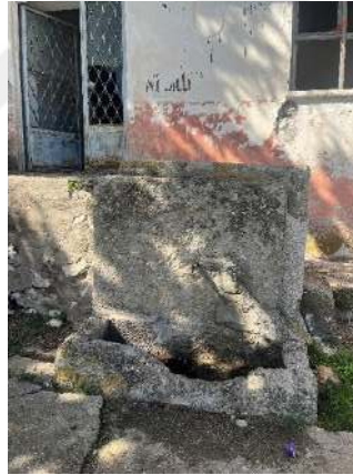
Şekil 6.2.4.8. Beşkavak Köyü Okulu Bahçesinde Yeralan Çeşme Fotoğrafı (Yılmaz Özev, 2024)
