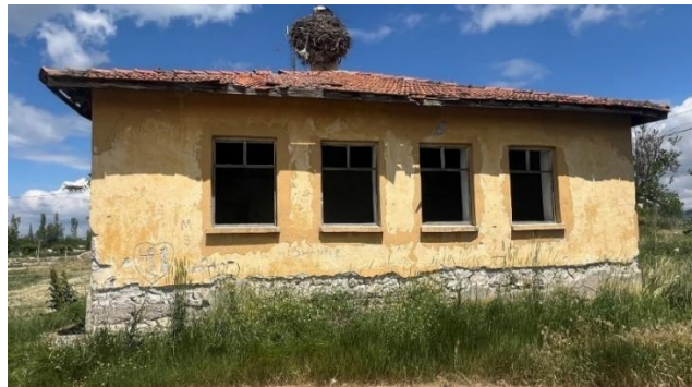
Şekil 6.2.15.6. Yarıköy Köyü Okulu Kuzeydoğu Cephe Fotoğrafi (Yılmaz Özev Arşivi, 2024)
