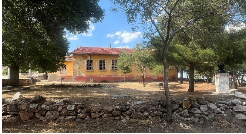
Şekil 6.10.2.1. Ece Köyü Okulu Giriş (Güney) Cephe Fotoğrafı (Yılmaz Özev Arşivi, 2024)
