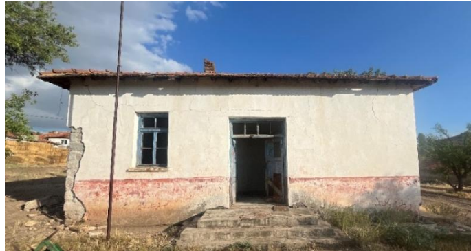
Şekil 6.11.3.1. Bayırbaşı Köyü Okulu Giriş (Kuzey) Cephe Fotoğrafı (Yılmaz Özev Arşivi, 2024)
