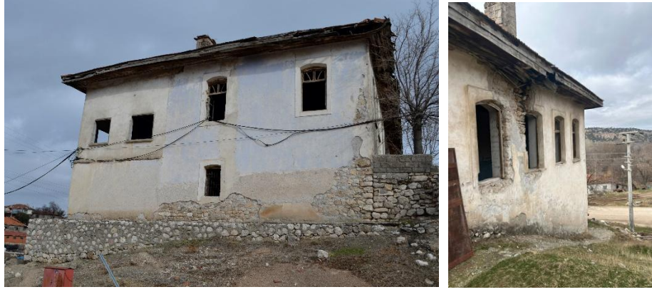
Şekil 6.2.13.6., Şekil 6.2.13.7. Kayaaltı Köyü Okulu Kuzeybatı ve Güneydoğu Cephe Fotoğrafları (Yılmaz Özev Arşivi, 2021)
