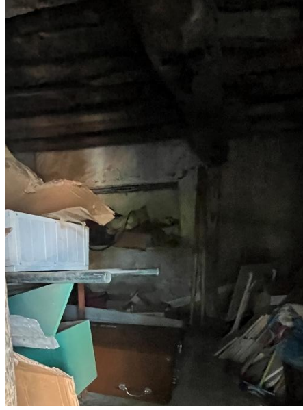
Şekil 6.2.9.4. Halıcılar Köyü Okulu Zemin Kat Fotoğrafı (Yılmaz Özev Arşivi, 2024)
