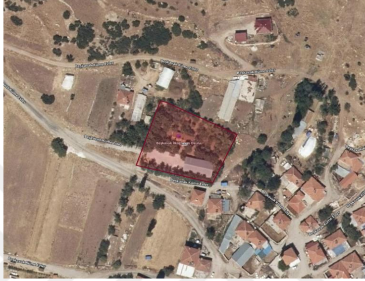
Şekil 6.2.4.2. Beşkavak Köyü Okulu TKGM Parsel Sorgu Fotoğrafı (TKGM, 2024)
