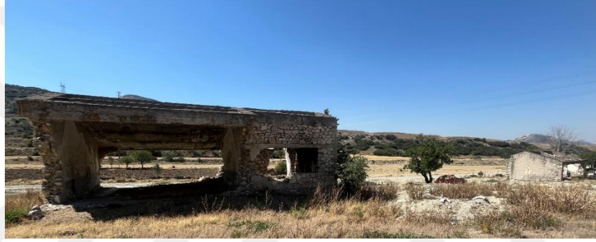
Şekil 6.2.14.1. Kuruçay Köyü Okulu Kuzey Cephe Fotoğrafı (Yılmaz Özev Arşivi, 2024)
