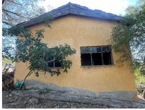
Şekil 6.11.7.5. Karaköy Köyü Okulu Doğu Cephe Fotoğrafı (Yılmaz Özev Arşivi, 2024)
