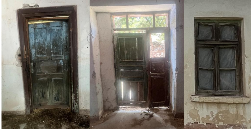
Şekil 6.2.16.7., Şekil 6.2.16.8., Şekil 6.2.16.9. Yaylabeli Köyü Okulu Kapı ve Pencere Fotoğrafları (Yılmaz Özev Arşivi, 2024)
