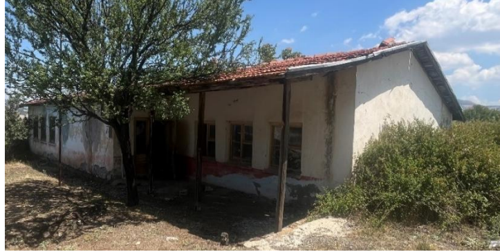
Şekil 6.11.2.4. Yeşilova Bayındır Köyü Okulu Doğu Cephe Fotoğrafı (Yılmaz Özev Arşivi, 2024)
