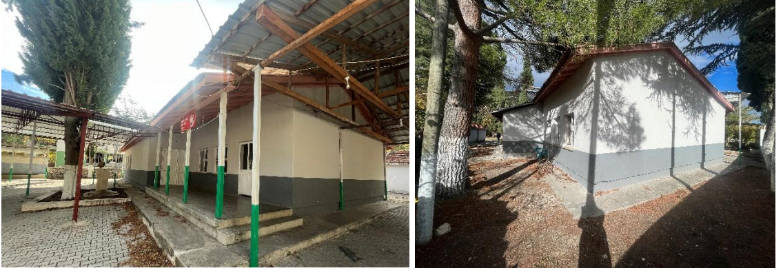
Şekil 6.6.2.4., Şekil 6.6.2.5. Çebiş Köyü Birinci Okulu Kuzey ve Güney Cephe Fotoğrafları (Yılmaz Özev Arşivi, 2023)
