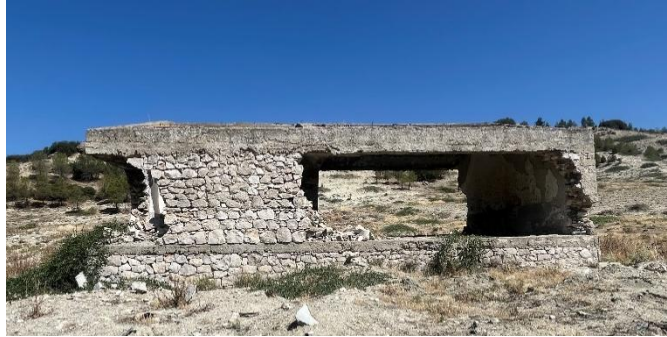
Şekil 6.2.14.8. Kuruçay Köyü Okulu Güney Cephe Fotoğrafı (Yılmaz Özev Arşivi, 2024)
