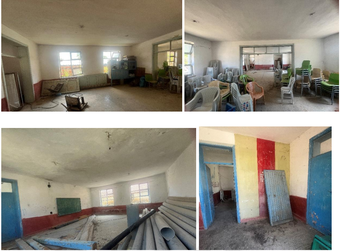
Şekil 6.10.6.9., Şekil 6.10.6.10., Şekil 6.10.6.11., Şekil 6.10.6.12. Işıklar Köyü Okulu İç Mekan Fotoğrafları (Yılmaz Özev Arşivi, 2024)
