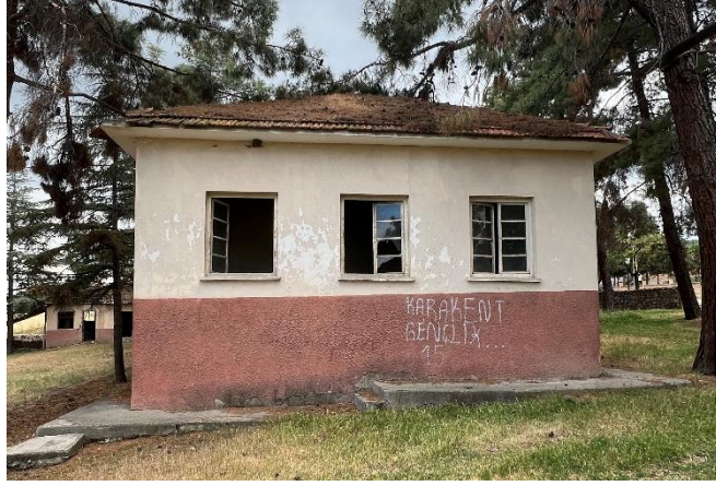
Şekil 6.2.12.6. Karakent Köyü Okulu A blok Kuzeydoğu Cephe Fotoğrafı (Yılmaz Özev Arşivi, 2024)
