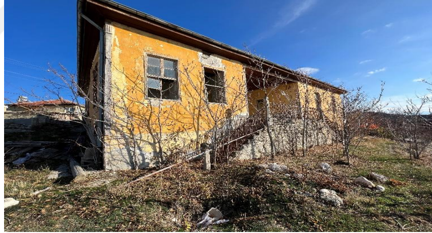
Şekil 6.9.2.1. Elmacık Köyü Okulu Giriş (Doğu) Cephe Fotoğrafı (Yılmaz Özev Arşivi, 2022)
