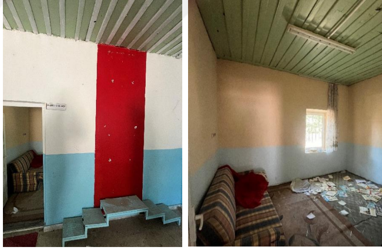
Şekil 6.2.8.10. Günelan Köyü Okulu Hol Fotoğrafı (Yılmaz Özev Arşivi, 2024)
