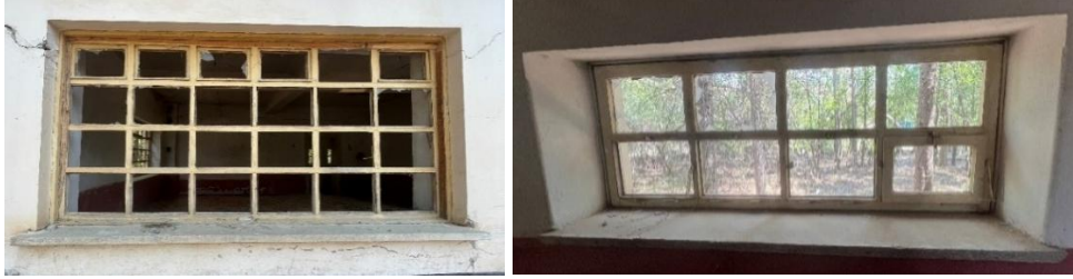
Şekil 6.10.3.18., Şekil 6.10.3.19. Hasanpaşa Köyü İkinci Okulu Pencere Fotoğrafları (Yılmaz Özev Arşivi, 2024)
