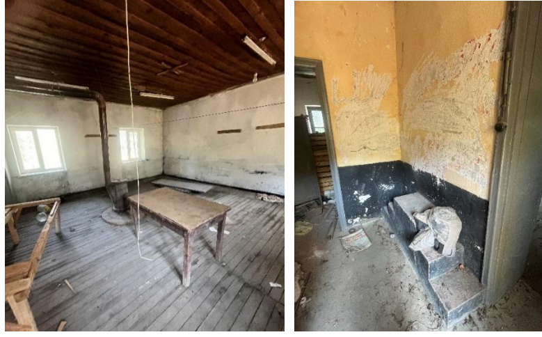
Şekil 6.3.1.8., Şekil 6.3.1.9. Çamlıdere Köyü Okulu İç Mekan Fotoğrafları (Yılmaz Özev Arşivi, 2024)
