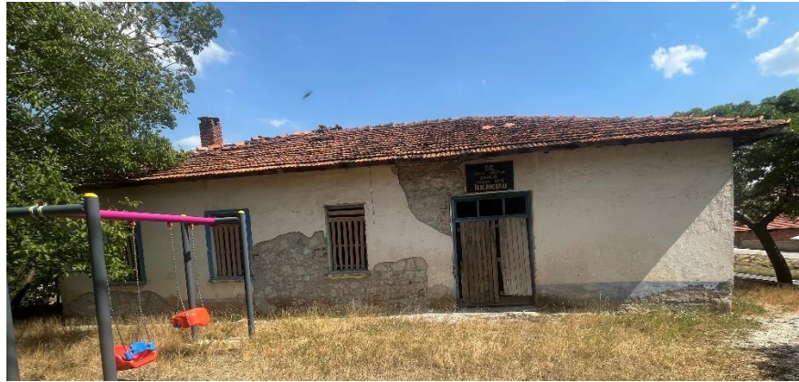
Şekil 6.10.4.1. Sazak Köyü Okulu Giriş (Kuzey) Cephe Fotoğrafı (Yılmaz Özev Arşivi, 2024)
