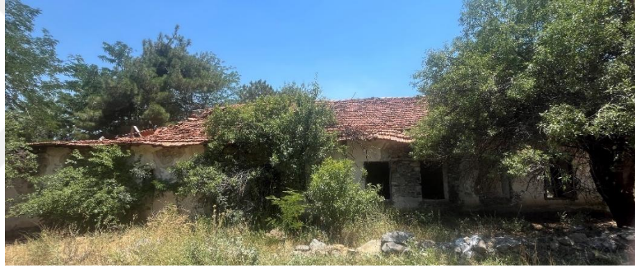
Şekil 6.11.8.8. Yukarı Kırılı Köyü Okulu Batı Cephe Fotoğrafı (Yılmaz Özev Arşivi, 2024)
