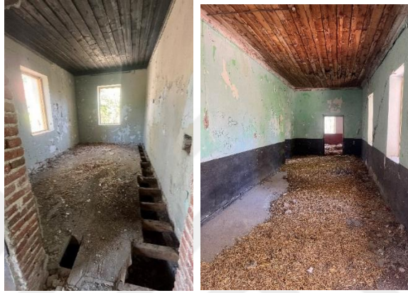
Şekil 6.10.3.8., Şekil 6.10.3.9. Hasanpaşa Köyü Birinci Okulu Öğretmen Odası ve Hol İç Mekan Fotoğrafları (Yılmaz Özev Arşivi, 2024)
