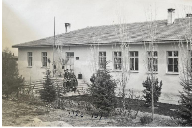
Şekil 6.8.1.1. Devrim Okulu Kuzeybatı (Öğretmen Girişi) Cephe 1972-1973 Yılına Ait Fotoğrafı (URL-31, 2024)
