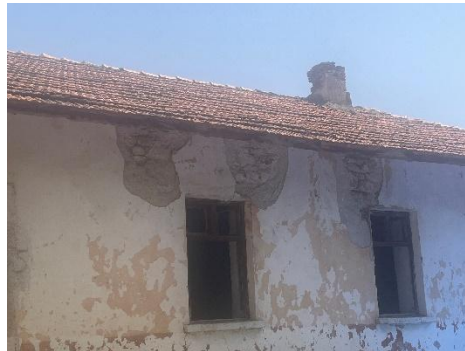
Şekil 6.2.16.16. Yaylabeli Köyü Okulu Duvar Dış Detayı Fotoğrafı (Yılmaz Özev Arşivi, 2024)
