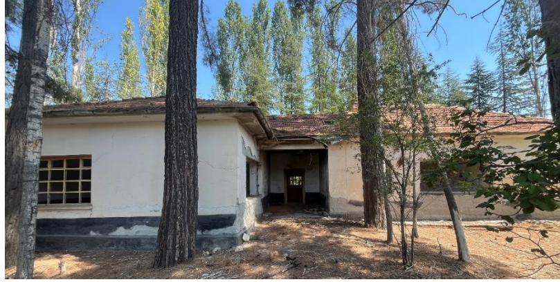
Şekil 6.10.3.12. Hasanpaşa Köyü İkinci Okulu Giriş (Güneydoğu) Cephe Fotoğrafı (Yılmaz Özev Arşivi, 2024)
