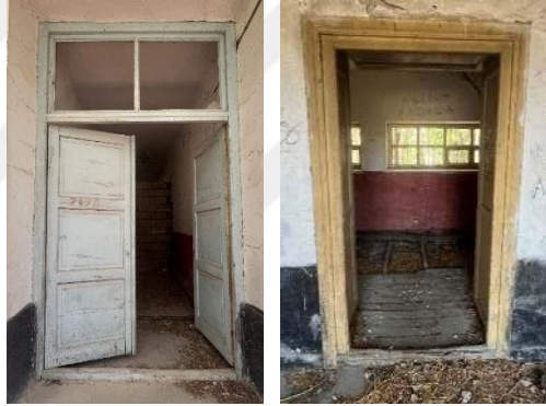
Şekil 6.10.3.20., Şekil 6.10.3.21. Hasanpaşa Köyü İkinci Okulu Kapı Fotoğrafları (Yılmaz Özev Arşivi, 2024)
