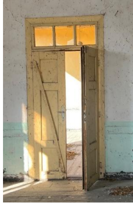
Şekil 6.9.2.14. Elmacık Köyü Okulu Derslik Kapı Fotoğrafı (Yılmaz Özev Arşivi, 2022)
