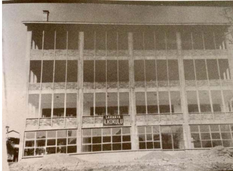
Şekil 6.1.4.4. Sakarya Okulu'nun 1970'li Yıllarda İnşaat Sırasında Bahçeden Çekilen Fotoğrafı (URL-19, 2025)
