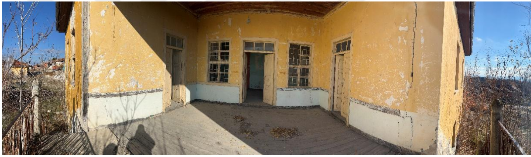
Şekil 6.9.2.6. Elmıcık Köyü Okulu Giriş Cephe Fotoğrafi (Yılmaz Özev Arşivi, 2022)
