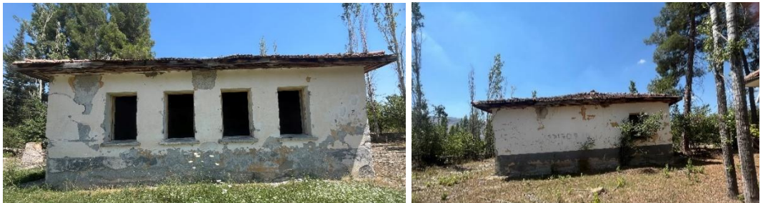
Şekil 6.10.3.5., Şekil 6.10.3.6. Hasanpaşa Köyü Birinci Okulu Güneybatı ve Kuzeydoğu Cephe Fotoğrafları (Yılmaz Özev Arşivi, 2024)
