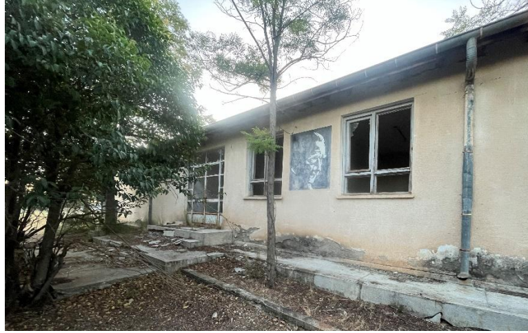
Şekil 6.5.2.1. Çavdır Büyükalan Köyü Okulu Giriş (Güneydoğu) Cephe Fotoğrafı (Yılmaz Özev Arşivi, 2024)
