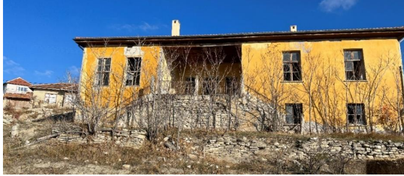
Şekil 6.9.2.5. Elmıcık Köyü Okulu Doğu Cephe Fotoğrafi (Yılmaz Özev Arşivi, 2022)
