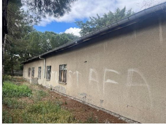
Şekil 6.2.17.4. Yazıköy Köyü Okulu Güneybatı Cephe Fotoğrafi (Yılmaz Özev Arşivi, 2024)
