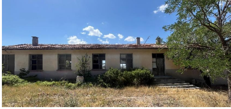
Şekil 6.11.5.1. Gençali Köyü Okulu Giriş (Güneydoğu) Cephe Fotoğrafı (Yılmaz Özev Arşivi, 2024)
