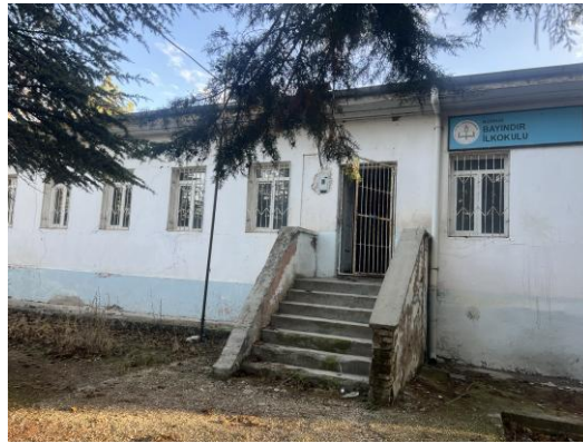
Şekil 6.2.2.5. Bayındır Köyü Okulu Giriş Cephe Fotoğrafı (Yılmaz Özev Arşivi, 2023)
