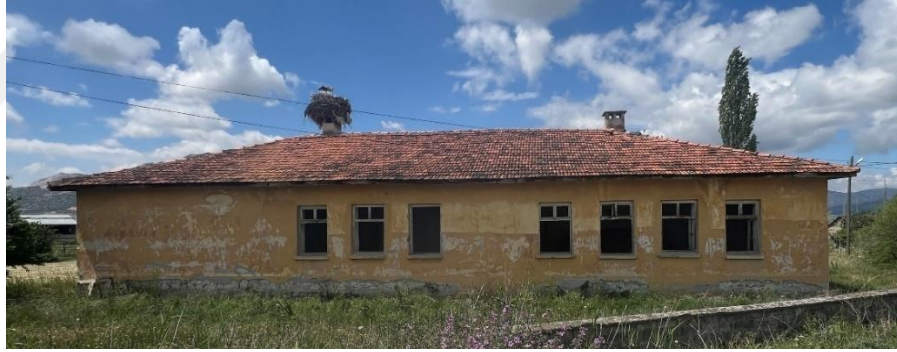
Şekil 6.2.15.5. Yarıköy Köyü Okulu Kuzeybatı Cephe (Yol Cephe) Fotoğrafi (Yılmaz Özev Arşivi, 2024)
