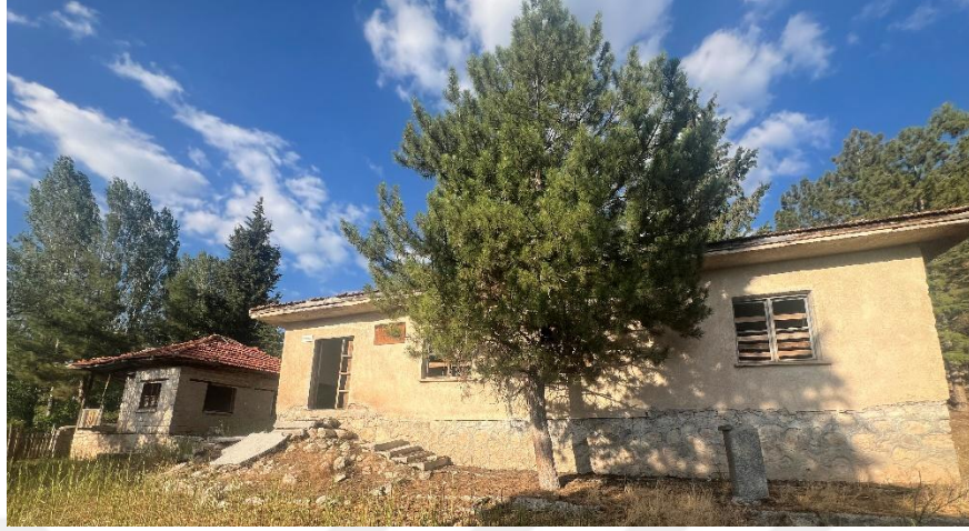
Şekil 6.7.1.1. Kuşdili Köyü Okulu Giriş (Doğu) Cephe Fotoğrafı (Yılmaz Özev Arşivi, 2024)
