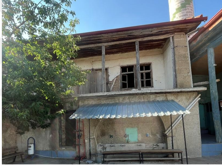
Şekil 6.2.9.1. Halıcılar Köyü Okulu Fotoğrafı (Yılmaz Özev Arşivi, 2024)
