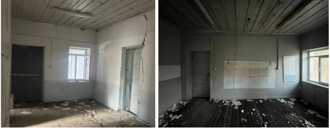
Şekil 6.2.2.9., Şekil 6.2.2.10. Bayındır Köyü Okulu İç Mekan Fotoğrafları (Yılmaz Özev Arşivi, 2023)
