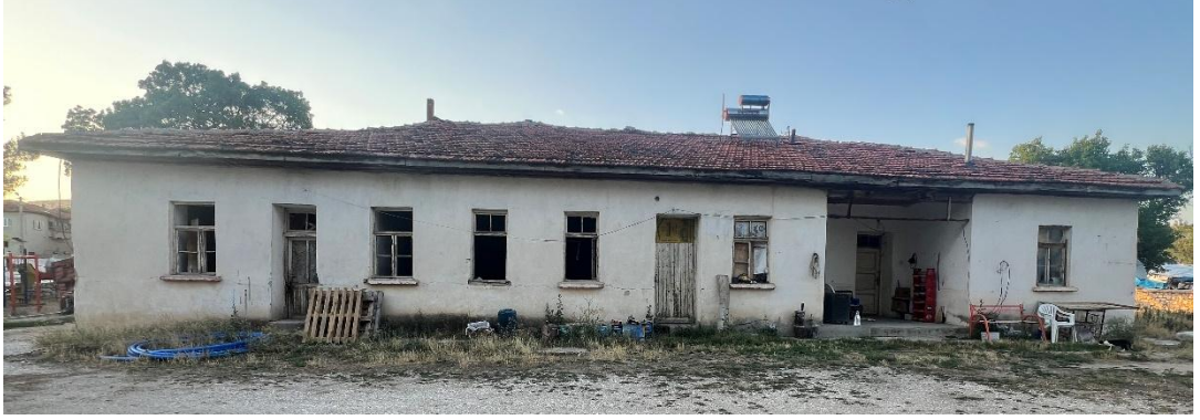
Şekil 6.2.10.1. İğdeli Köyü Okulu Giriş (Güney) Cephe Fotoğrafı (Yılmaz Özev Arşivi, 2024)
