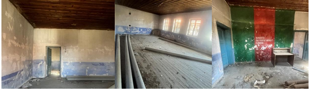
Şekil 6.10.4.10., Şekil 6.10.4.11., 6.10.4.12. Sazak Köyü Okulu İç Mekan Fotoğrafları (Yılmaz Özev Arşivi, 2024)
