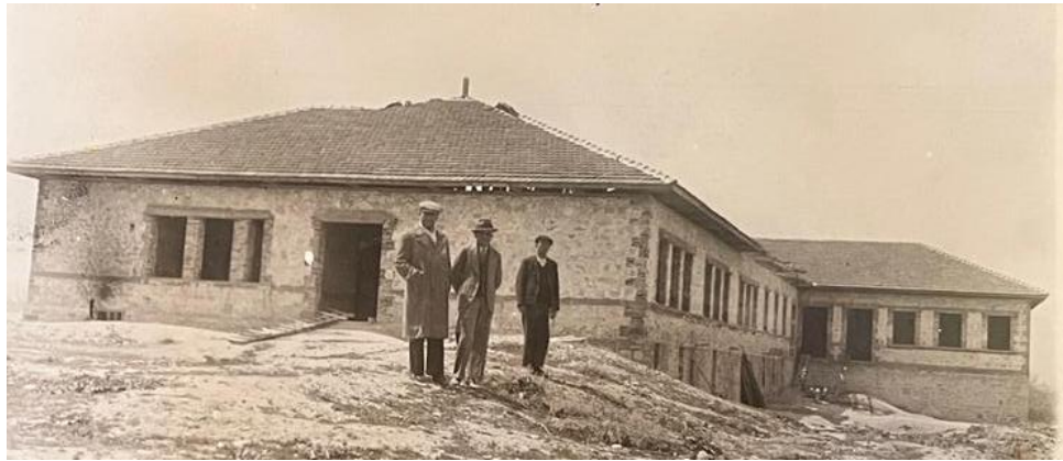
Şekil 6.1.8.3. 1945 Yılında İnşa Edilen Okul Binası İnşaat Sırasında Çekilen Fotoğrafı (Burdur Lisesi Fotoğraf Arşivi, 2025)
