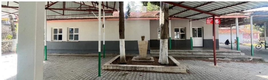
Şekil 6.6.2.1. Çebiş Köyü Birinci Okulu Giriş (Doğu) Cephe Fotoğrafi (Yılmaz Özev Arşivi, 2023)
