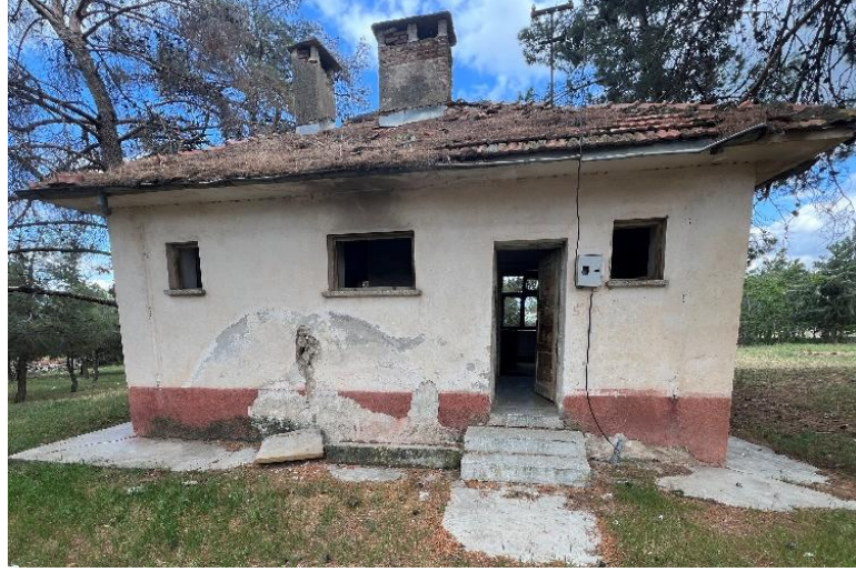
Şekil 6.2.12.16. Karakent Köyü Okulu Öğretmen Evi Kuzeybatı Cephe Fotoğrafı (Yılmaz Özev Arşivi, 2024)
