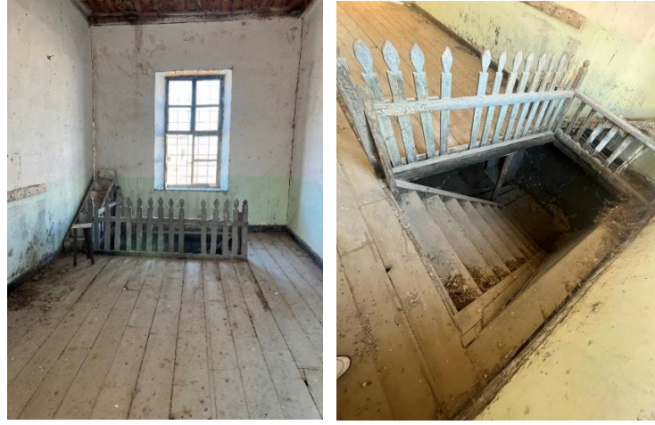
Şekil 6.9.2.18., Şekil 6.9.2.19. Elmacık Köyü Okulu Bodruma İniş Merdiveni Fotoğrafları (Yılmaz Özev Arşivi, 2022)
