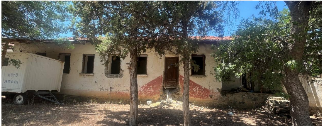
Şekil 6.11.8.1. Yukarı Kırılı Köyü Okulu Giriş (Doğu) Cephe Fotoğrafı (Yılmaz Özev Arşivi, 2024)
