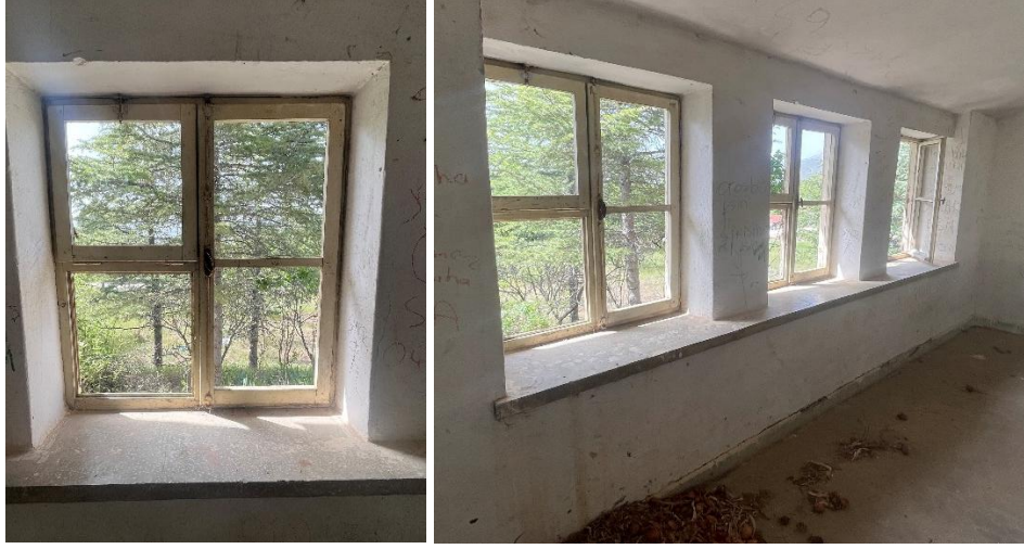
Şekil 6.11.4.7., Şekil 6.11.4.8. Çardak Köyü Okulu Pencere Fotoğrafları (Yılmaz Özev Arşivi, 2024)
