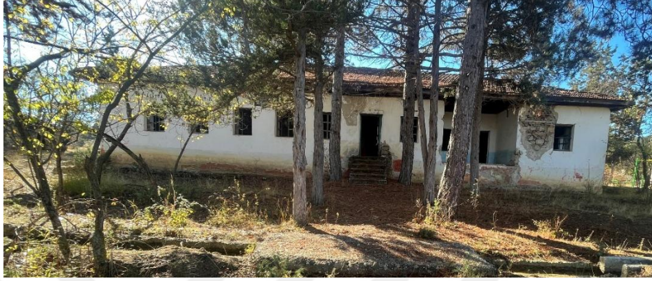
Şekil 6.2.6.1. Bozlar Köyü Okulu Giriş (Kuzey) Cephe Fotoğrafi (Yılmaz Özev Arşivi, 2023)
