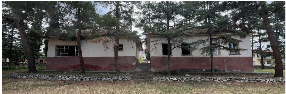
Şekil 6.2.12.5. Karakent Köyü Okulu Kuzeybatı Cephe Fotoğrafı (Yılmaz Özev Arşivi, 2024)
