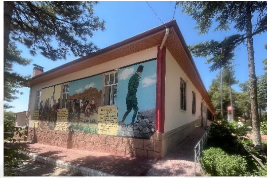
Şekil 6.8.1.6. Devrim Okulu Kuzeydoğu Cephe Fotoğrafı (Yılmaz Özev, 2024)
