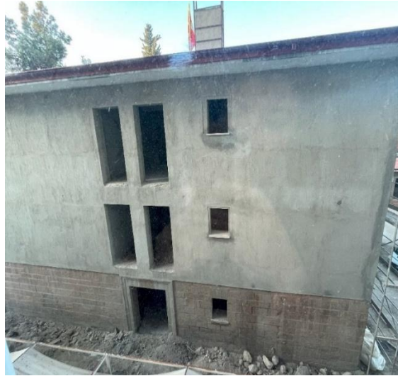
Şekil 6.1.6.10. Kız Sanat Enstitüsü Restorasyon İşlemi Sırasında GüneyCephe Fotoğrafı (Yılmaz Özev, 2022)
