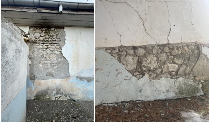
Şekil 6.2.2.13., Şekil 6.2.2.14. Bayındır Köyü Okulu Duvar Detayları (Yılmaz Özev Arşivi, 2023)
