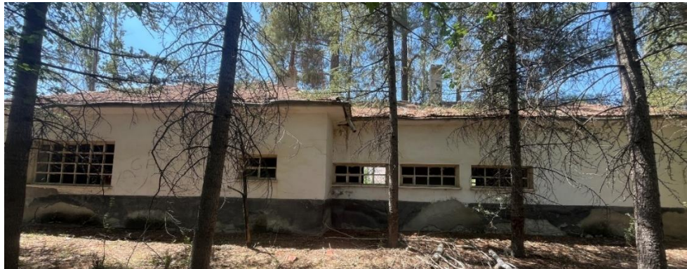
Şekil 6.10.3.17. Hasanpaşa Köyü İkinci Okulu Kuzeydoğu Cephe Fotoğrafı (Yılmaz Özev Arşivi, 2024)
