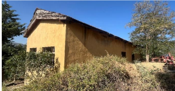
Şekil 6.11.7.6. Karaköy Köyü Okulu Güney Cephe Fotoğrafı (Yılmaz Özev Arşivi, 2024)
