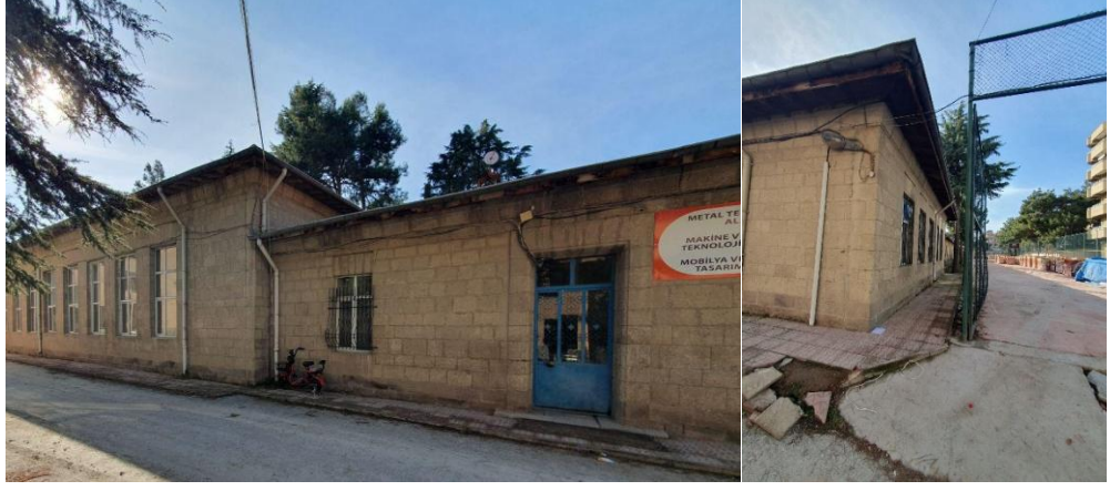
Şekil 6.1.7.4. Erkek Sanat Enstitüsü Doğu Cephe Fotoğrafları (Yılmaz Özev Arşivi, 2023)
