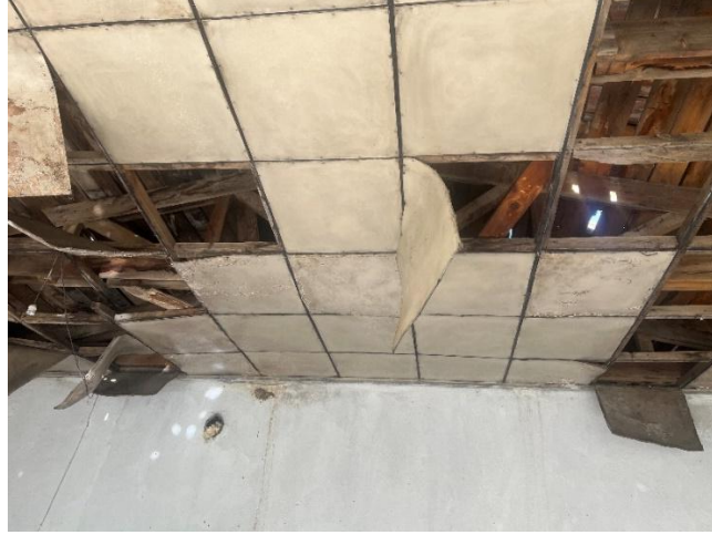
Şekil 6.11.7.9. Karaköy Köyü Okulu Çatı ve Tavan Kaplaması Detay Fotoğrafı (Yılmaz Özev Arşivi, 2024)
