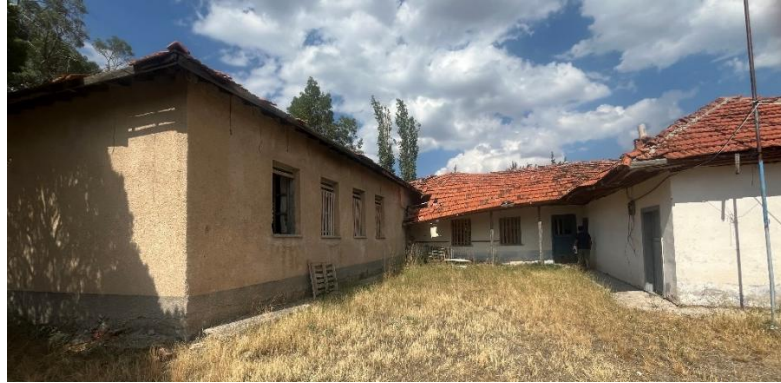
Şekil 6.10.4.4. Sazak Köyü Okulu Batı Cephe ve Ek Binaların Fotoğrafı (Yılmaz Özev Arşivi, 2024)
