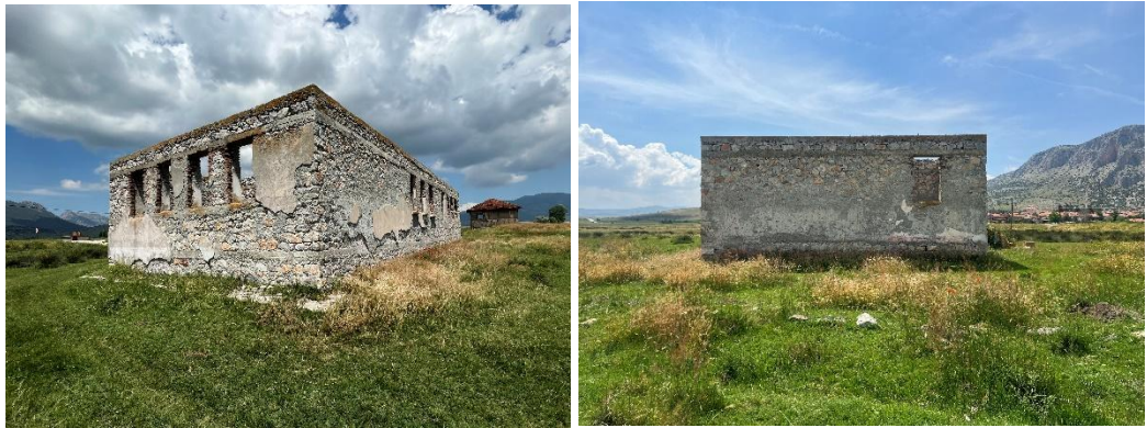
Şekil 6.11.1.4., Şekil 6.11.1.5. Alanköy Köyü Okulu Batı ve Doğu Cephe Fotoğrafları (Yılmaz Özev Arşivi, 2023)
