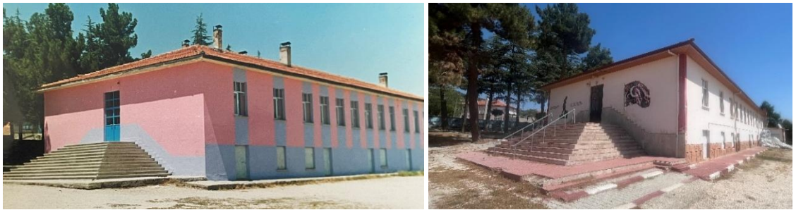
Şekil 6.8.1.7. Devrim Okulu Güneybatı (Öğrenci girişi) Cephe Fotoğrafı (Devrim Okulu Arşivi, 2024)
