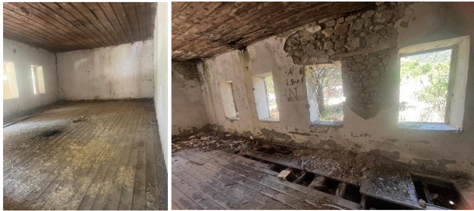
Şekil 6.11.8.9., Şekil 6.11.8.10. Yukarı Kırılı Köyü Okulu İç Mekan Fotoğrafları (Yılmaz Özev Arşivi, 2024)
