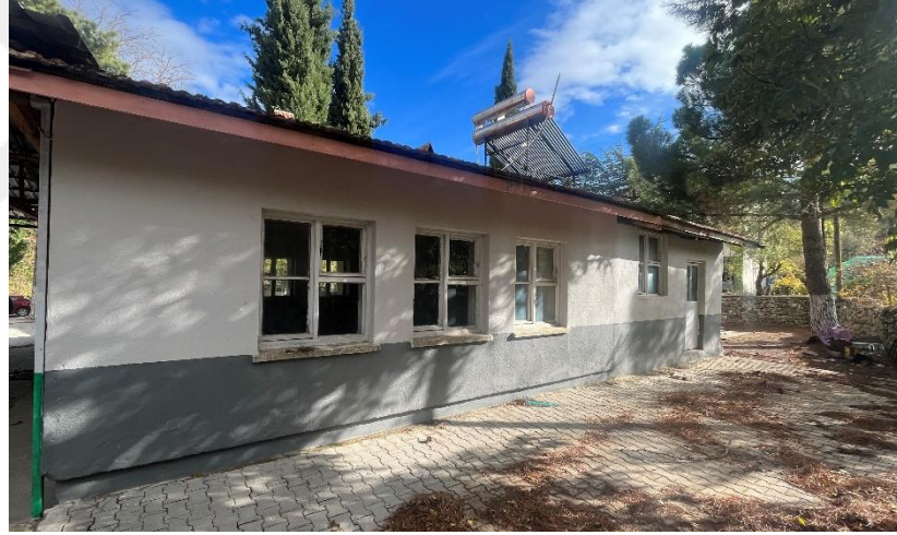
Şekil 6.6.2.6. Çebiş Köyü Birinci Okulu Batı Cephe Fotoğrafı (Yılmaz Özev Arşivi, 2023)
