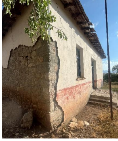
Şekil 6.11.3.6. Bayırbaşı Köyü Okulu Duvar Detayı Fotoğrafı (Yılmaz Özev Arşivi, 2024)
