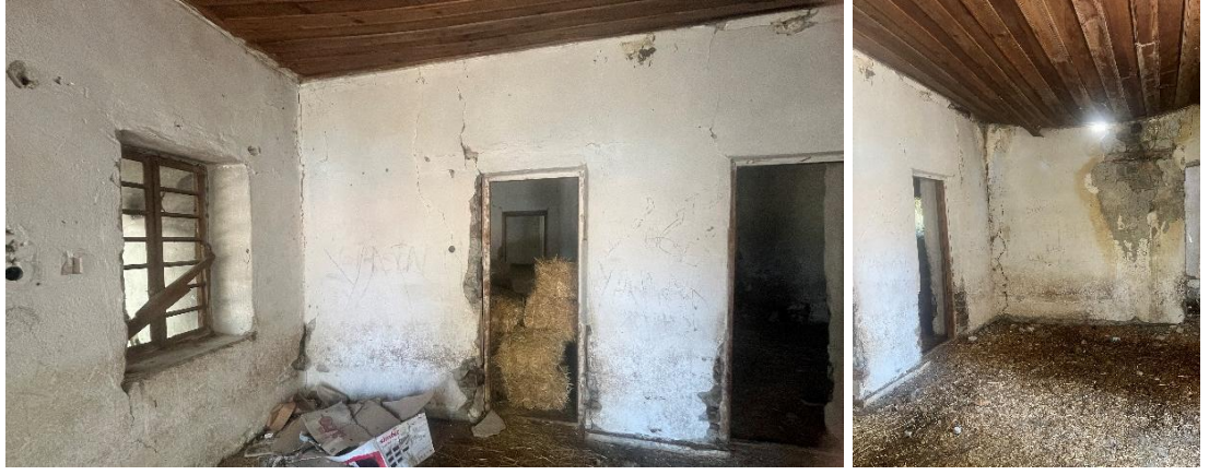
Şekil 6.11.8.11., Şekil 6.11.8.12. Yukarı Kırılı Köyü Okulu İç Mekan Fotoğrafları (Yılmaz Özev Arşivi, 2024)
