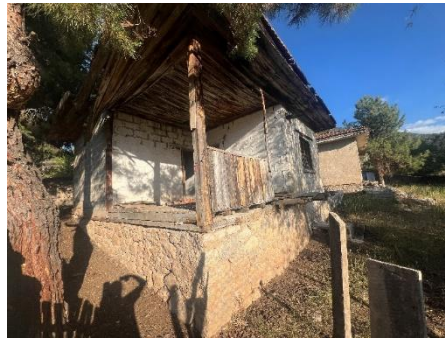
Şekil 6.7.1.11. Kuşdili Köyü Okulu Öğretmen Evi Fotoğrafı (Yılmaz Özev Arşivi, 2024)
