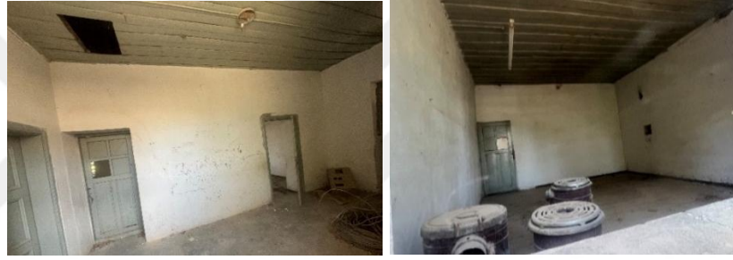
Şekil 6.10.2.15., Şekil 6.10.2.16. Ece Köyü Okulu İç Mekan Fotoğrafları (Yılmaz Özev Arşivi, 2024)
