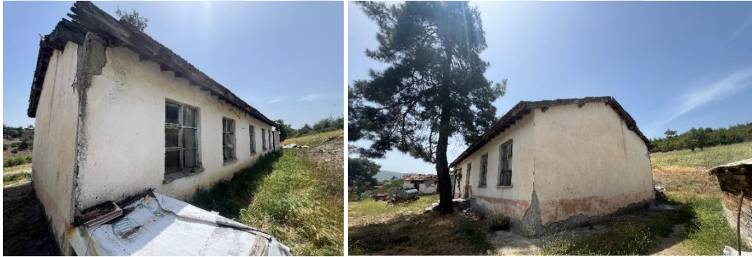
Şekil 6.2.7.5., Şekil 6.2.7.6. Cimbilli Köy Okulu Kuzeybatı ve Kuzeydoğu Cephe Fotoğrafları (Yılmaz Özev Arşivi, 2024)
