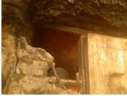
Resim 7.9. Yenişehir Çifte Hamam'da ocağın üstündeki bakır kazan
