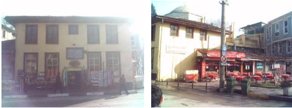
Resim 6.13. Yeşil Hamamı kuzey ve kuzeybatı görünüşü
