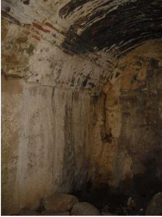
Resim 5.40. Su deposu mekanı
