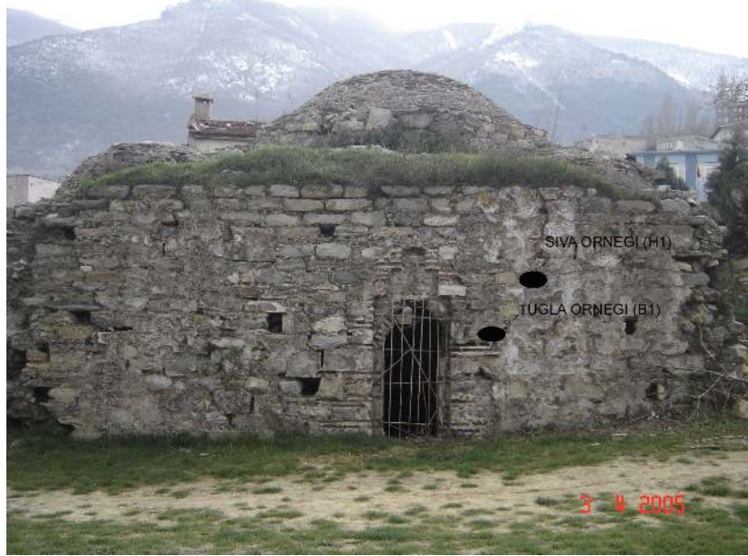
Resim 2.1. Kuzey cephe siva örneği (H1) ve tuğla örneği (B1)
