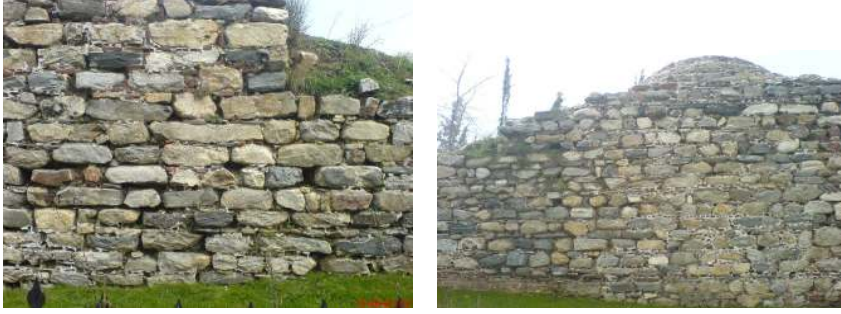
Resim 4.3. Moloş taş, tuğla kırığı ve derz harcı
