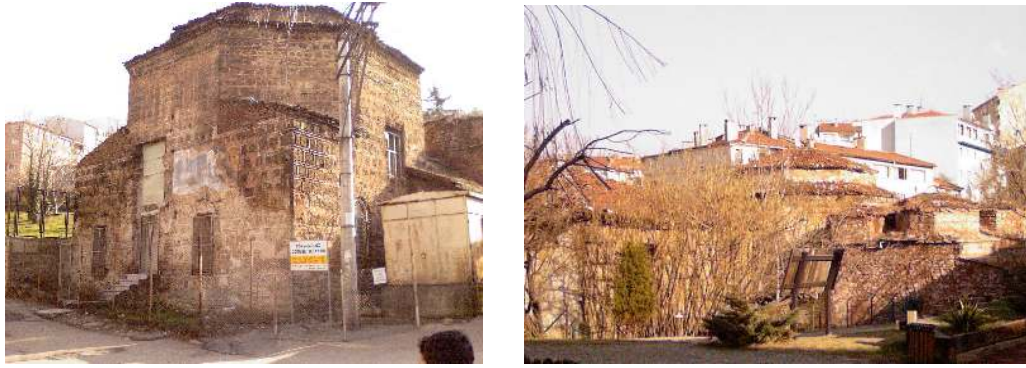
Resim 6.9. Umurbey Hamamı kuzey ve güneydoğu görünüşü
