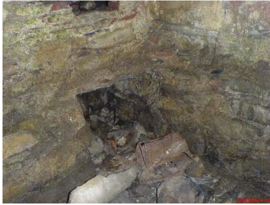
Resim 7.6. Halvette cehennemlik kanalı
