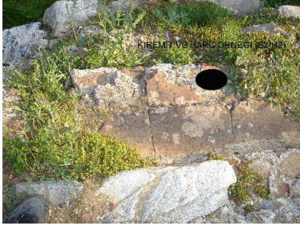
Resim 2.6. Su deposu bölümü tonoz üstü kiremit ve harç örneği (S2-H2)
