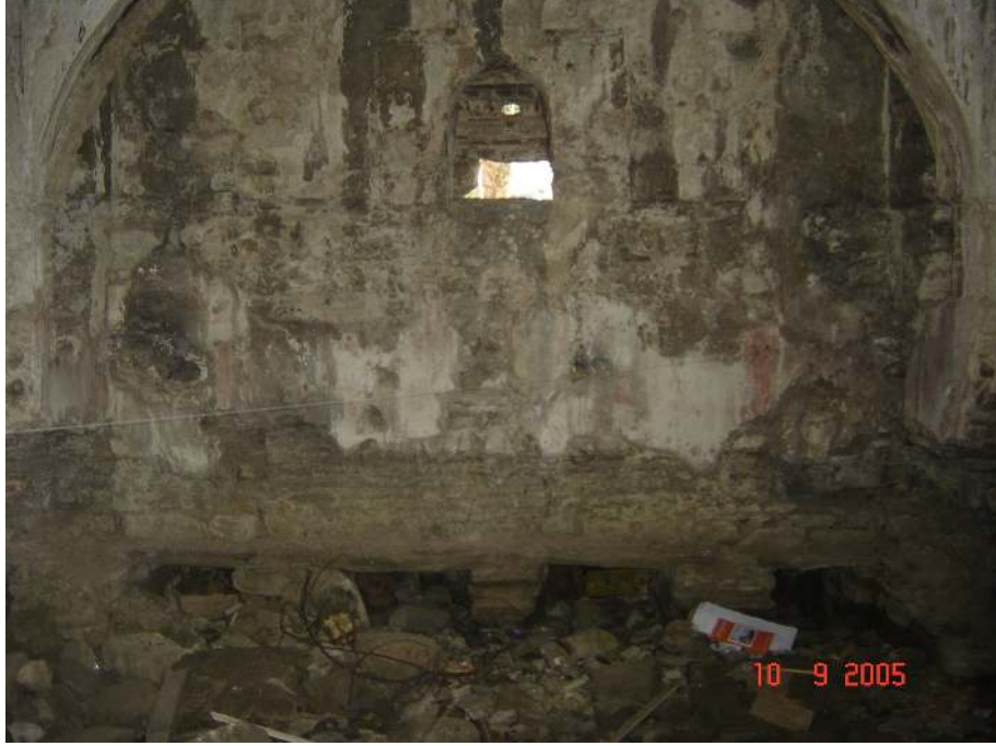
Resim 5.31. Sıcaklık mekanını cehennemlik kanalları
