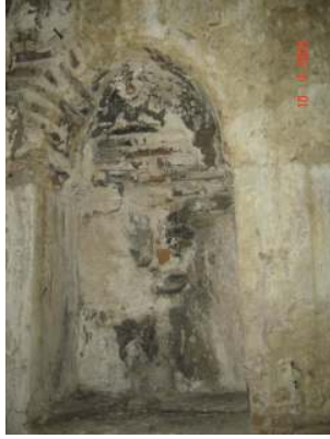
Resim 4.2. M04 mekanı N1 nişinde sivri kemer
