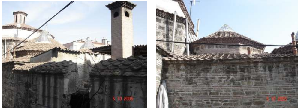
Resim 6.7. Muradiye Hamamı güneybatı ve batı görünüşü
