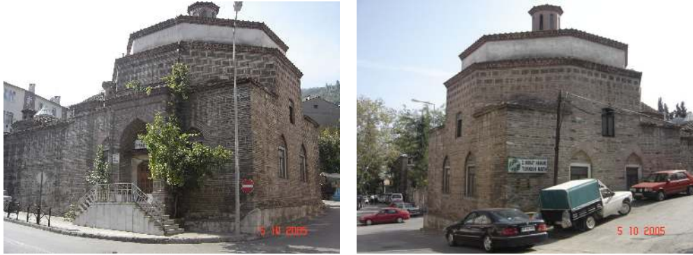
Resim 6.6. Muradiye Hamamı kuzeybatı görünüşleri
