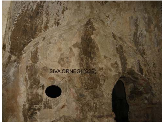
Resim 2.2. Soğukluk bölümü güney duvarı siva örneği (S2B)
