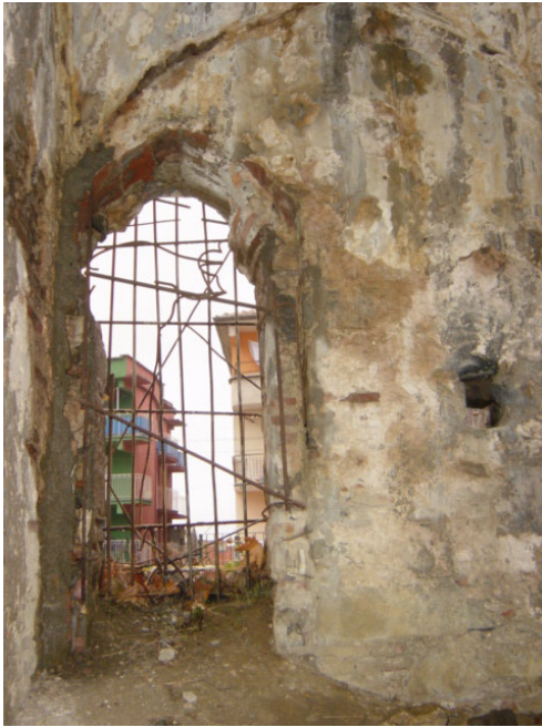
Resim 5.24. Hamamın giriři (Ilıklık mekanından görünüşü)
