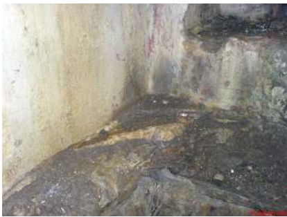
Resim 7.17. Özgün döşeme kotu (mermer izi)
