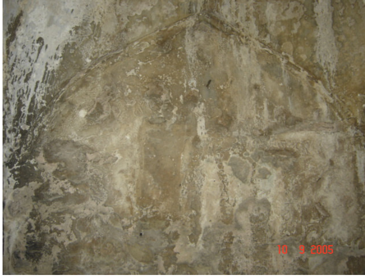
Resim 5.29. Hela ve tıraşlık mekanı güney duvarı
