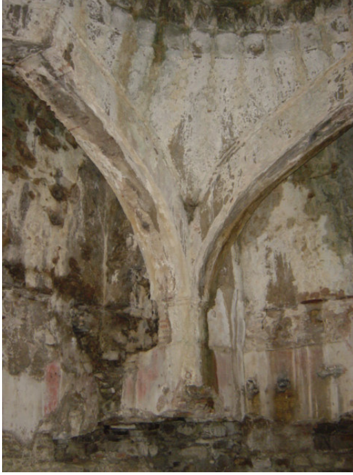
Resim 5.38. Sıcaklık mekanını güneydoğu duvarı
