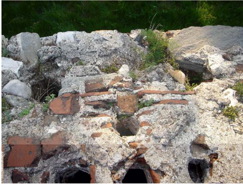
Resim 5.12. Sıcaklık mekanı batı duvarında künk
