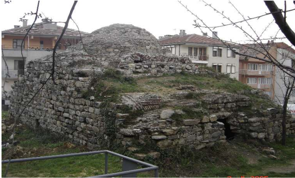
Resim 5.22. Sıcaklık kubbesi ve küllhan tonozu
