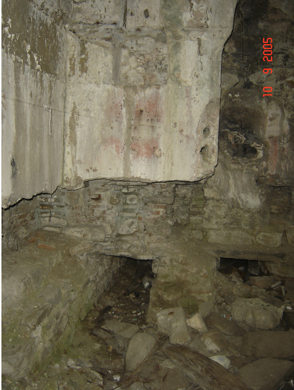
Resim 5.37. Sıcaklık mekanı güneydoğu köşesi cehennemlik kanalları, döşeme ve niş
