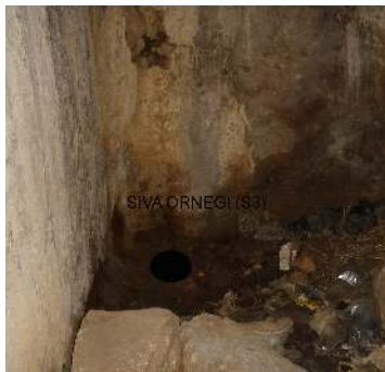
Resim 2.5. Su deposu bölümü zemin siva örneği (S3)
