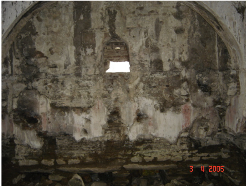
Resim 5.30. Sıcaklık mekanı güney duvarı
