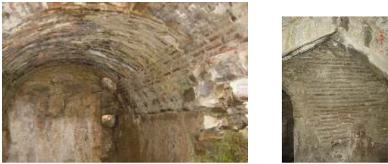
Resim 4.6. Tonoz ve ilıklık ile hela arasındaki bölme duvarda tuğla kullanımı
