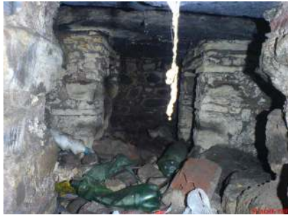
Resim 7.10. Su deposu cehennemlik kanalı
