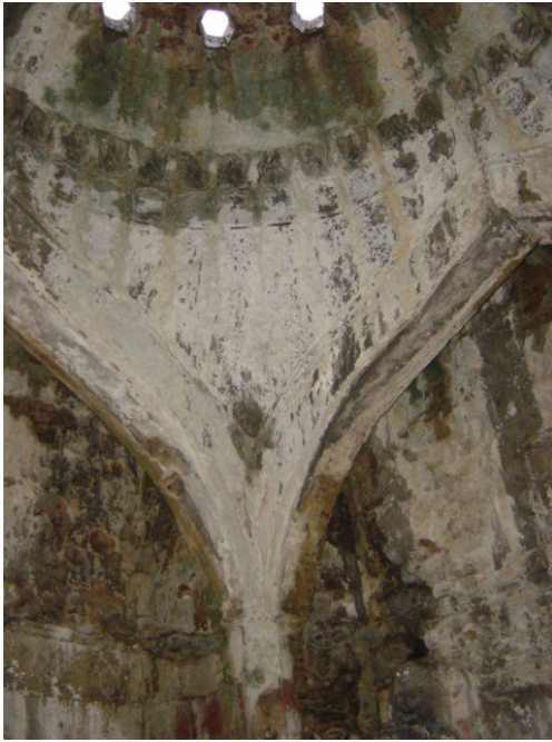
Resim 5.39. Sıcaklık mekanını pendentifinden görünüş
