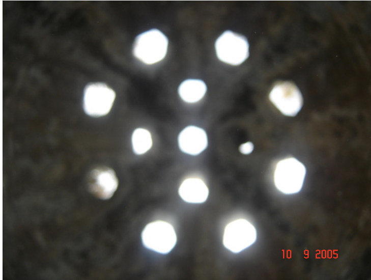
Resim 5.43. Ilıklık mekanı kubbesi
