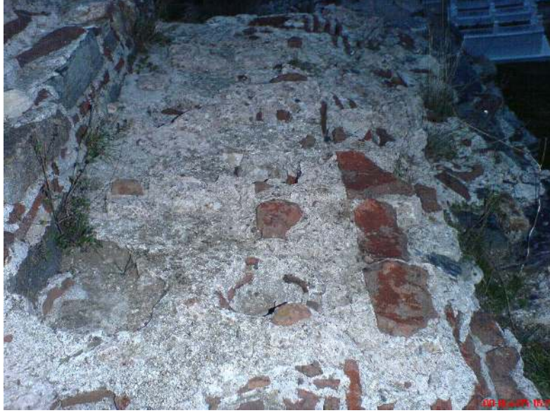
Resim 5.13. Sıcaklık mekanı batı tonozu üstünde kiremit izi
