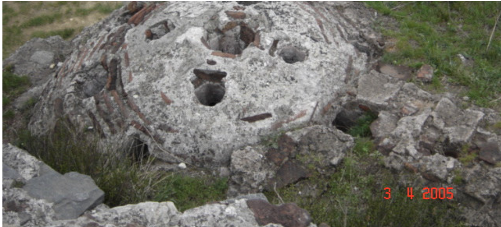
Resim 5.14. Ilıklık ve halvet mekanı arasındaki duvarda künk izi
