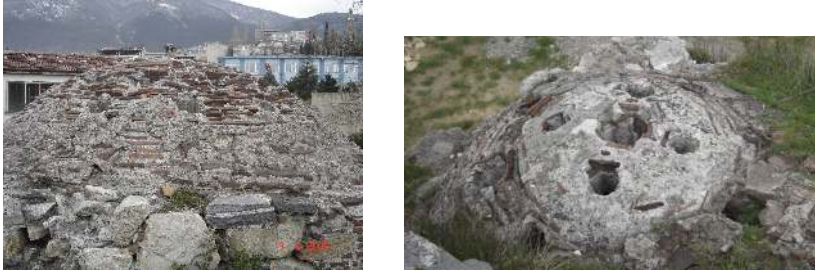
Resim 4.4. Kubbede tuğla kullanımı
