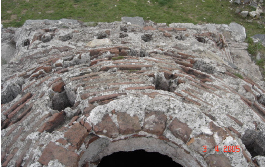
Resim 5.19. Sıcaklık mekanı kubbesi ve doğu tonozu
