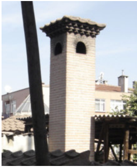
Resim 7.8. Muradiye Hamamı külhan bölümündeki baca görünüşü
