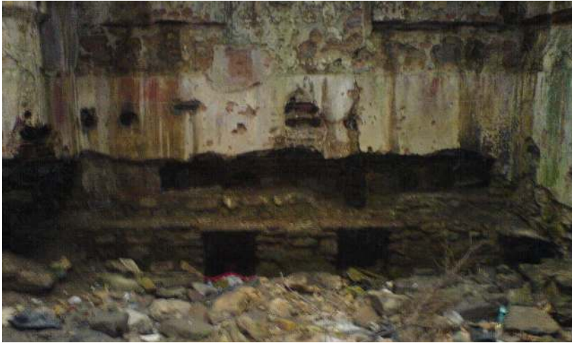
Resim 7.4. Duman kanalı izi
