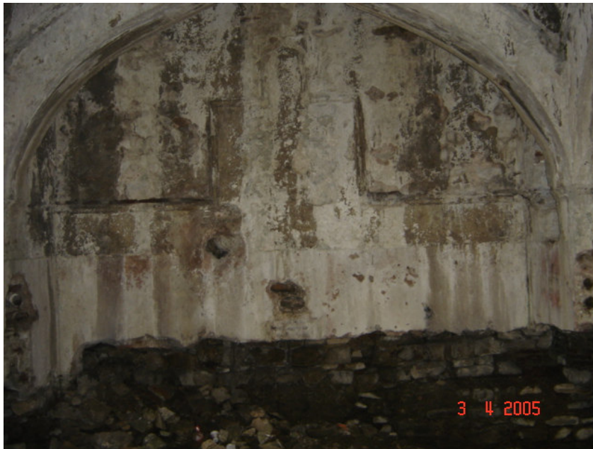
Resim 5.36. Sıcaklık mekânını doğu duvarı
