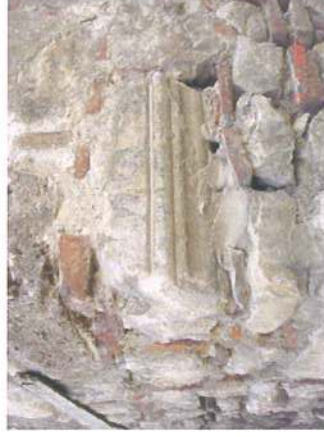
Şekil 4.82 Arka cephe duvarı taş blok detayı
