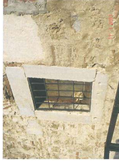
Şekil 4.85 Sol yan cephe penceresi
