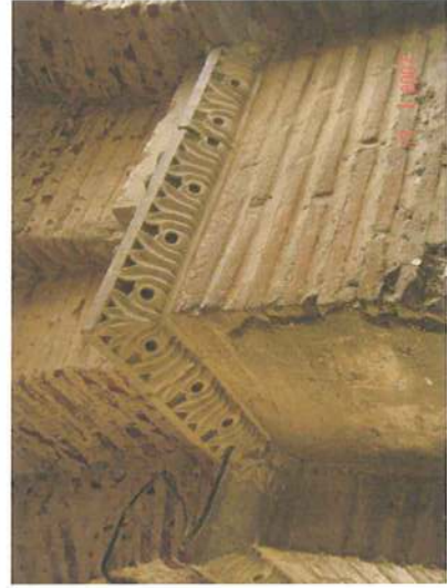
Şekil 4.46 Üst kat ön cephe mermer korniş detayı
