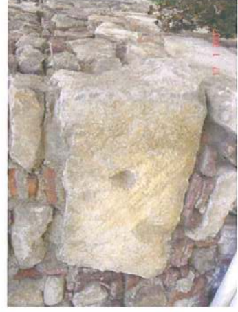
Şekil 4.83 Arka cephe duvarı taş blok detayı
