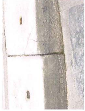
Şekil 4.14 Dış cephe sütunu
