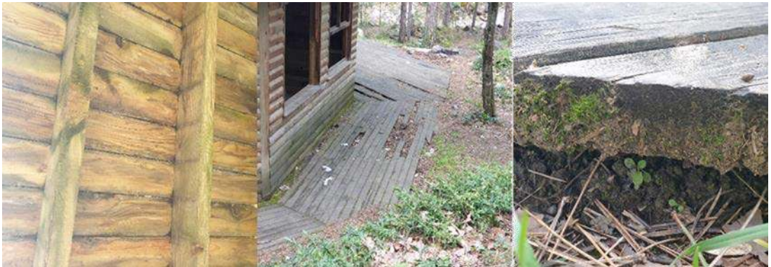
Şekil 3.28 : Bursa Şehir Ormanı ahşap malzemenin deformasyonu (Derya İlhan kişisel arşivi, 2020).
