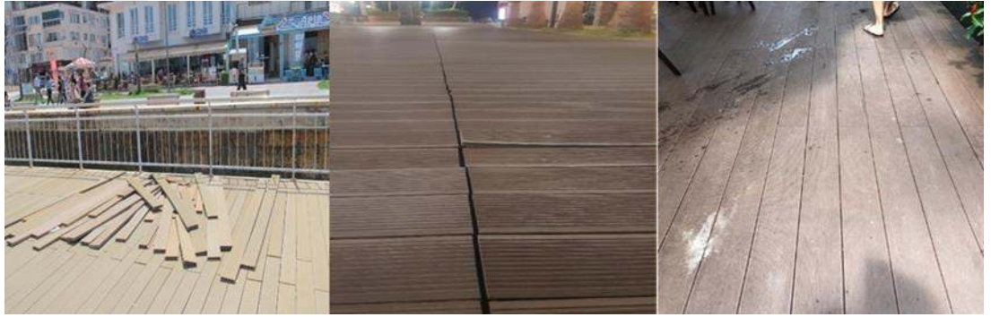
Şekil 3.45 : WPC malzeme kullanılan yerlerde oluşan deformasyon (Derya İlhan kişisel arşivi, 2021).
