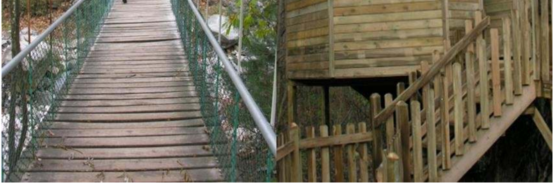
Şekil 3.25 : Bursa Şehir Ormanı ahşap donatı 2010 durumu (BOBM arşiv verileri, 2020).
