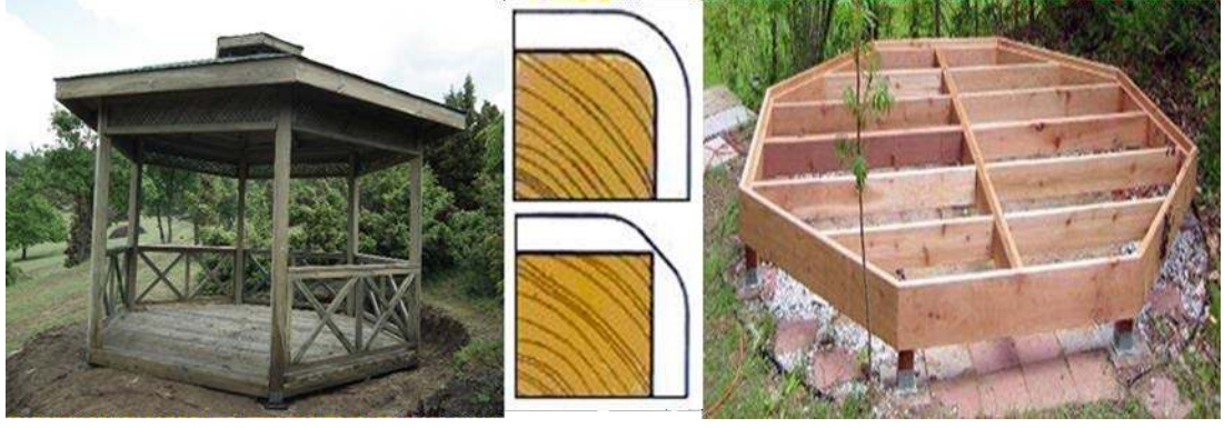
Şekil 1.10 : Kamelya, pergola ve zemin döşemelerde ahşap ile zemin arasında boşluk bırakılması (Url-25).
