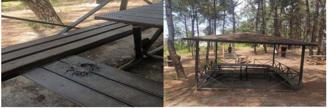
Şekil 3.44 : Güzelyalı Mesire Alanı'nda kullanılan WPC malzeme (Derya İlhan kişisel arşivi, 2021). Ahşabın bakım amaçlı zımparalanma ve boyanması söz konusu iken WPC bir malzemede detaylı bir zımpara ve boya ile tadilat yapmak mümkün değildir.
