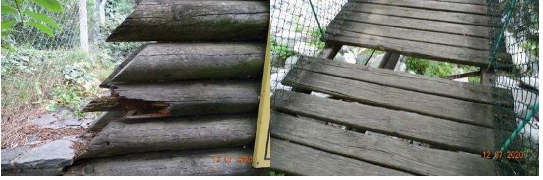
Şekil 3.43 : Bursa Şehir Ormanı yıpranmış ahşap donatı örneği (Derya İlhan kişisel arşivi, 2020).
