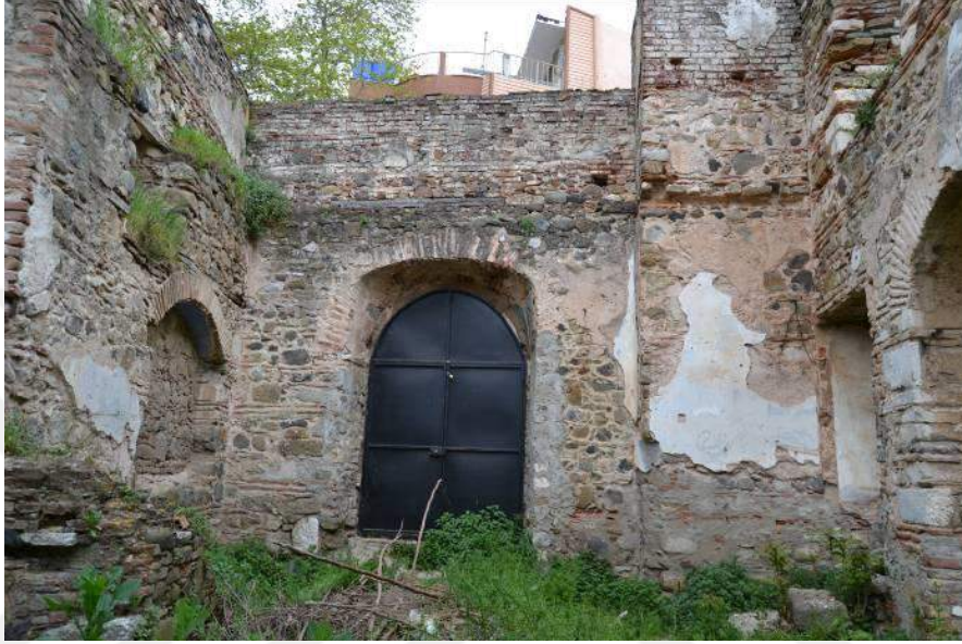
Resim 66. H Mekanının (Giriş Mekanı) Kapısı, Batıya Bakış (2015)
