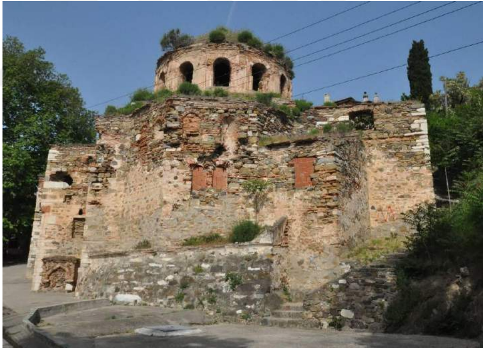
Resim 69. Doğu Cephe Yüzeyleri, Batıya Bakış (2015)
