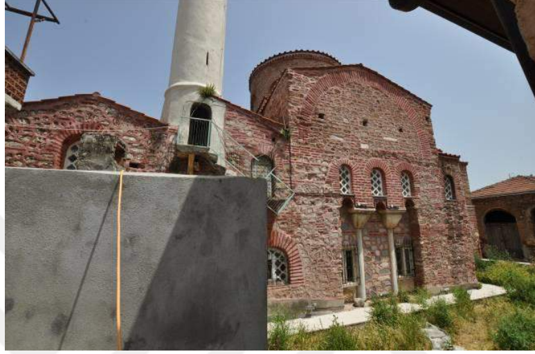
Resim 217. Tirilye Fatih Camisi, Güney Cephe, Kuzeydoğuya Bakış (2015)
