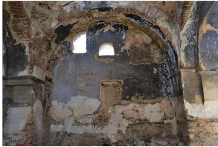
Resim 39. Naos Güney Duvar, Güneye Bakış (2015)
