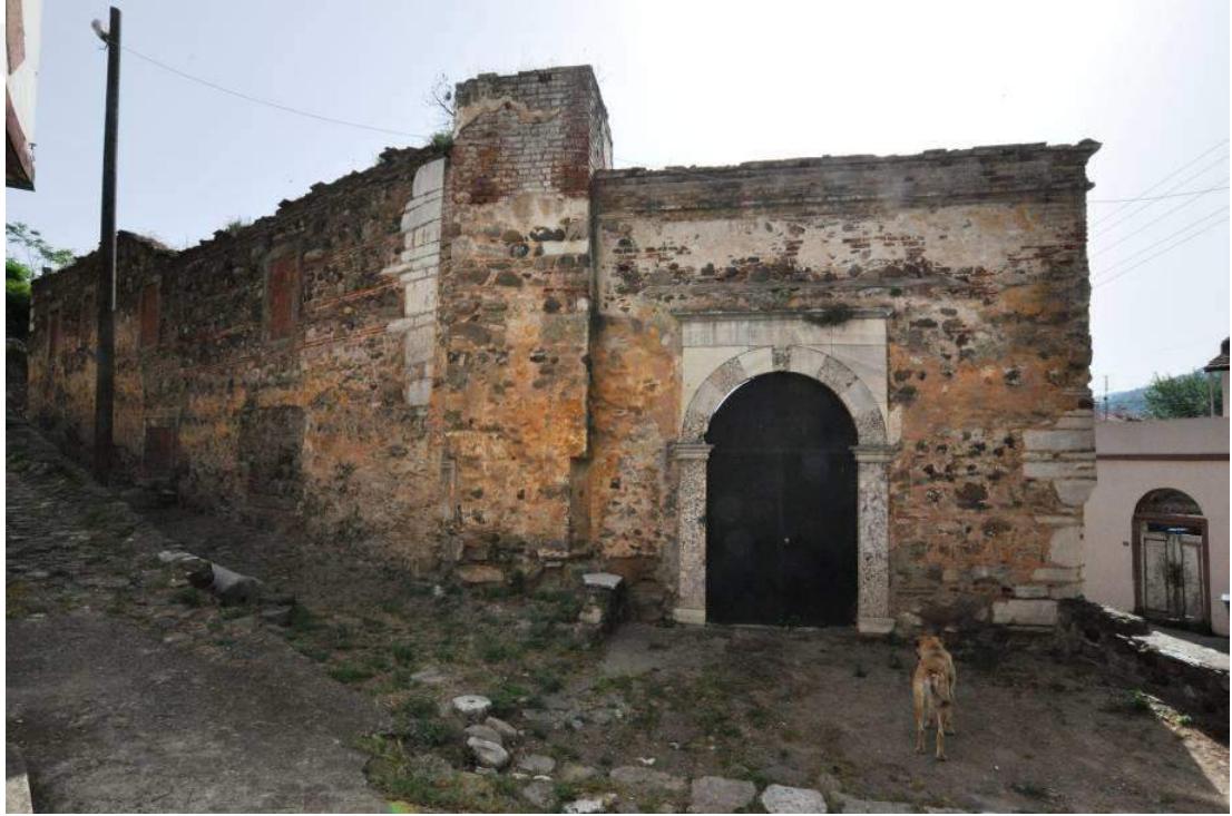
Resim 78. Batı Cephe, Genel Görünüş, Doğuya Bakış (2015)
