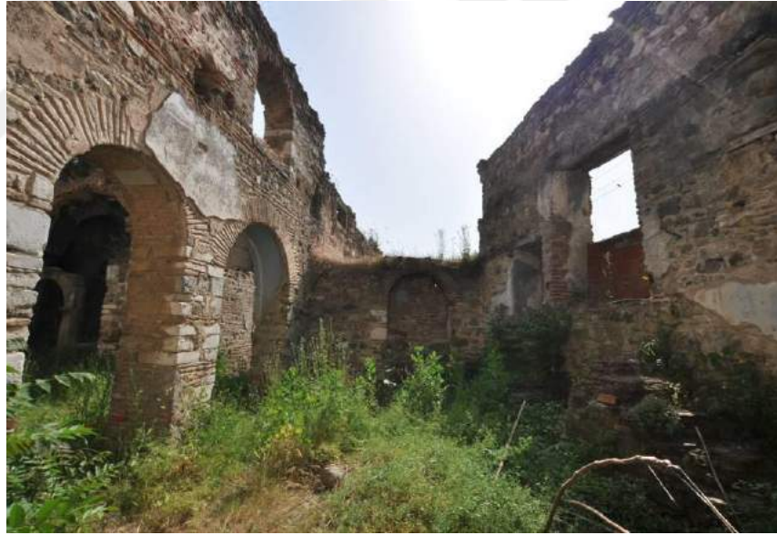
Resim 36. H Mekanı (Giriş Mekanı), Doğuya Bakış (2015)
