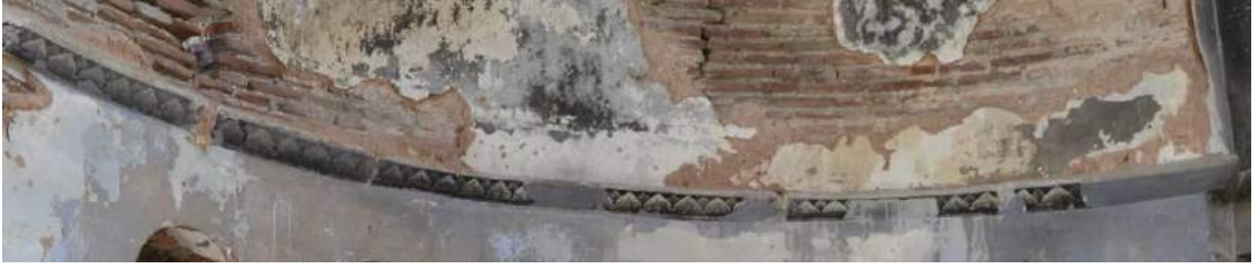
Resim 91. Apsisteki Silme, Güneydoğuya Bakış (2015)
