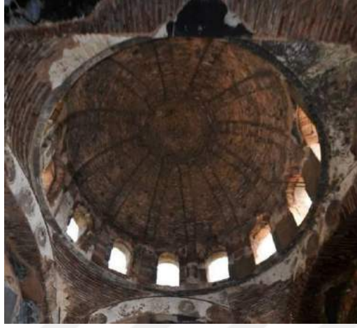
Resim 40. Kubbe Kasnağındaki Pencere, Kuzeye Bakış (2015)
