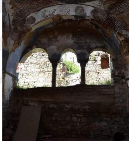
Resim 229. Naos, Kuzey Duvar, Kuzeye Bakış (2015)
