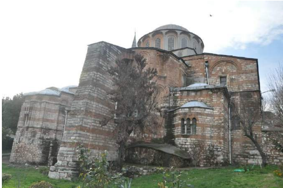
Resim 216. İstanbul Khora Manastırı Kilisesi, Kuzeydoğuya Bakış (2013)
