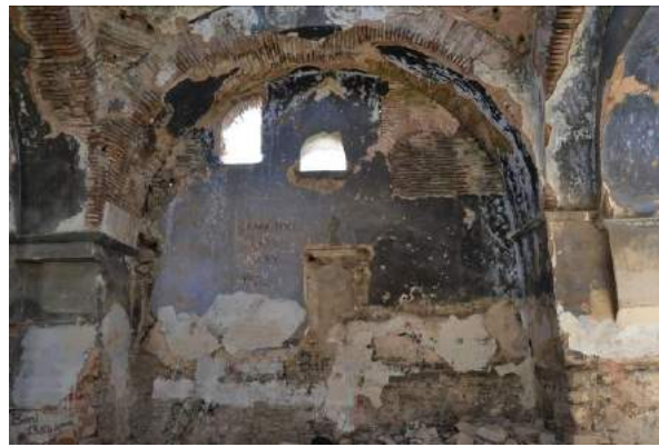
Resim 230. Naos, Güney Duvar, Güneye Bakış (2015)
