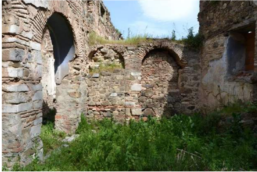
Resim 68. H Mekanı (Giriş Mekanı), Kemerler, Doğuya Bakış (2015)
