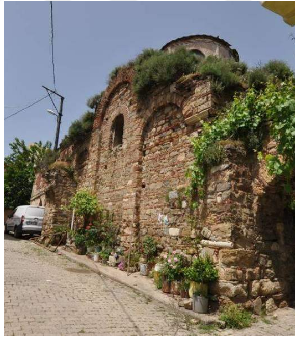
Resim 218. Trilye, Panagia Pantobasilissa (Kemerli) Kilisesi, Güney Cephe, Kuzeybatıya Bakış (2015)
