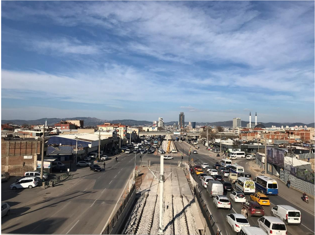
Şekil 4.101: Kent Meydanı - Terminal arasında hizmet veren T2 hattı
