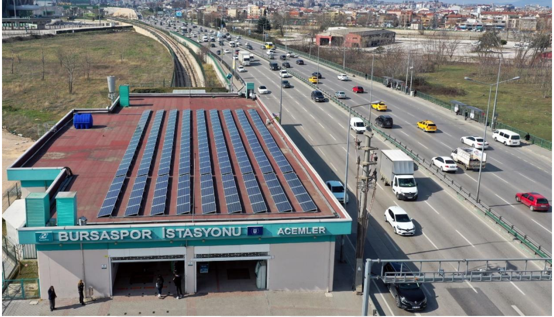
Şekil 4.104: Bursaray istasyonu üzerine kurulmuş bir güneş enerjisi santrali
