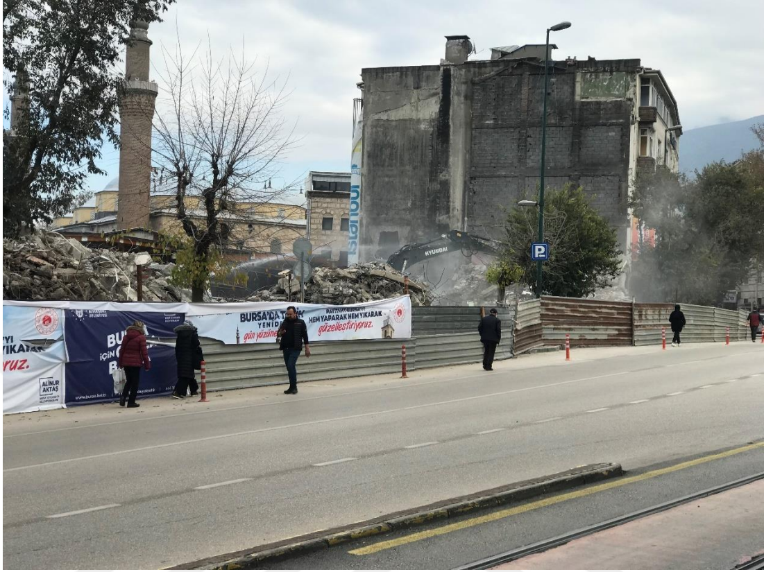
Şekil 4.133: Tarihi Kapalı Çarşı ve Hanlar Bölgesi'nde yapılan bir bina yıkımı
