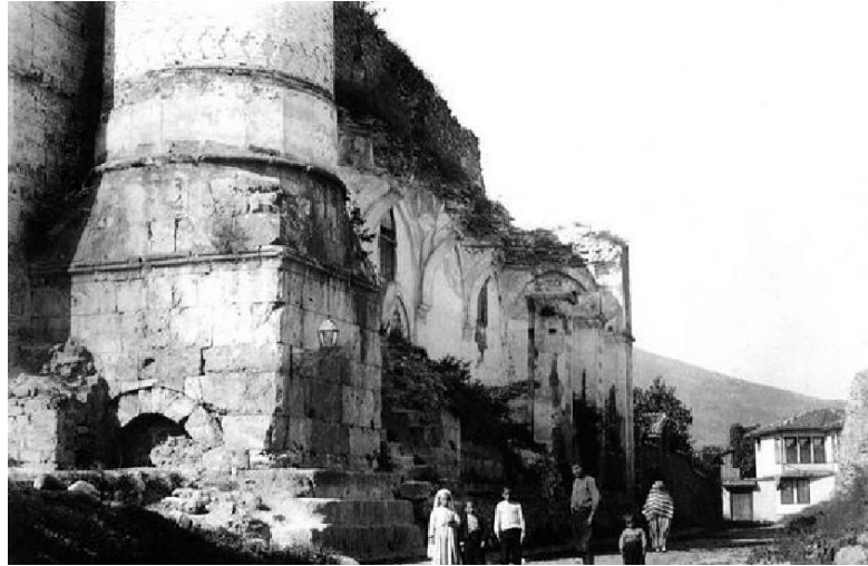
Şekil 3. 20 Ulu Camii’nin 1855 depreminde gördüğü hasar [40]
