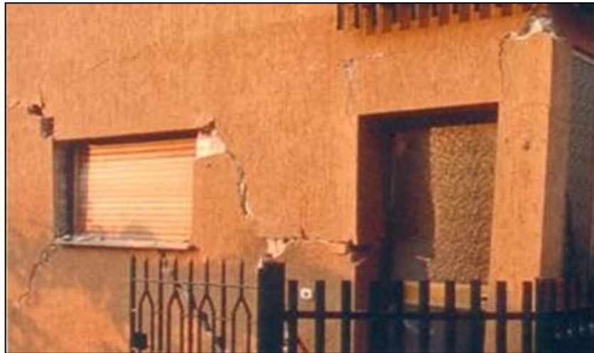
Şekil 1.33 Donatısız taşıyıcı duvarlarda kritik alanları
