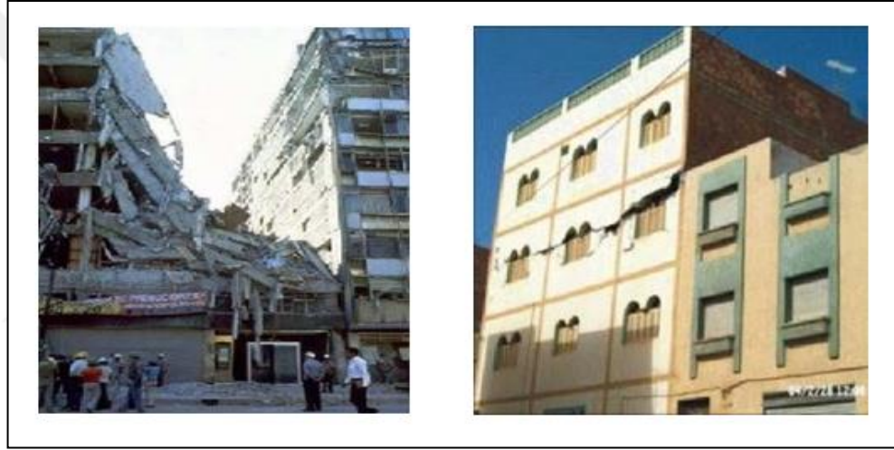
Şekil 1.31 Yetersiz sismik derz genişliği nedeniyle bina çarpışması
