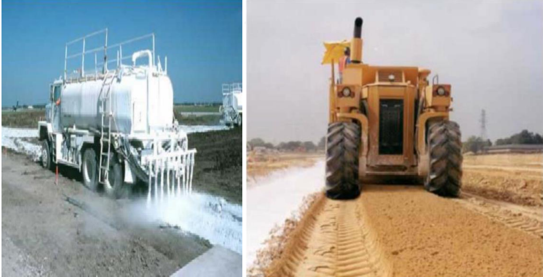
Şekil 3.3. Kireç ile stabilizasyon
