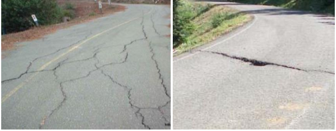
Şekil 3.2. Karayollarında zemin iyileştirme gerekliliği
