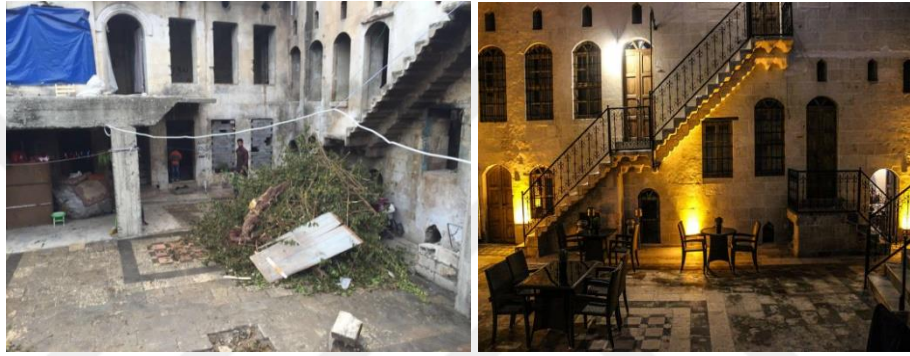
Şekil 68. Aynur Hanım Konağı restorasyon öncesi ve sonrası avlu( www.aynurhanimkonak.com )
