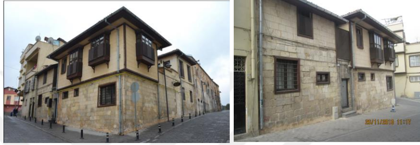
Şekil 133. Arif Bey Konağı cephe görünüm ve lokasyon(www.ekentrehber.sahinbey.bel.tr,2018)
