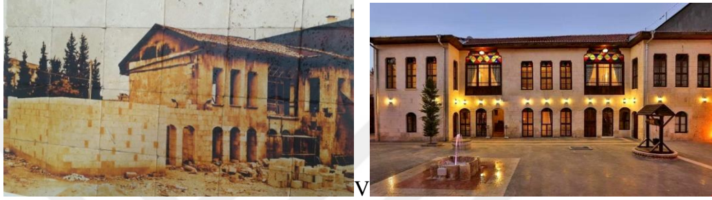
Şekil 54. Alibey Konağı restorasyon öncesi 1. Konak cephe görünüm(Mimar Barış Gören arşivi,2018)
