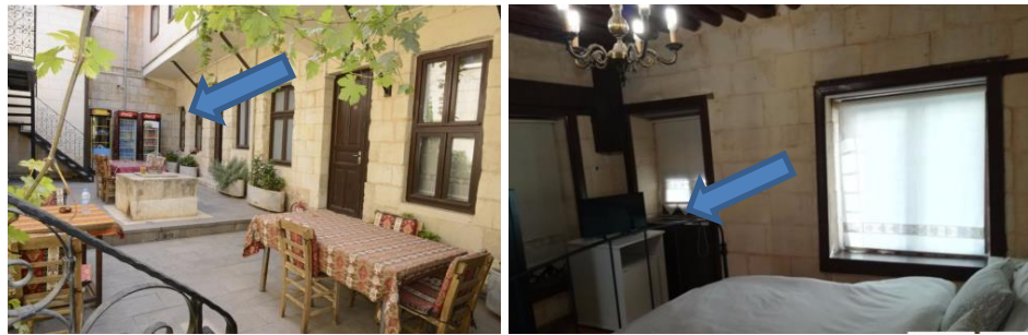
Şekil 136. Arif Bey Konağı Problem( www.arifbeykonagibutikotel.com )
