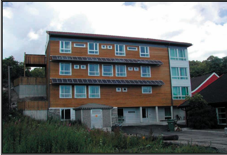
Resim 3.1. Vest-Adger Klinikken güneş panellerinin uygulandığı cephe resmi [Lundgren ve Torstensson, 2004]
