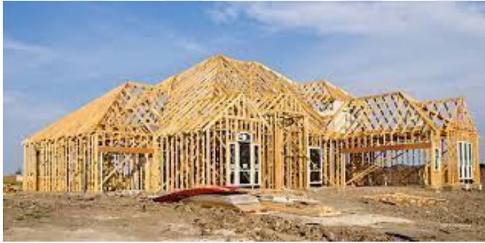
Resim 2.4. Ahşap yapı iskeleti (URL-3)
