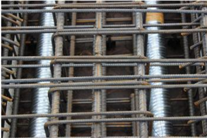
Resim 2.6. Betonarme kirişlerde ard germe (URL-10)
