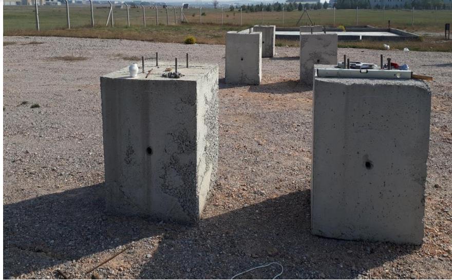
Şekil 6.9. 1x1x1 metrelik beton blokların yerleştirilmesi
