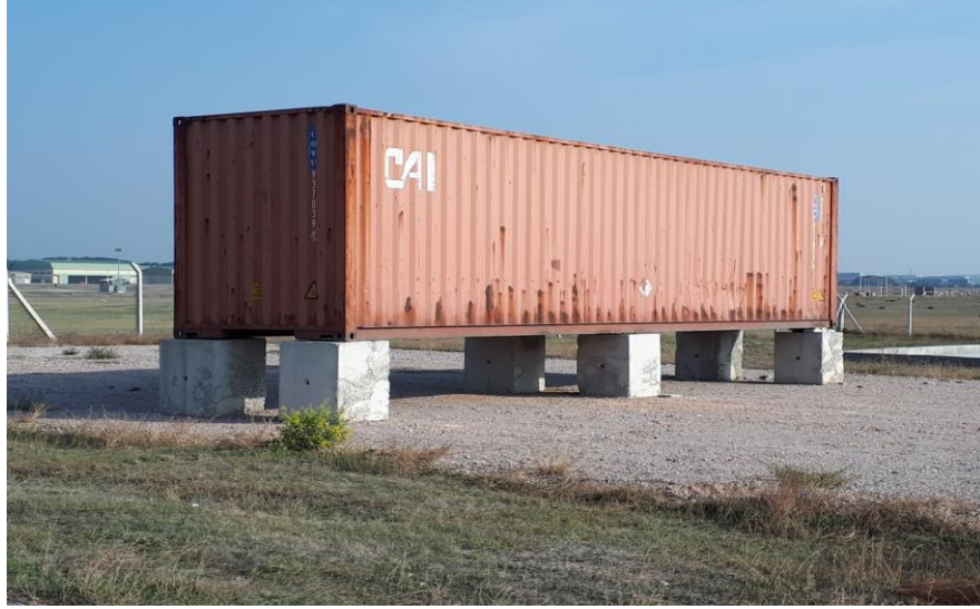
Şekil 6.16. Beton bloklar üzerine yerleştirilmiş konteyner
