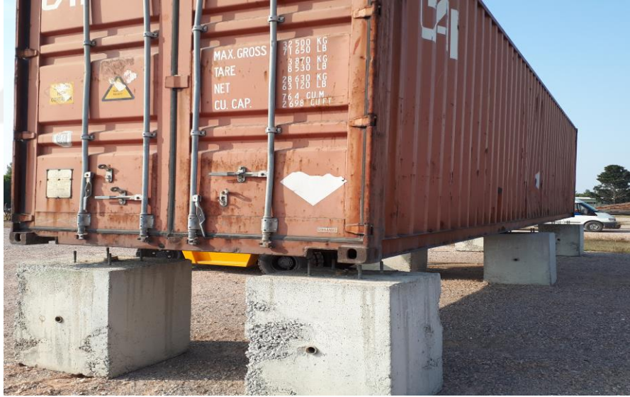
Şekil 6.15. Konteyner'in beton bloklar üzerine yerleştirilmesi
