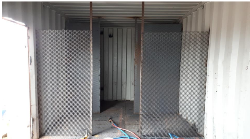
Şekil 6.20. Mutfak, tuvalet ve kokpit bölmelerinin yapım çalışmaları
