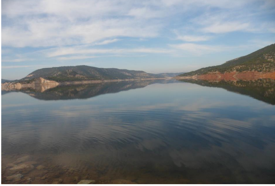
Şekil 2.1.1.5: Adıgüzel Barajı'na ait genel görünüş.
