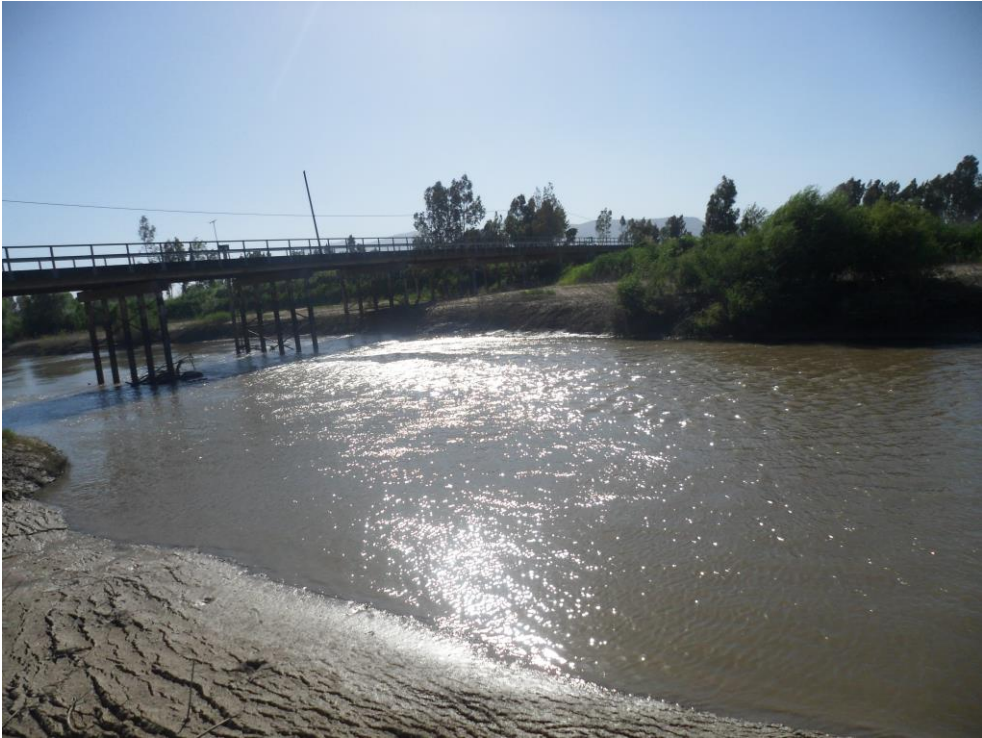
Şekil 2.1.1.10: Söke Büyük Menderes köprüsüne ait genel görünüş.
