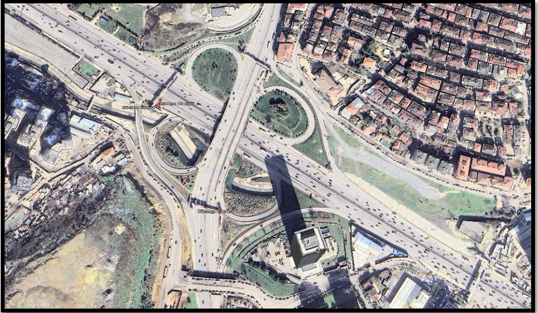
Şekil 5.2 D100 Karayolu Göztepe Kavşağı üstten görünüm
