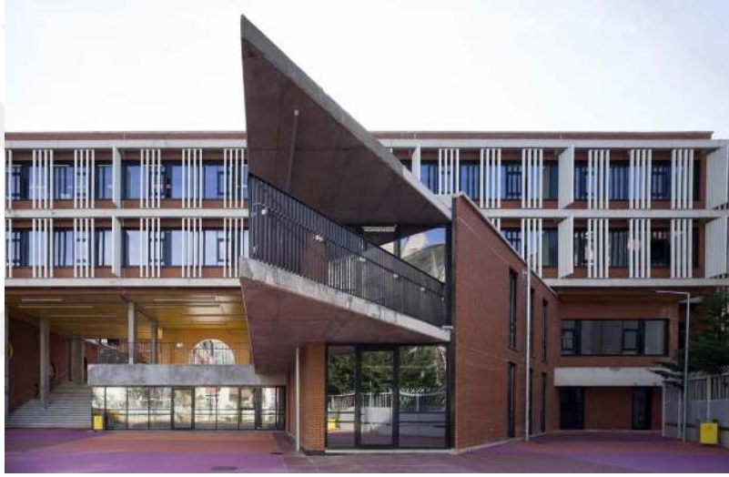
Şekil 64. Silivri Ortaokulunun Sivrililiğiyle Öne Çıkan Bölümü
