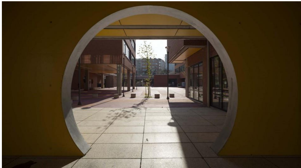
Şekil 65. Silivri Ortaokulu Yapısında Bulunan Devasa Geometrik Boşluklar
