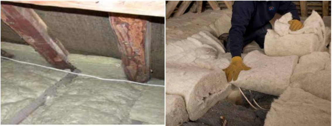
Şekil 2.41. Tarihi Çatılarda Yalıtım Uygulamaları (Historic England, 2011b).
