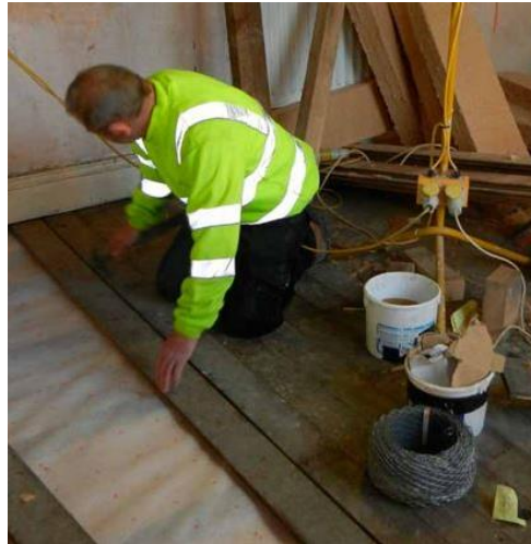
Şekil 2.44. Tarihi ahşap kirişli döşemede yalıtım uygulaması (Historic England, 2011c).
