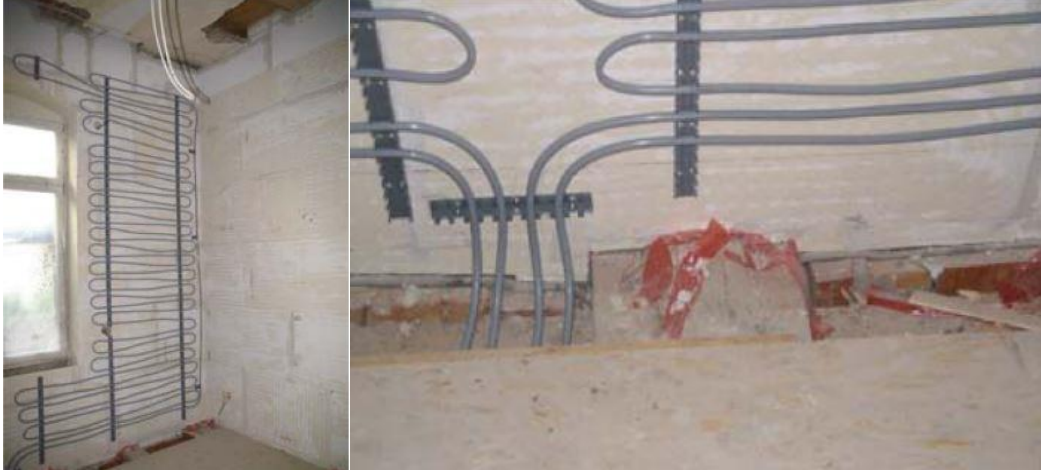
Şekil 2.46. Tarihi yapılarda duvardan ısıtma tekniği ve uygulanması (3ENCULT, 2009).
