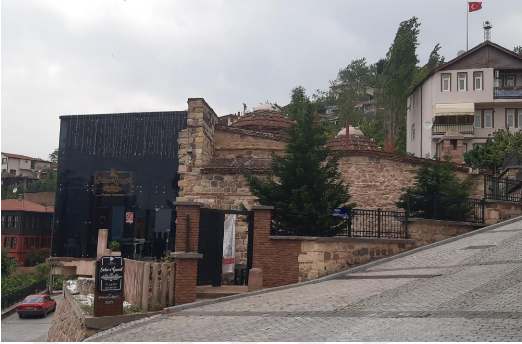
Şekil 3.8. Süleyman Paşa Hamamı Restorasyon Sonrası (Kişisel Arşiv).
