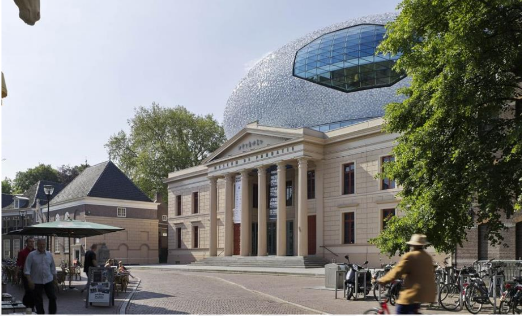
Şekil 2.27. Fundatie Müzesi Ek Yapısı (URL-17).
