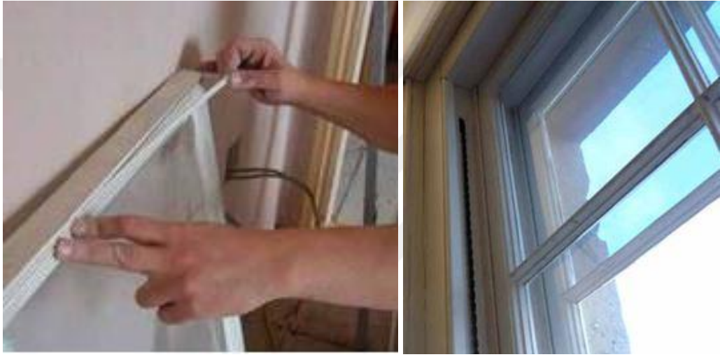
Şekil 2.45. Pencerelerde yalıtım uygulamaları (Historic England, 2016c).
