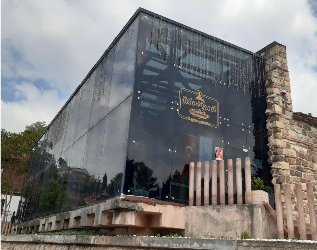
Şekil 3.9. Süleyman Paşa Hamamı Restorasyon Sonrası (Kişisel Arşiv).
