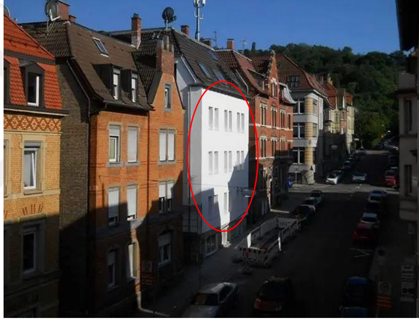
Şekil 2.35. Tarihi yapılarda yalıtımlı dış sıva uygulaması, Stuttgart, Germany (URL-21).
