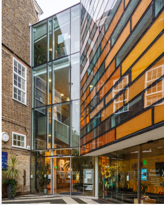
Şekil 2.32. Clapham Manor İlköğretim Okulu (URL-20).
