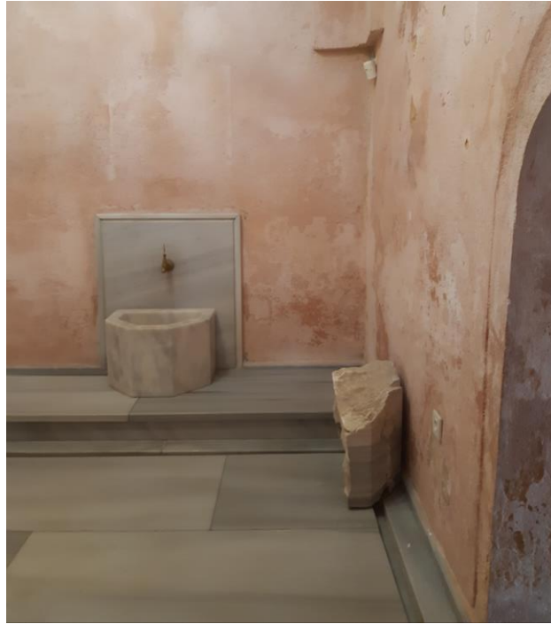
Şekil 3.12. Süleyman Paşa Hamamı Sıcaklık Mekanı Kurna Detayı (Kişisel Arşiv).
