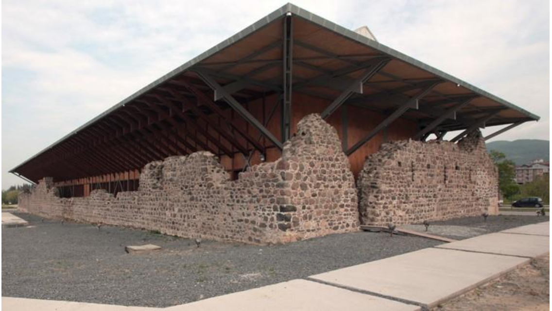
Şekil 2.12. Kazıklı Kervansarayı Restorasyon Sonrası (URL-9).
