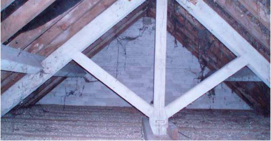
Şekil 2.40. Tarihi Çatılarda Yalıtım Uygulamaları (Historic England, 2011b).
