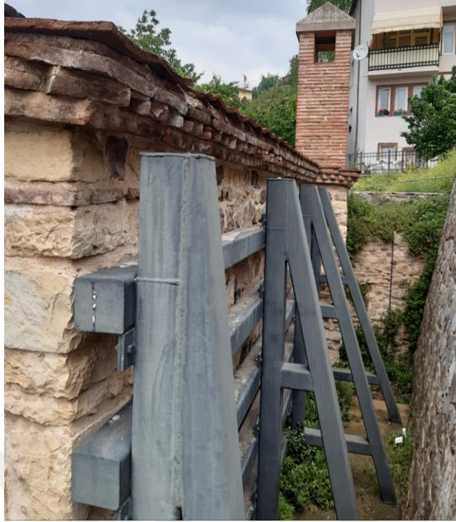
Şekil 3.10. Süleyman Paşa Hamamı Restorasyon Sonrası Arka Çephe Güçlendirmeleri (Kişisel Arşiv).
