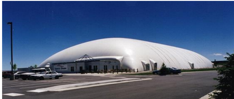
Şekil 3.7. Tek tabakalı şişme sistem (URL-16, 2019)
