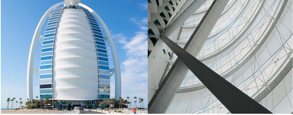
Şekil 3.11. Burj Al Arab tekstil cephesi (URL-22, 2020)
