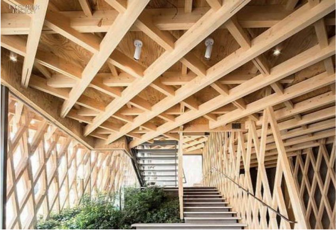
Şekil 3.12. Izgara ahşap strüktür (URL-23, 2020)
