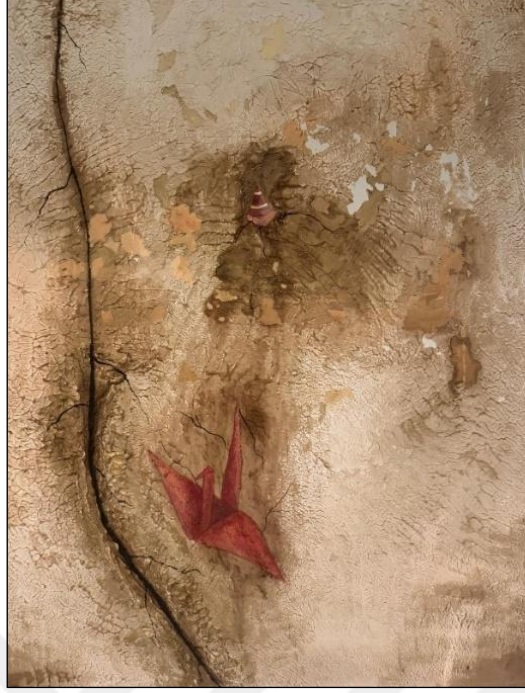
Fotoğraf 79: Bilgen Baysal Yıldırım, Çatlak, T.Ü.K.T, 2025.
