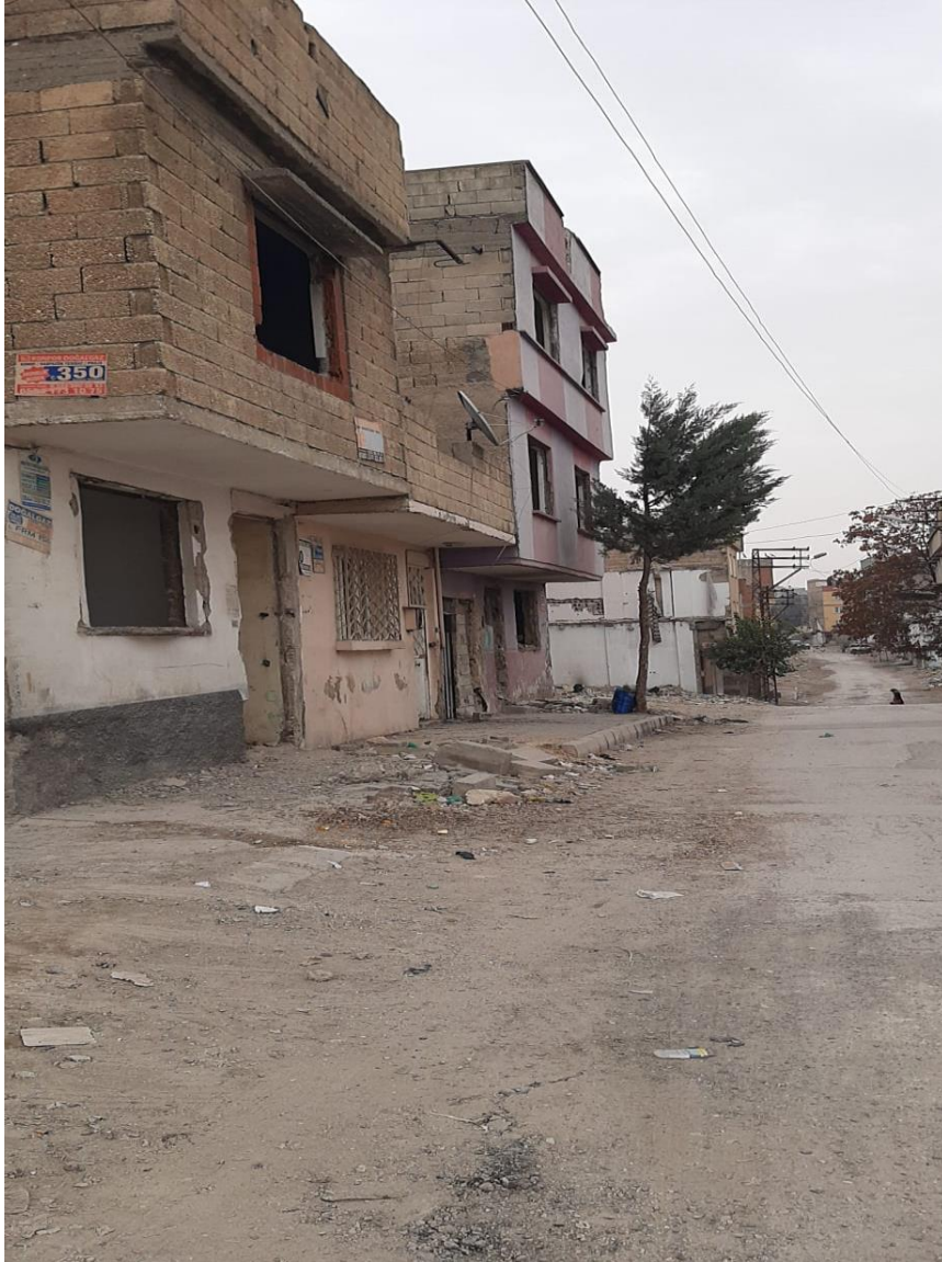
Fotoğraf 6 Karşıyaka Mahallesi'ndeki kentsel dönüşümden dolayı boşaltılan evler.
