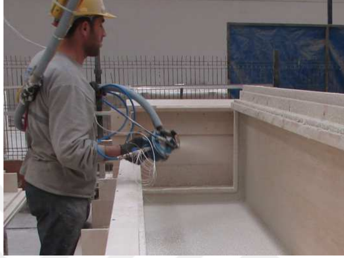
Şekil 4.2. El spreyi ile GFRC karışımın kalıba püskürtülmesi.
