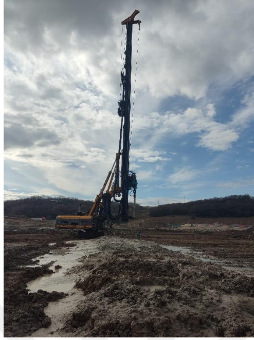
Şekil 3.6. Derin karışım yöntemi ile delgi yapıldıktan sonra terse dönerek takımın çekilmesi aşaması.
