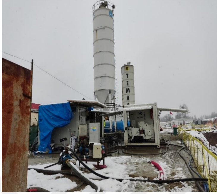
Şekil 3.10. Santral ve pompa ünitesi.
