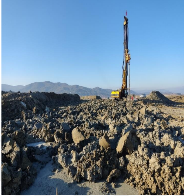
Şekil 2.6. Yalova ili DSM imalatı uygulaması.
