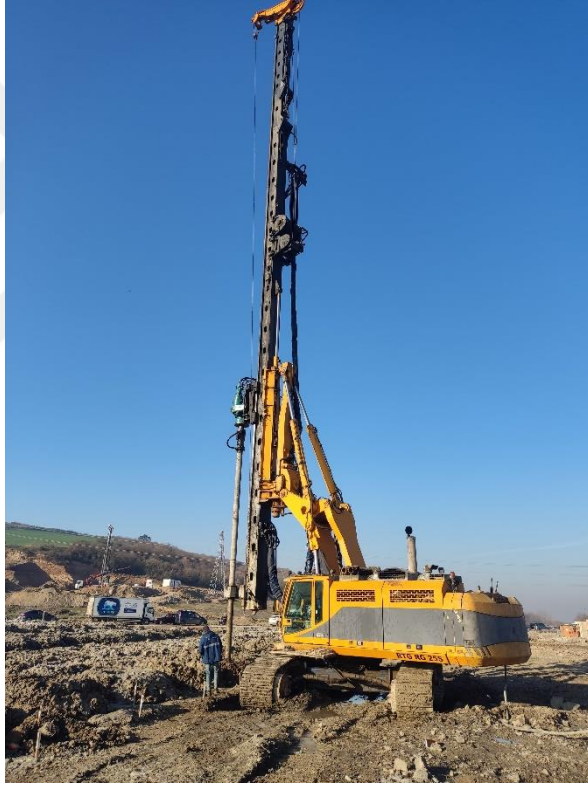
Şekil 2.5. İstanbul'da yapılan kesişen DSM imalatı delgi işlemi.
