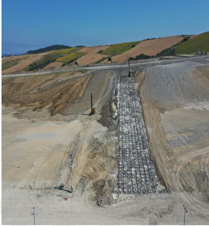
Şekil 5.4. Şantiye sahasına ait bir görüntü.
