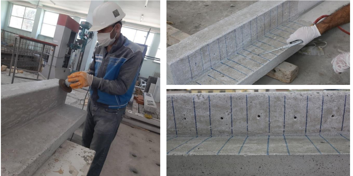
(Şekil 3.25.a). Beton yüzeyin düzeltilmesi ve ankraj deliklerinin delinmesi
