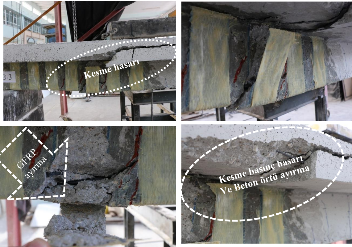
Şekil 4.11.TB-3 numunesinde oluşan hasarların görüntüsü
