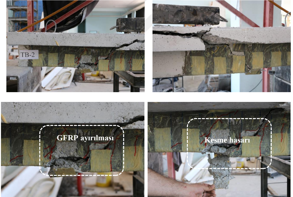
Şekil 4.9.TB-2 numunesinin oluşan hasarların görüntüsü
