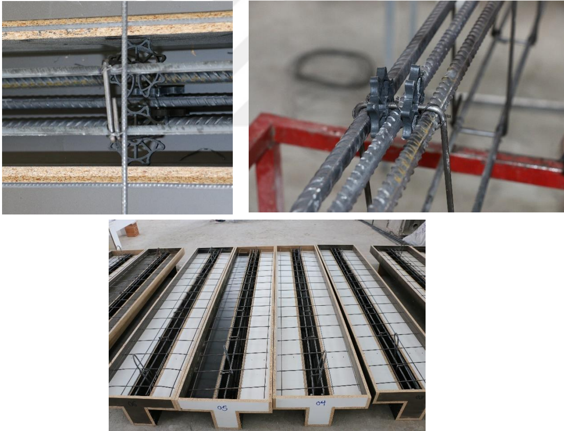
Şekil 3.6. Donatı ve plastik pas payı montajı
