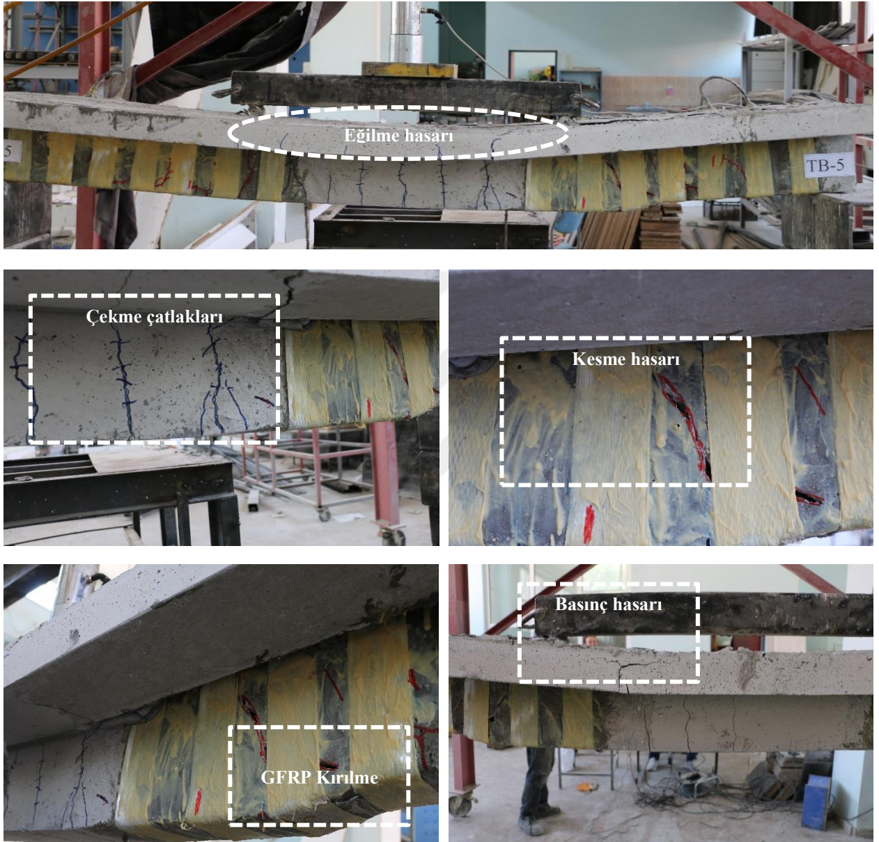
Şekil 4.15. TB-5 numunesinde oluşan hasarların görüntüsü
