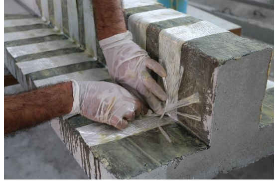
Epoksi malzemelerinin eklenmesi
