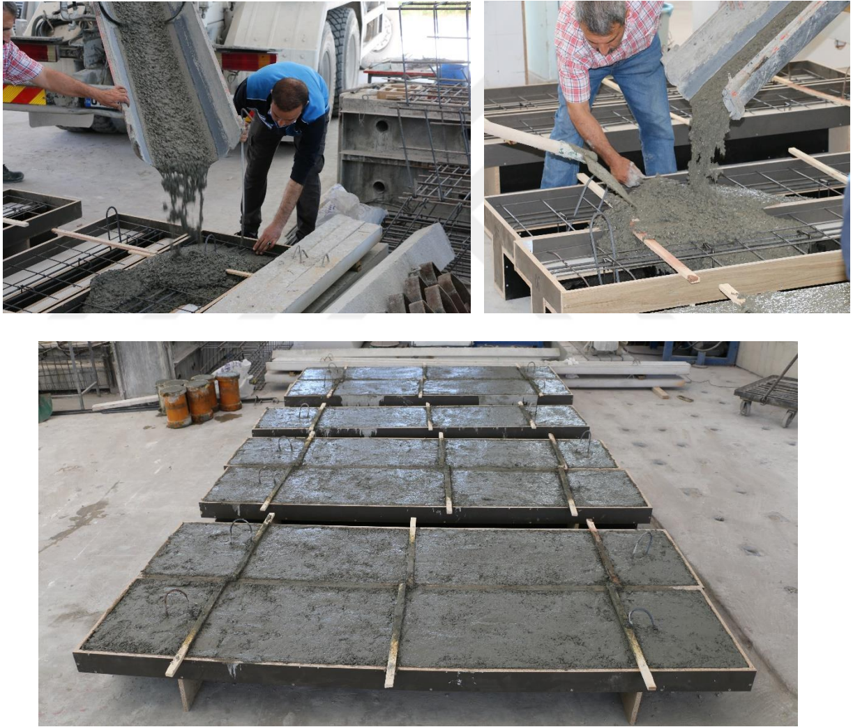
Şekil 3.7. Kalıplara beton dökme işlemi
