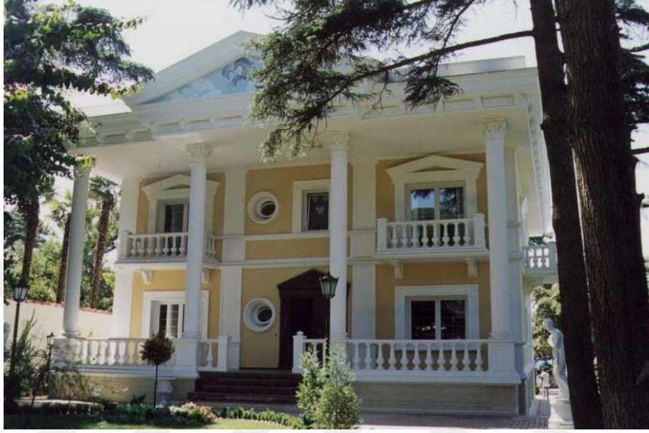
Şekil 2.35. GRC-CTB Dekoratif cephe elemanları kullanılmış bir yapı.
