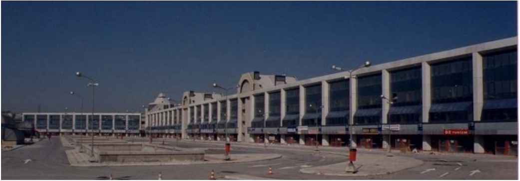
Şekil 7.2. GRC-CTB cephe kaplama uygulaması.
