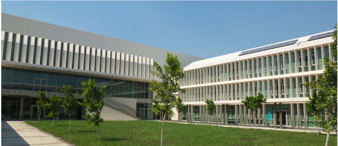
Şekil 7.10. GRC-CTB kendinden renkli narin lamel uygulaması.
