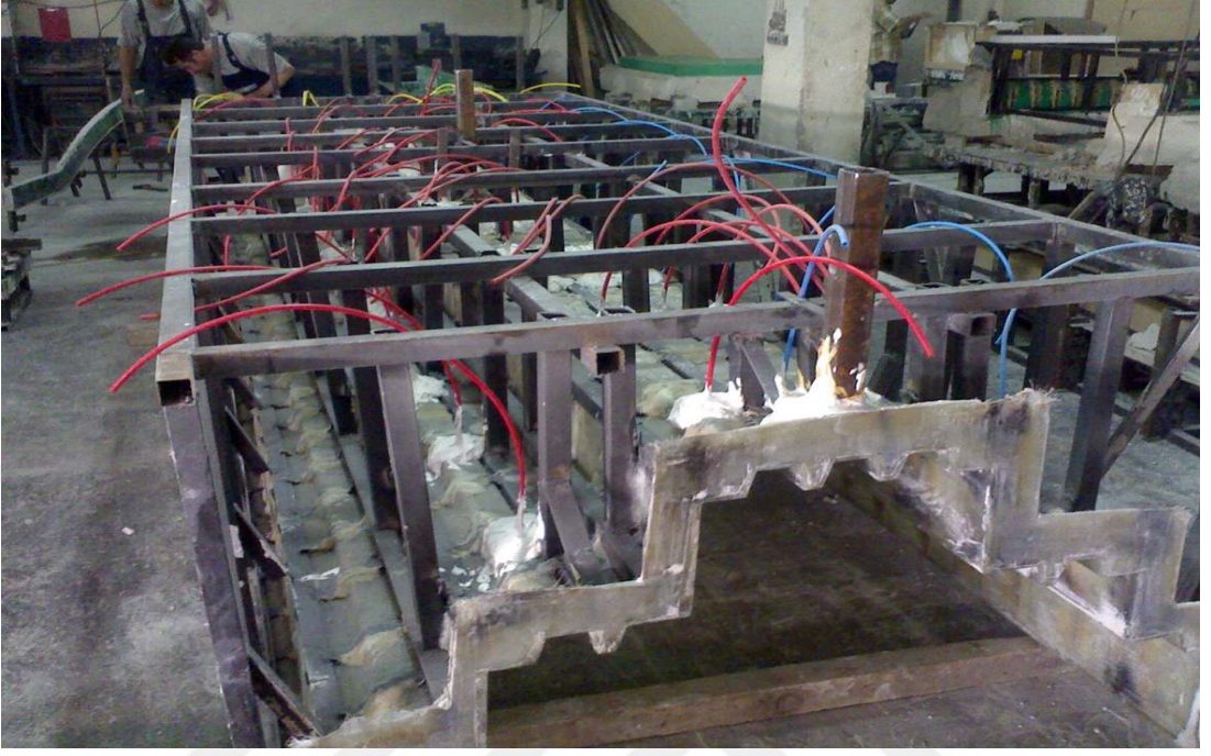
Şekil 2.16. Poliüretan kalıp dış destek ünitesi hazırlanması.
