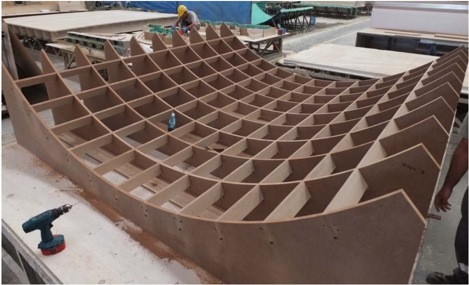
Şekil 2.17. Ahşap eğrisel kalıp yapımı.
