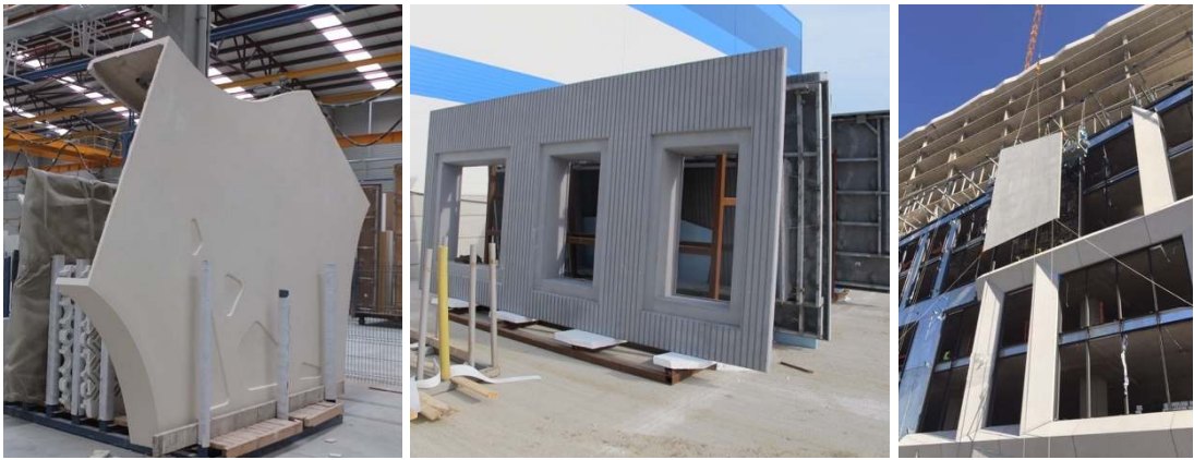
Şekil 2.34. GRC-CTB Cephe panelleri ve uygulaması.
