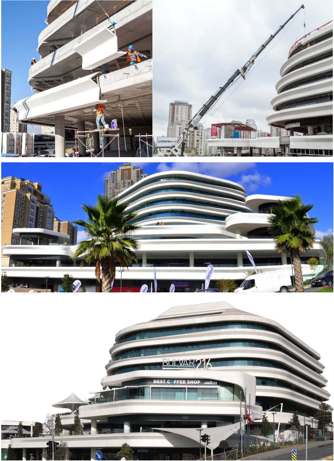
Şekil 7.11. GRC-CTB eğrisel ve çift eğrilikli yüzey kaplamaları.
