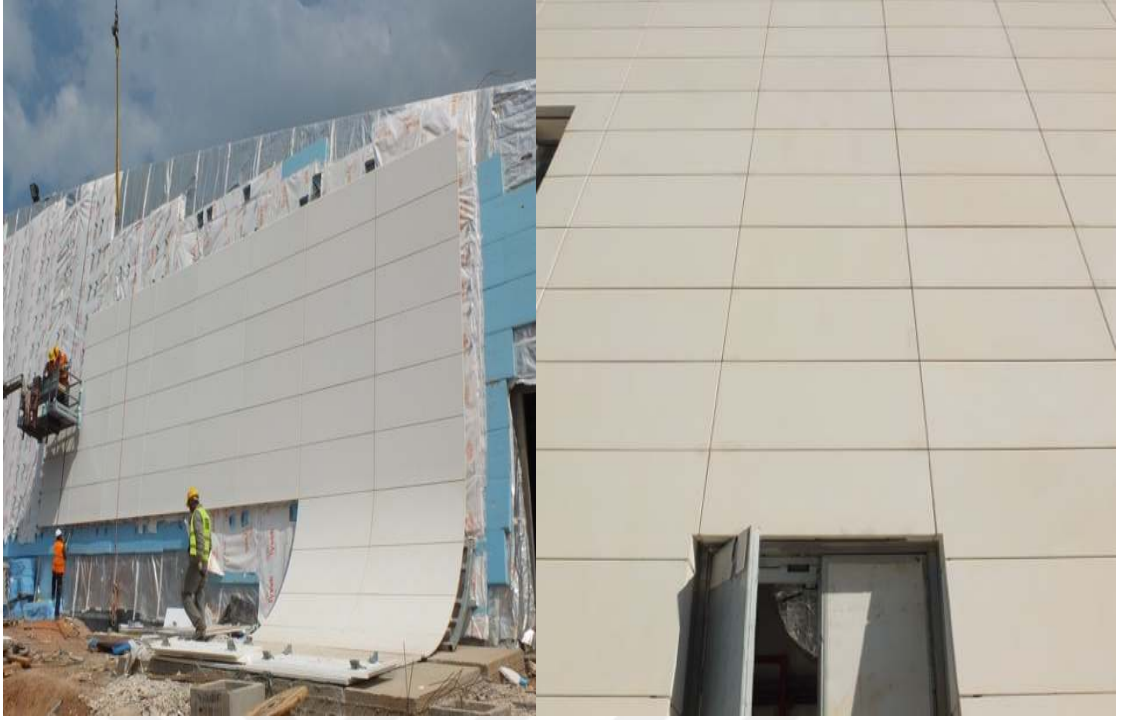
Şekil 2.29. Kendini temizleyen yüzeyli GRC-CTB uygulaması TÜPRAŞ RUP binası Kocaeli [58].
