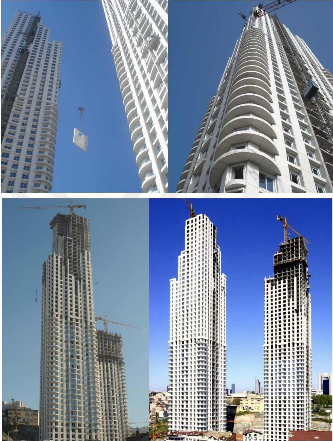
Şekil 7.8. GRC-CTB kendinden yalıtımlı panel kaplama uygulaması.
