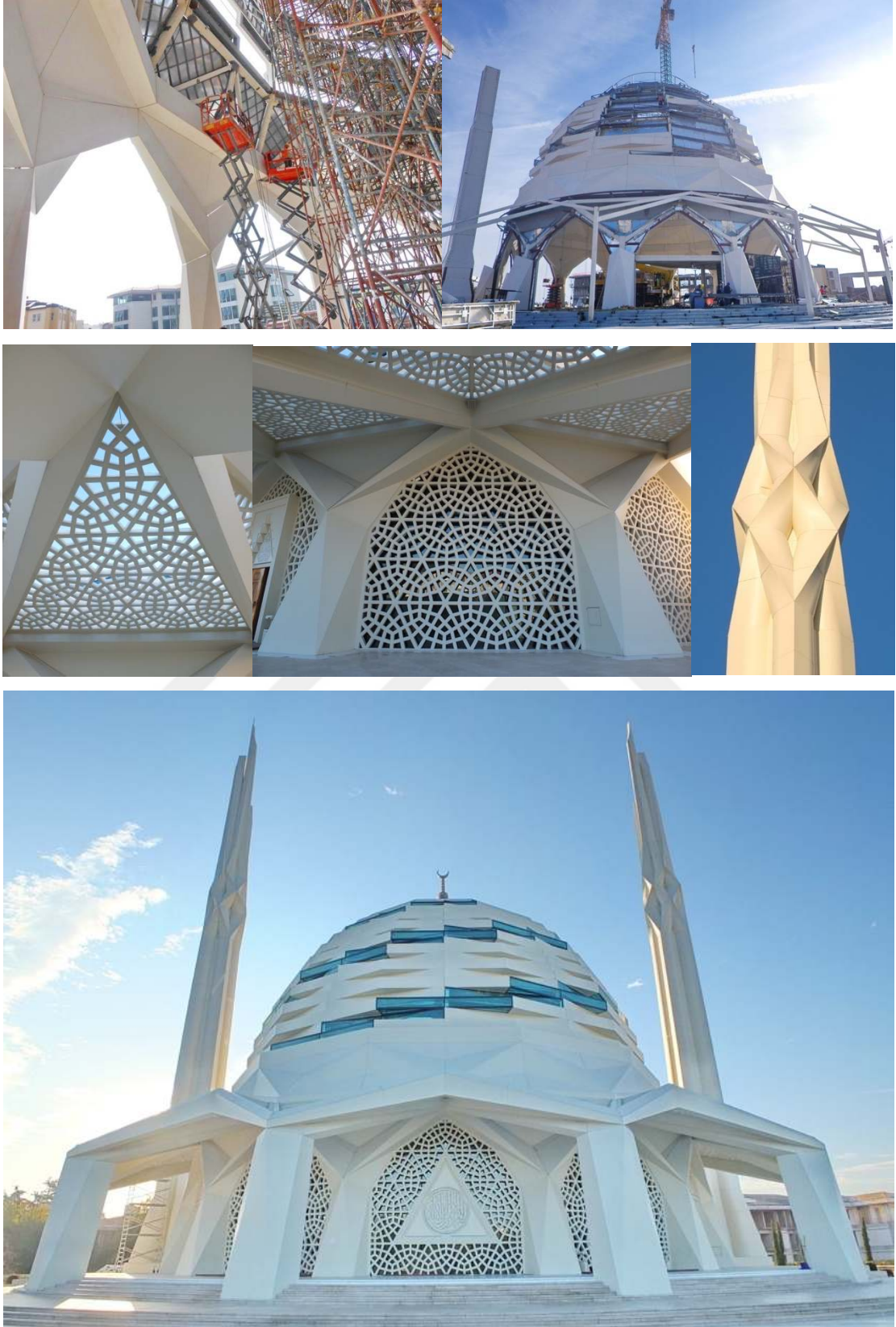
Şekil 7.13. GRC-CTB çelik taşıyıcı sisteme monte edilen kaplamalar.
