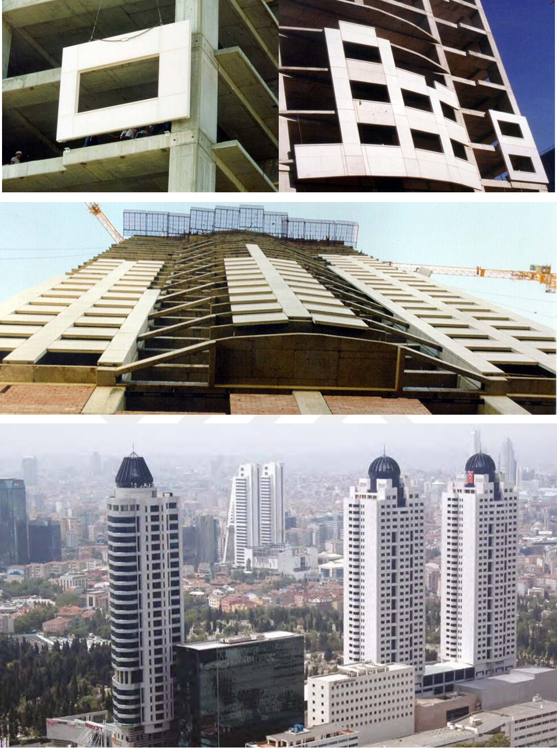
Şekil 7.3. GRC-CTB kendinden yalıtımlı panel kaplama uygulaması.
