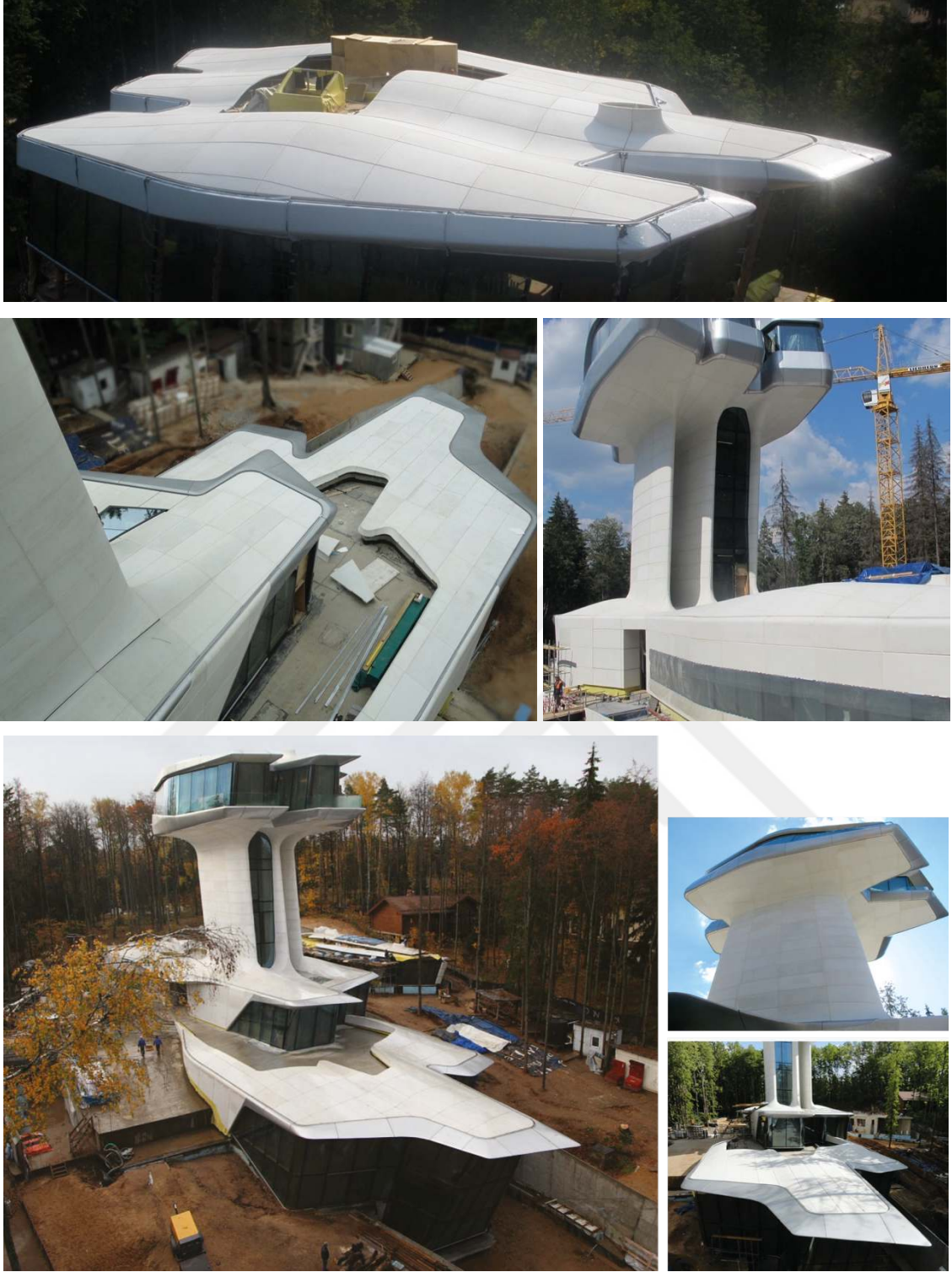
Şekil 7.9. GRC-CTB organik formlu kaplama uygulaması.
