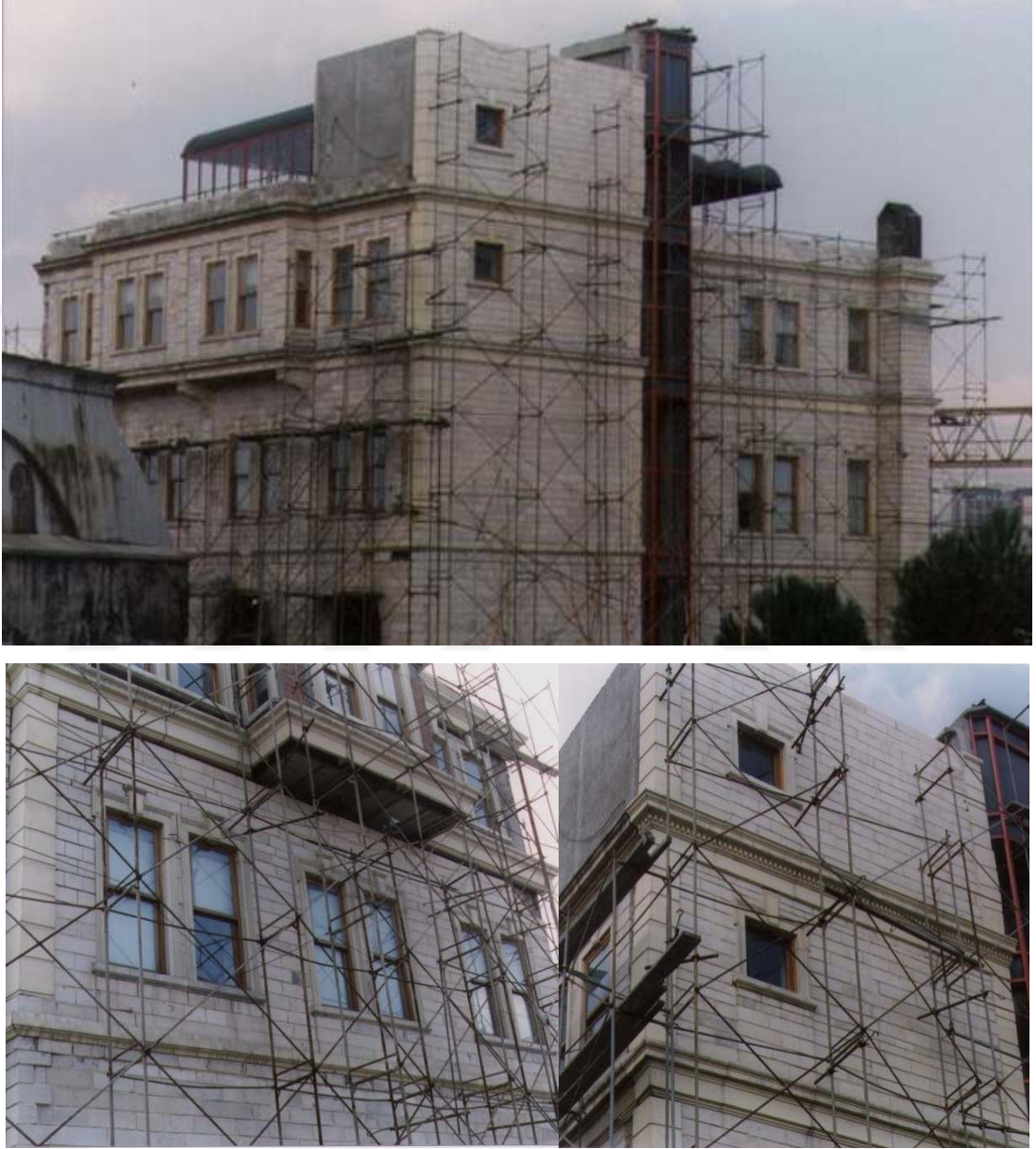
Şekil 7.1. GRC-CTB restorasyon uygulaması.
