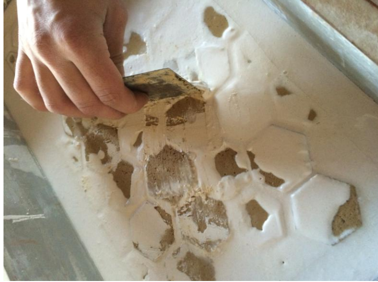
Görsel 4.8 Alçı fazlalığının temizlenmesi
