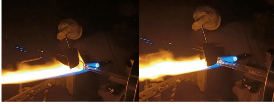
Görsel 4. 5. İki boru birleştirme
