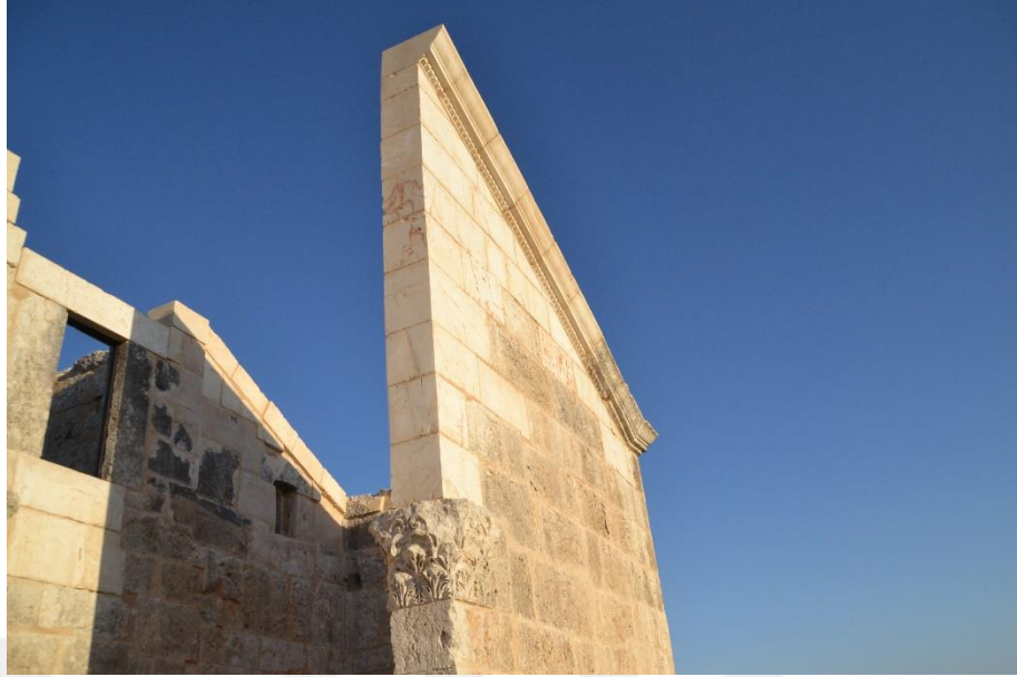
Fotoğraf 102. Batı cephesindeki alınlığın güney tarafında sağlam kalmış (yahut restorasyonda yenilenmiş) bölümü (Olba Kazı Arşivi)
