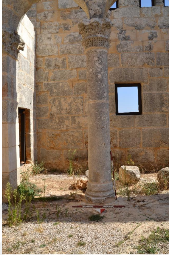
Fotoğraf 115. Güney revak düzenlemesindeki iki parçadan oluşan sütun gövdesi (Olba Kazı Arşivi)
