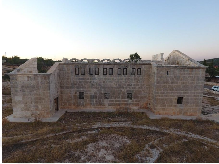
Fotoğraf 106. Çatı örtüsünü dolaşan silmeler (güney cephe) (Olba Kazı Arşivi)
