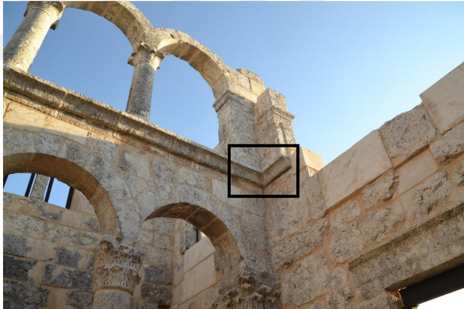
Fotoğraf 94. Revakları dolaşan silmenin güneybatı bölümündeki izleri (Olba Kazı Arşivi)
