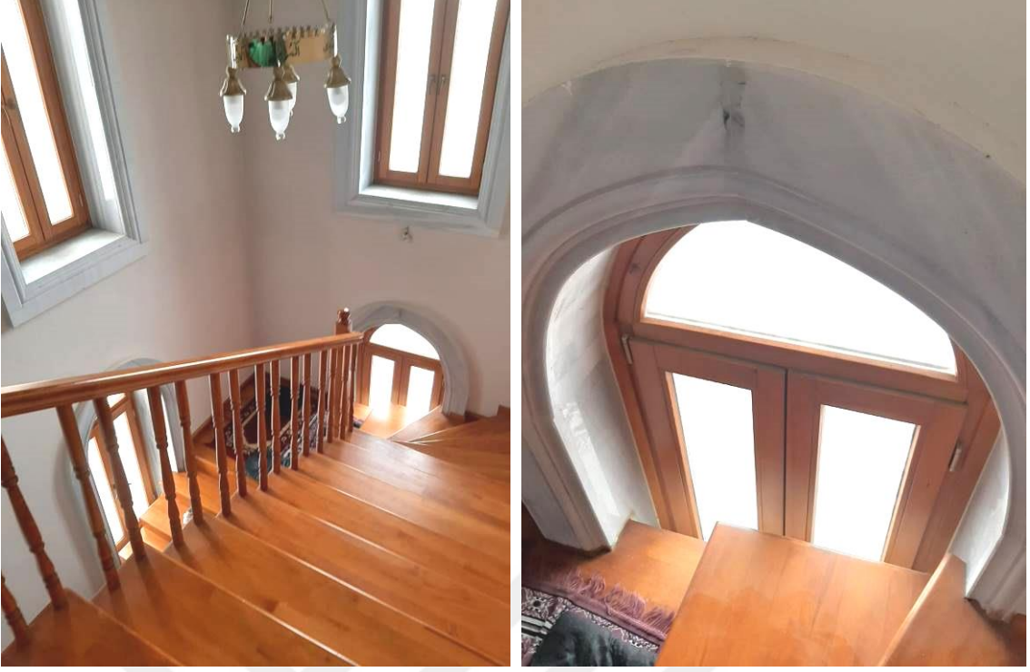
Şekil 3.29. Elmalılı Hamdi Yazır Cami içindeki hatalı pencere uygulaması (Azkur, 2023)
