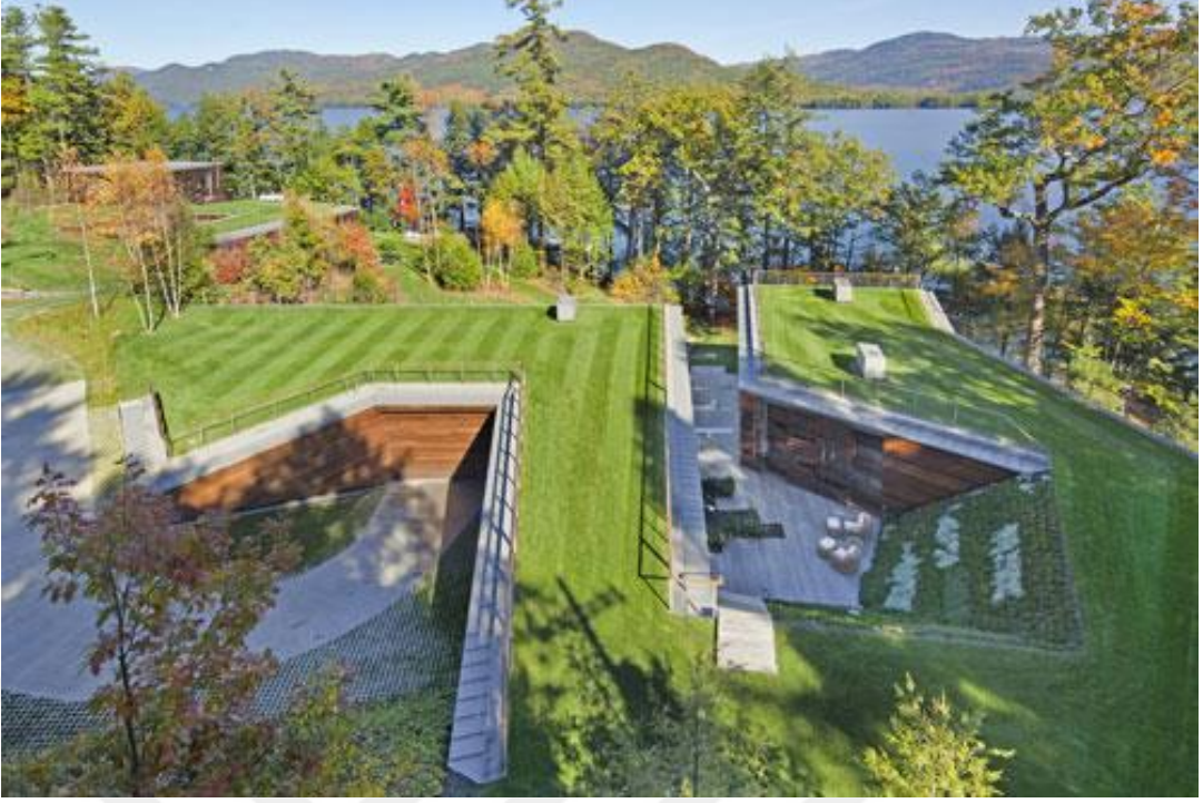
Şekil 2.14. Yeşil çatılı yapı (URL-1)
