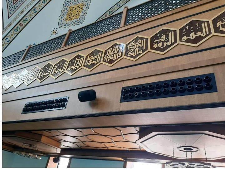
Şekil 3.23. Hz. Ebubekir Cami tavana gömülü iklimlendirme sistemi (Azkur, 2023)
