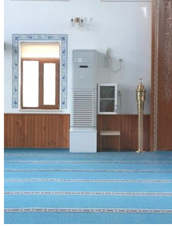
Şekil 3.14. Tevhit Camide kullanılan klima tipi (Azkur, 2023)
