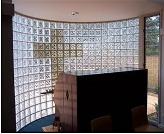
Şekil 2.11. İç mekanda kullanılmış eğrisel hatlar oluşturan cam tuğla duvar (Anonymous 8)
