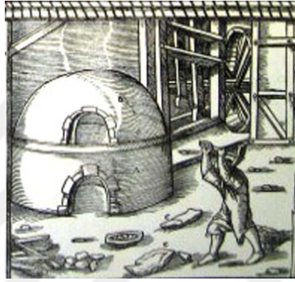
Görsel 2.10. Hammaddenin camsı hale gelmesi için kullanılan fırın (Küçükerman,98, Erişim Tarihi: 02.03.19)
