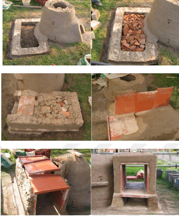
Görsel 2.3. Roman glassmakers isimli projede oluşturulan Roma tank tipi bir cam ergitme fırınına bitişik tavlama bölmesinin yapım aşamaları
