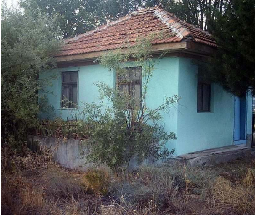
Fotoğraf 36: Hacı Kuşçu Efendi Türbesi (Ilgaz İlçesi-Cendere Köyü)
