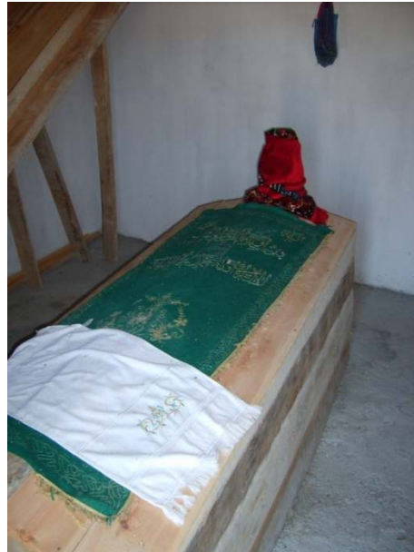
Fotoğraf 34: Eskice Köyü'nde yapımı devam eden türbe (İlgaz İlçesi-Eskice Köyü)
