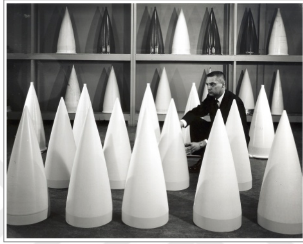
Şekil 2.19. Corning cam-seramik füze burun radomları [60].
