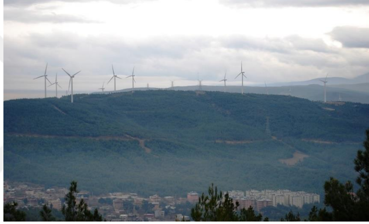
Şekil 2.2 Rüzgâr Enerji Santrali (İnt. Kyn. 2)
