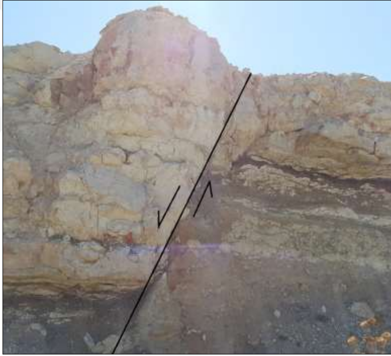
Şekil 4.11 Çokköy formasyonuna ait normal fay görüntüsü (Afşar köyü yakını ocak sahası, Lokasyon: 734540-4344223).
