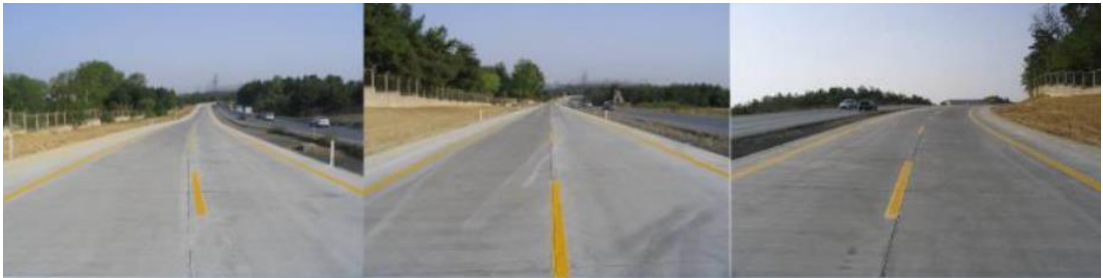
Şekil 4. Hasdal Kavşağı-Kemerburgaz beton yolu
