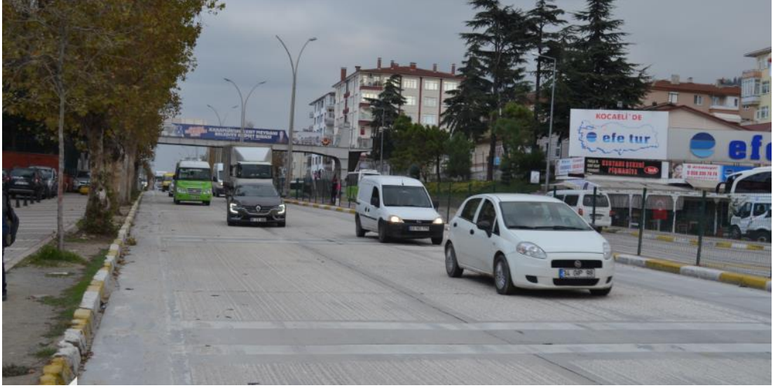
Şekil 6. Karamürsel şehir geçişi beton yol kesimi
