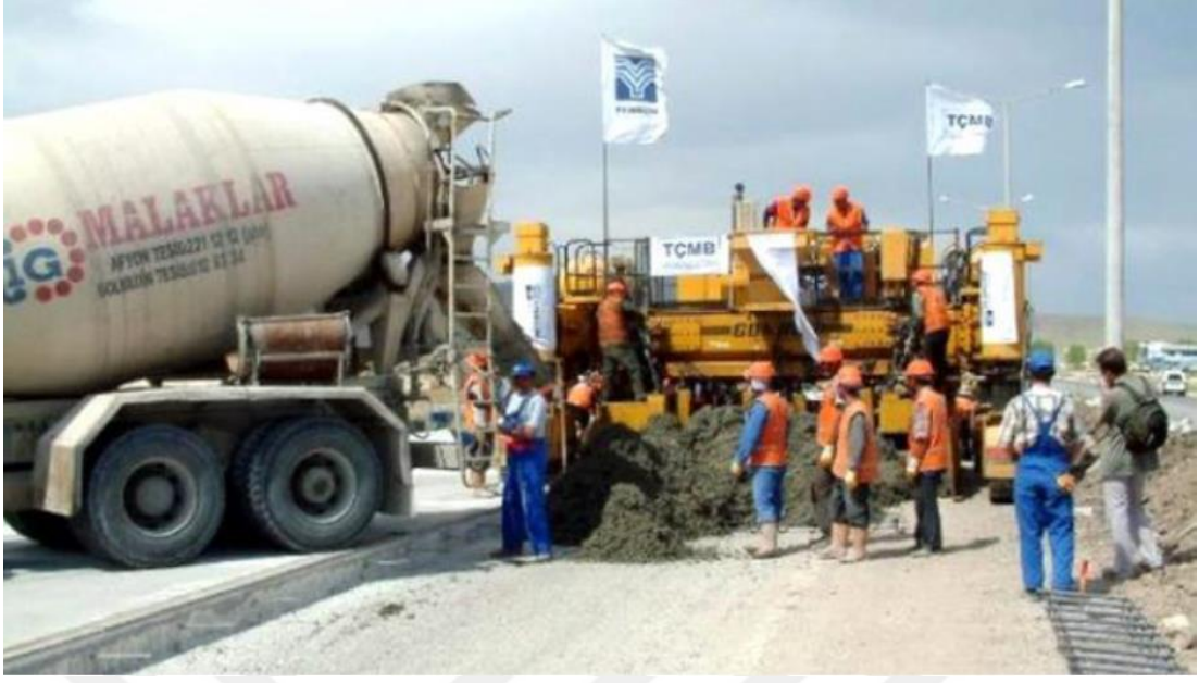
Şekil 3. Afyon-Emirdağ beton yol uygulaması
