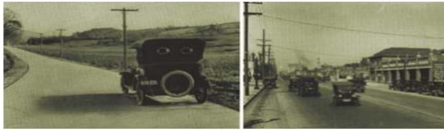
Şekil 2. Alt zemine sahip beton yollar
