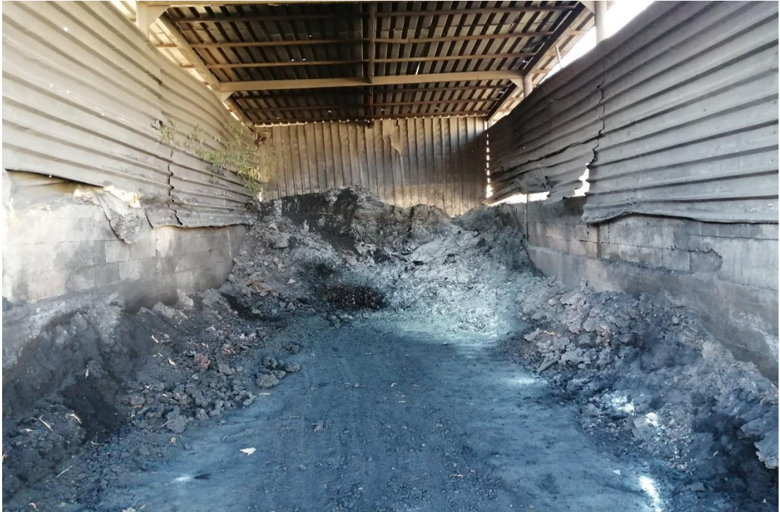
Şekil 9. KKA depolama ünitesi
