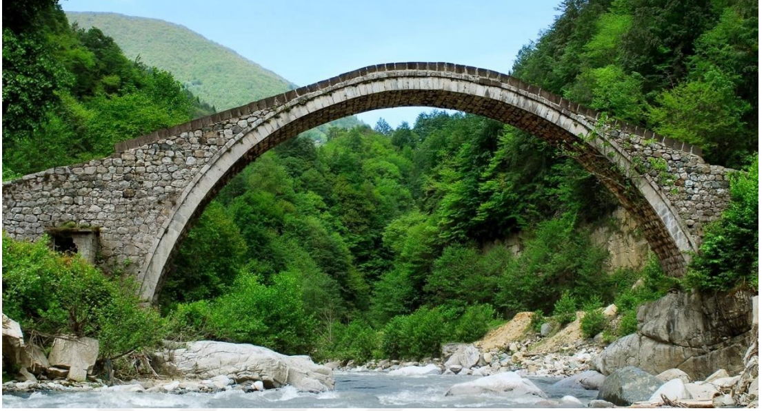
Fotoğraf 35: Kaptanpaşa-Yeşiltepe Taş Köprüsü
